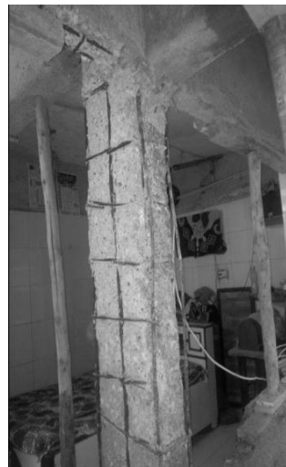
۱- شکل (اوسپنیز کانکریټي تخریب شوی
