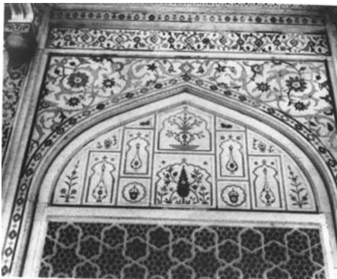
مشبک های ورودی
