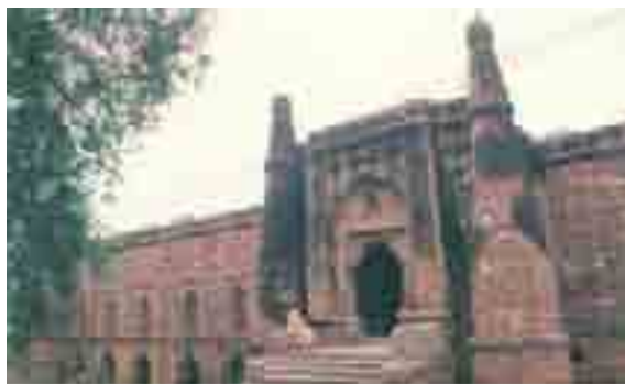
مسجد خیر کی، نمای ورودی
