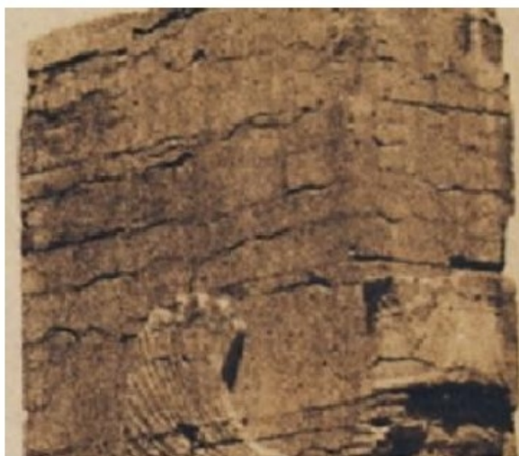
جرز سمت شمال شرقی دروازه ورودی تخت جمشید قبل از مرمت
