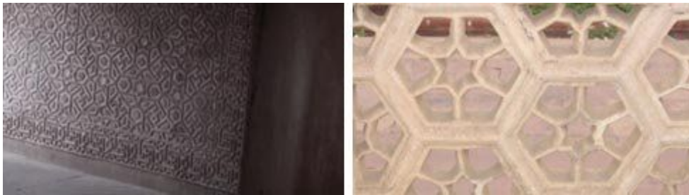
مشبک های ورودی
