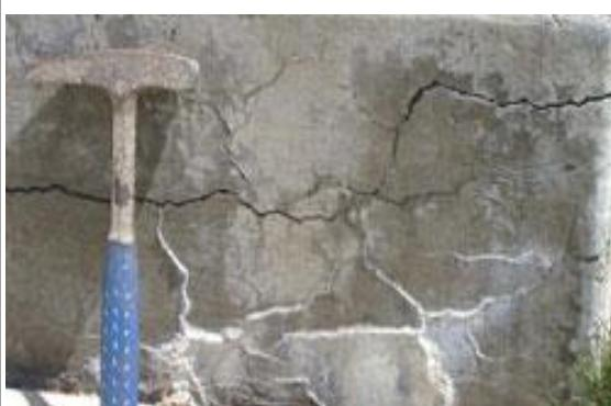
**Alkali-aggregate reaction:** (الفلي لرونکي جغل عکس العمل)
