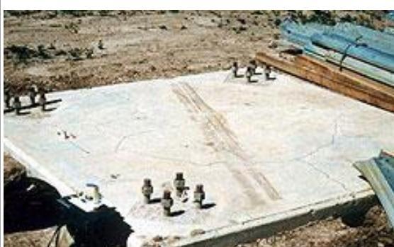
**Thermal cracks:** (حرارتی کریکونه)
