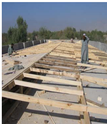
(پورته) اوار کانکریټی بام په قبری غشا او تېرو پت شوی. (پورته ښی طرف ته) د بام کم مائل چوکاټ په کانکریټی slab باندی.
