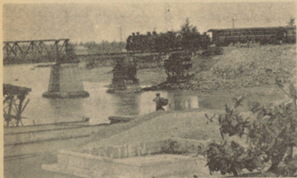
در قسمت ترمیم واحداث جاده‌ها در ویتنام شمالی به شدت کار می شود
