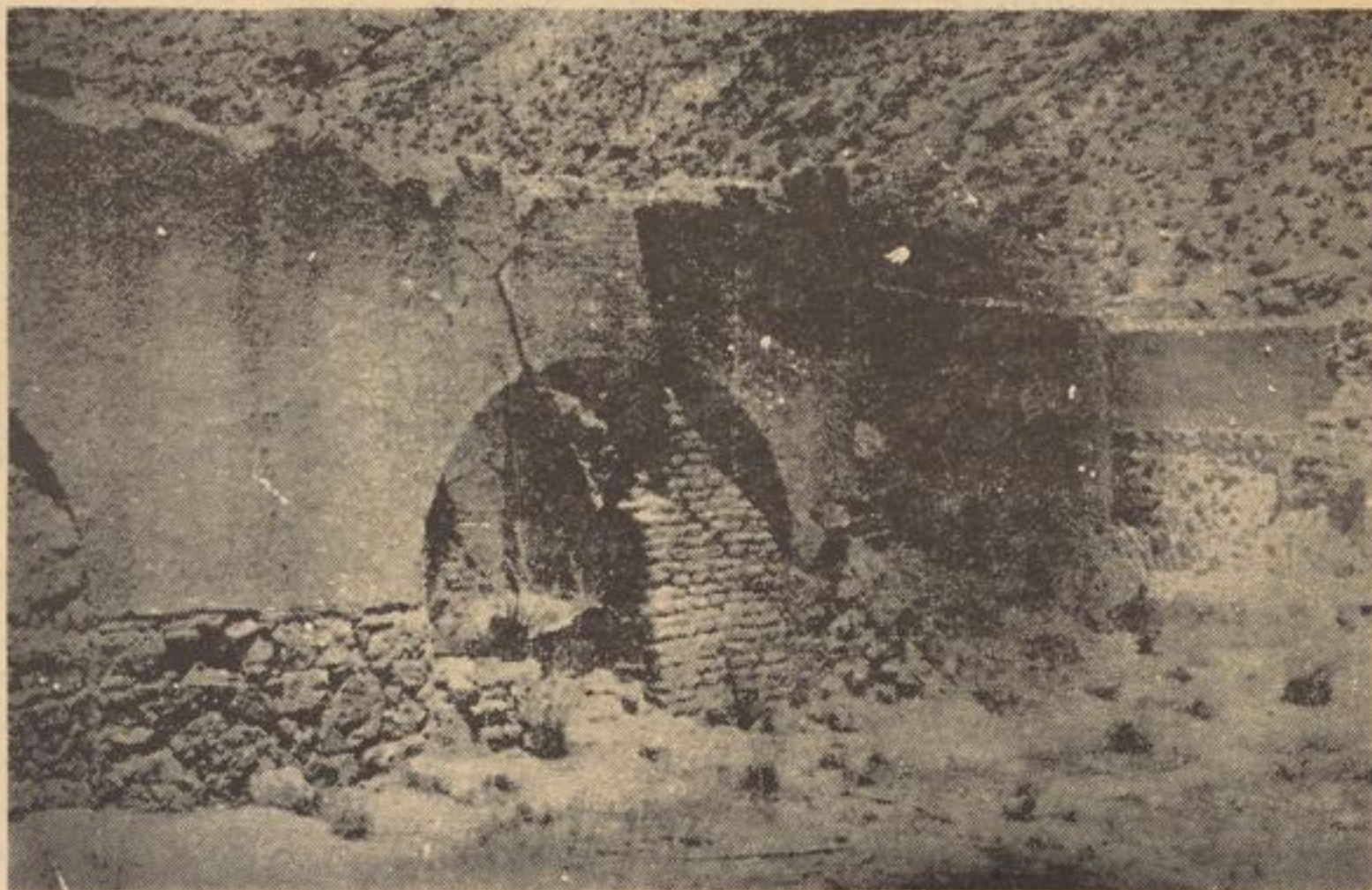
نمایی از خرابی های زلزله در دره آجر
