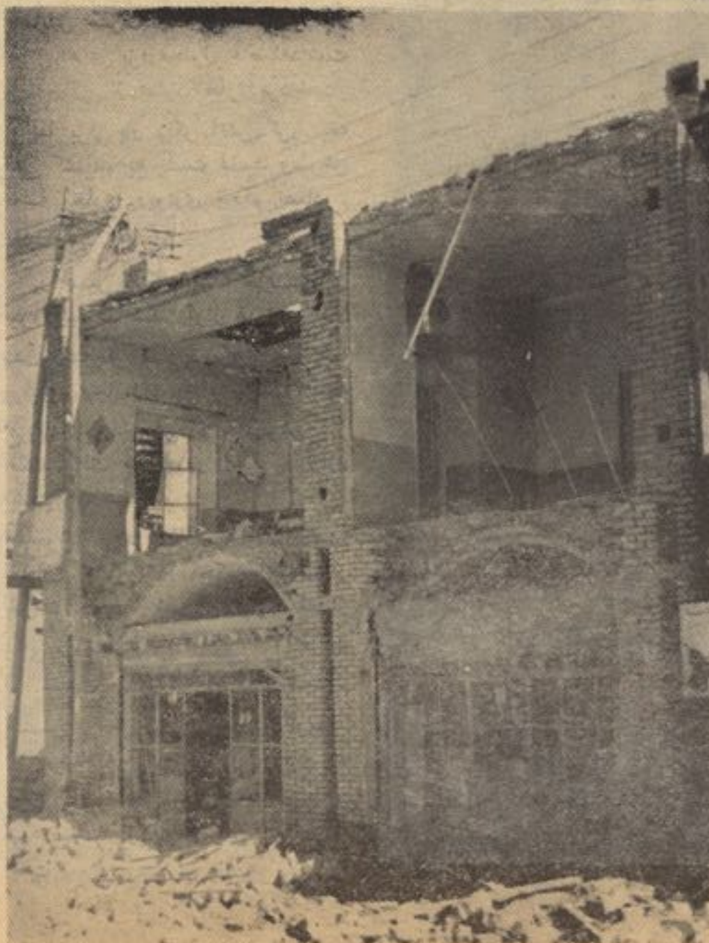
اثری از تکان های زلزله در یکی از منازل
