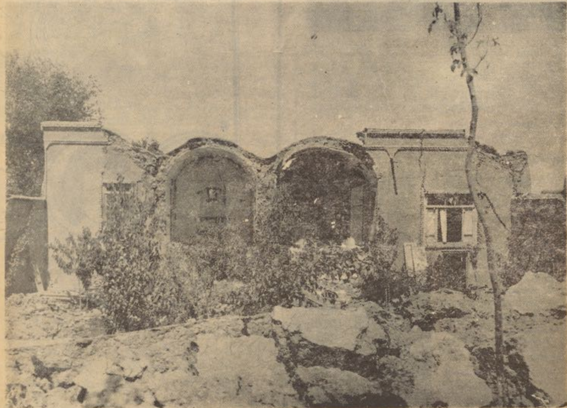
نمایی از خرابی های زلزله به مازل مسکونی
