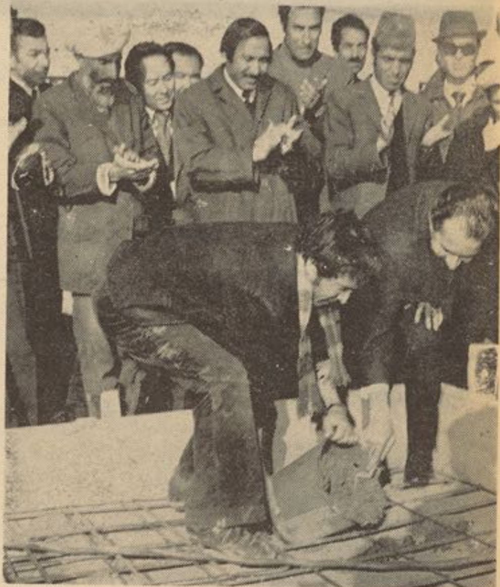
بنامی یو هاند داکتر نوین وزیر اطلاعات و کلتور چینیکه سنگ تهداب عمارت جدید انوزارت را میگذارند.
