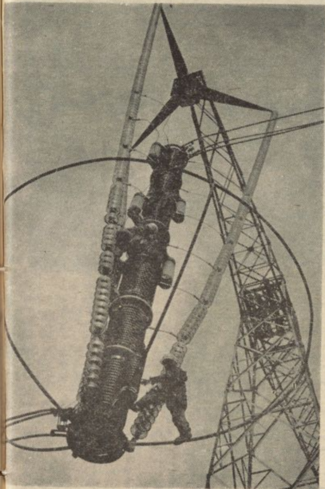
انتقال انرژی برقی ولتاژ های بلندتر که میتواند میلیون ها کلیوات برقی را ذخیره کند البته موجودیت لین های جدید و مقاوم برق ختم است
