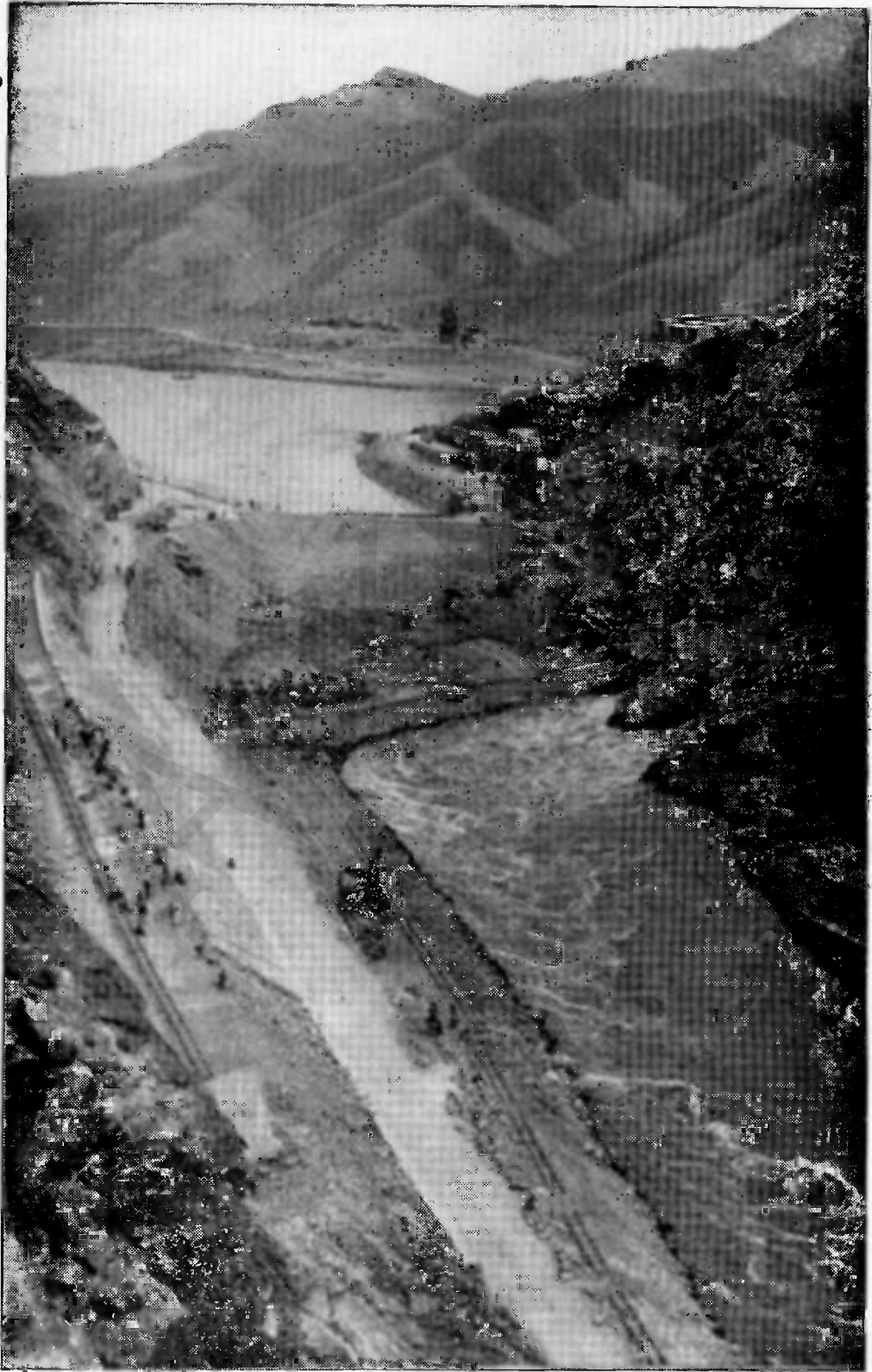
بند خامه که بقرض احداث بند جدید تعمیر شده
