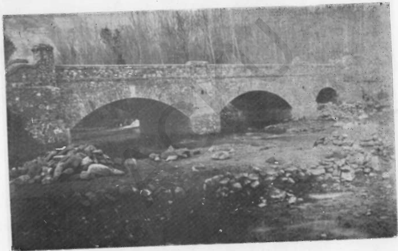
پل گل باغ تعمیر سال ۱۳۱۲ Le Nouveau pont de Gol-Bagh (KABOUL)
