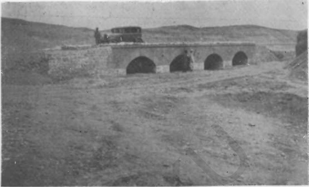
پل چوره گلی سمت مشرق Le Pont de TCHORA-GALI sur la Route Kaboul-Indes.
