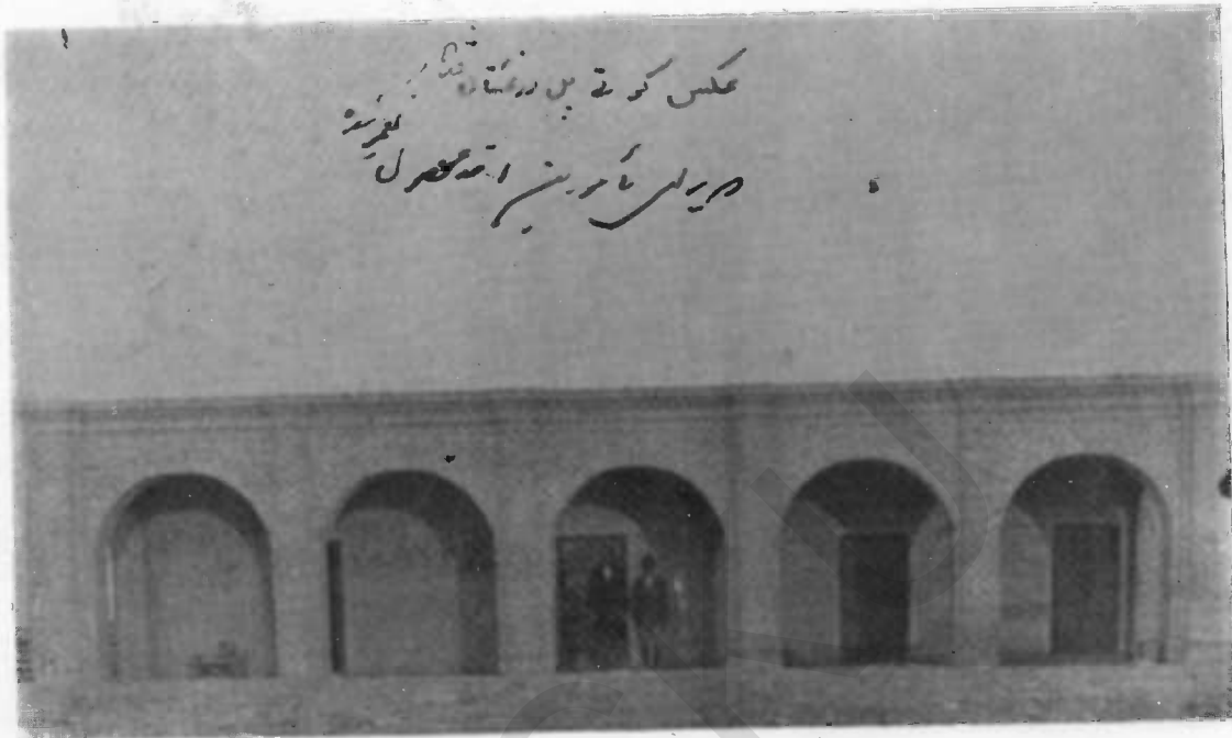
Type des nouveaux postes de Police à Kandahar.
