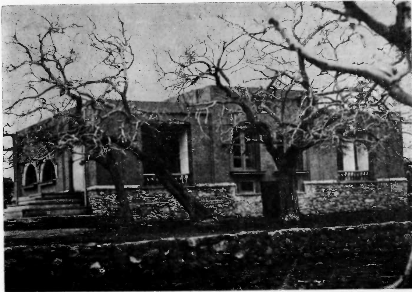
یکی از اطاق های دایره فرقه مشر عسکری در علاقه وزیر - جلال آباد Un des Bâtiments, Construits en 1312, pour les Offic ers de la Province de l'Est à VAZIRI (Djelahabad).
