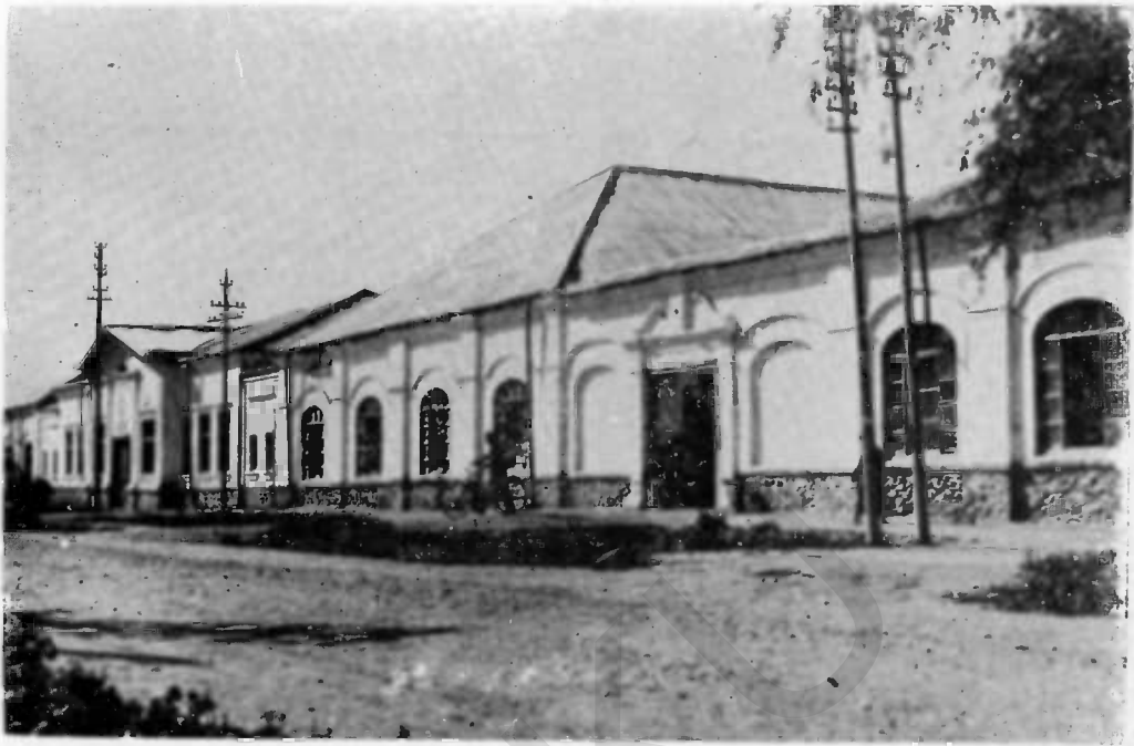
عمارت جدید مطبعه عمومی در کابل Nouveaux Bâtiment de l'Imprimerie Générale à Kaboul
