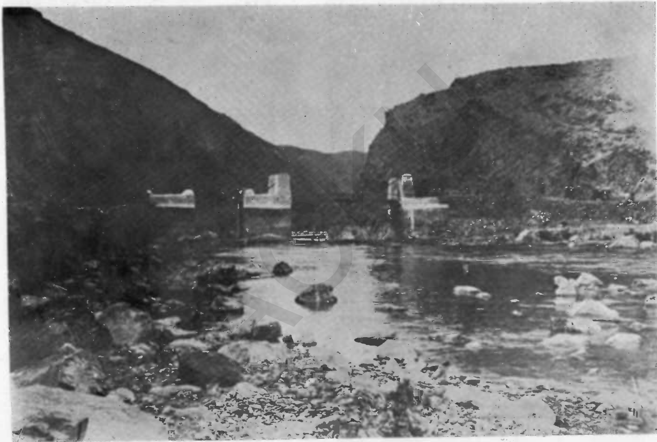
پل جدیدیکه در حدود چشت تعمیر شده Pont en fer nouvellement construit à TCHECHT (Hérat) • (Vue d'ensemble)
