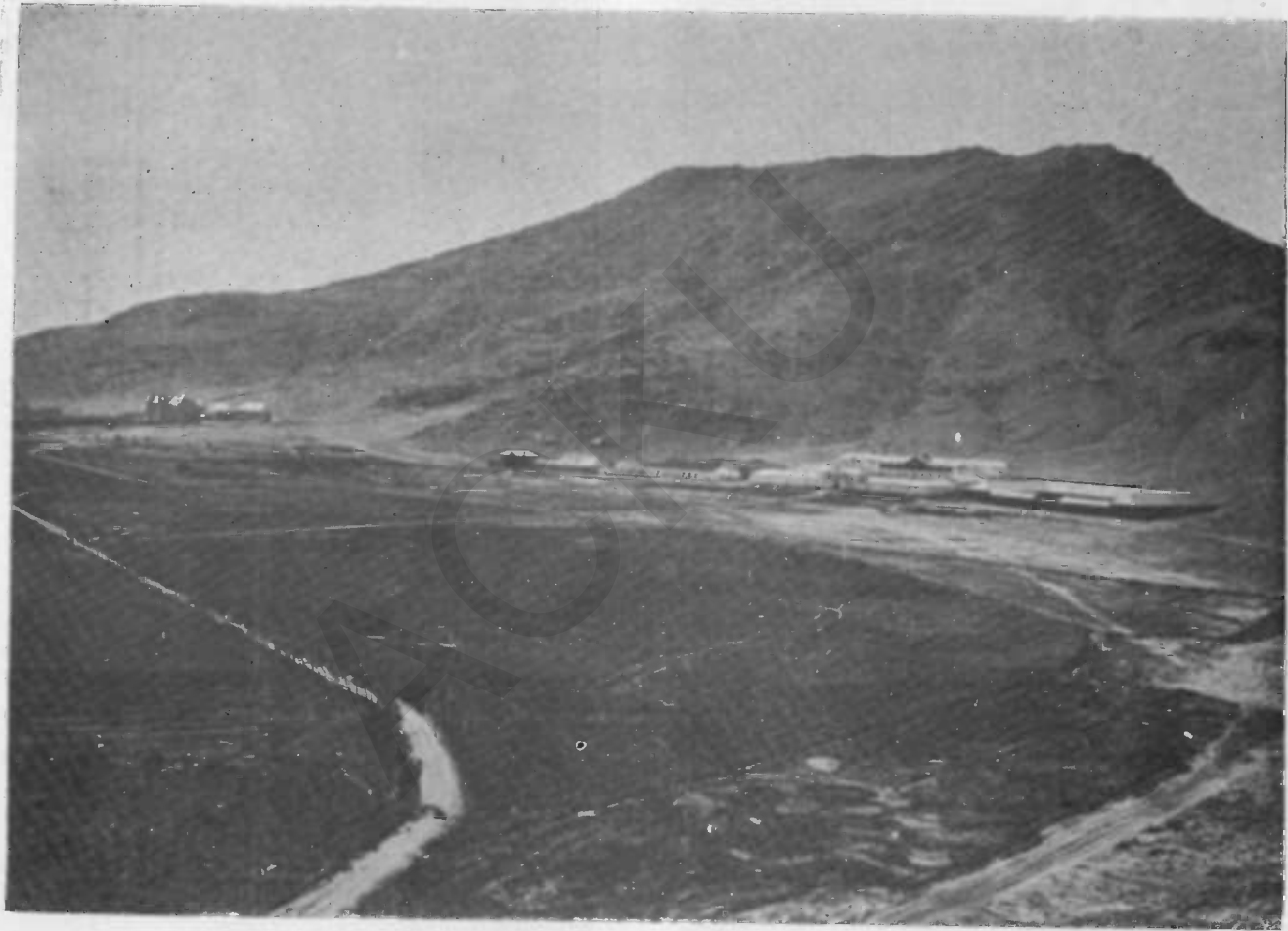
عمارت ریاست نسل گیری و تربیه حیوانات واقع علی آباد ( کابل ) Nouveaux Établissements de Zootechnie et de Sélection à Kaboul.
