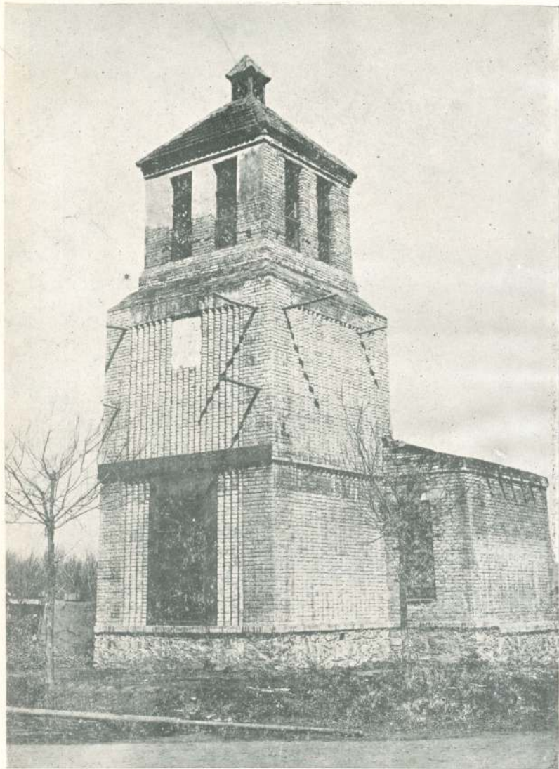
از عمرانات سال ۱۳۱۰ وزارت فوائد عامه در کابل : برج برق متصل وزارت حربيه . Type des stations électriques nouvellement construites à Kaboul
