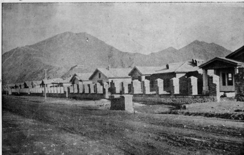
از مناظر نوی کابل : قسمتی از آ پار تمان های جدید التعمیر
