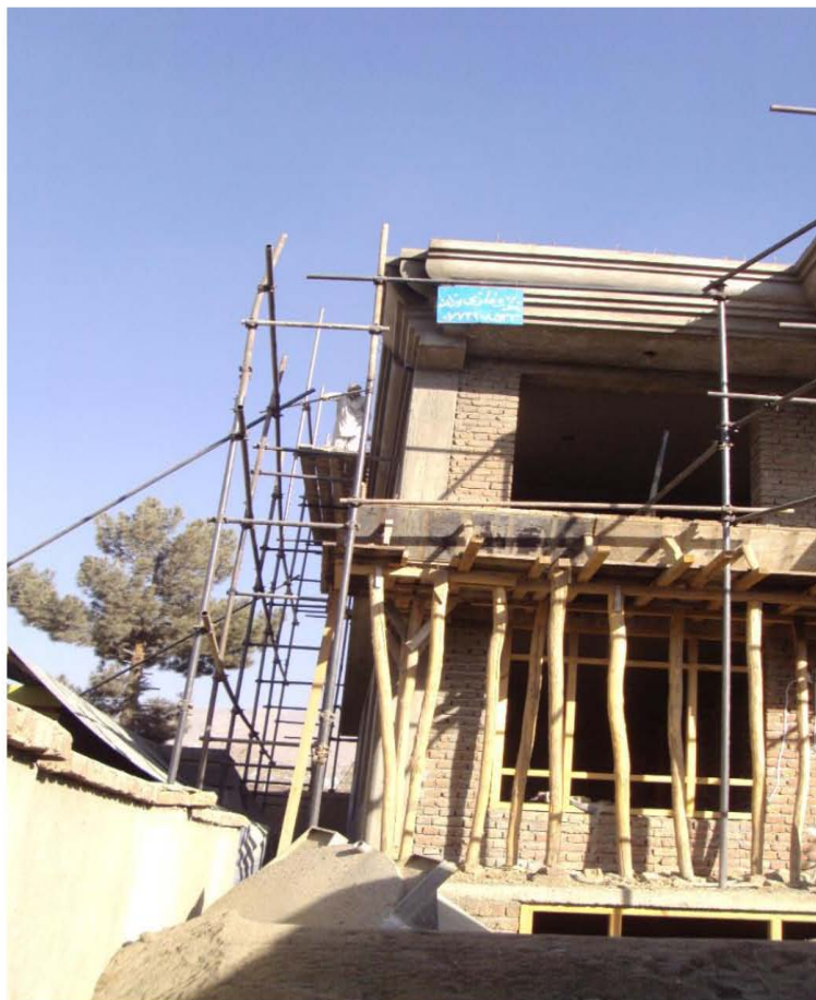
نمای قسمت تعمیر ره‌ایشی واقع حصه سوم خیر خانه ( کابل )
