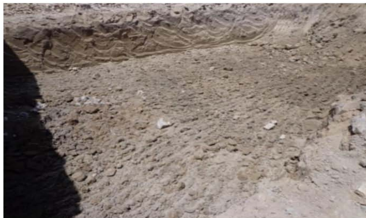
تصویری از کند نکاری ساحه برای تهکوی مطابق نقشه های انجینری ساختمان و انتقال خاک اضافی از ساحه (موقعیت پروژه - شهر کابل)
