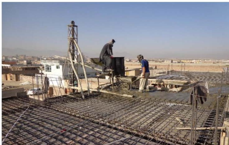
تصویری از پایپ دوانی برای برق داخلی مطابق نقشه های انجینری ساختمان (موقعیت پروژه - شهر کابل)
