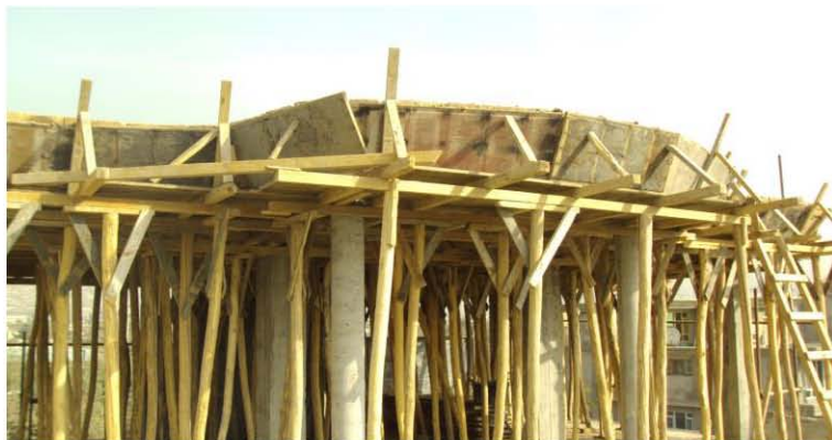
نمای قسمت تعمیر رهایشی واقع ارزان قیمت ( کابل)
