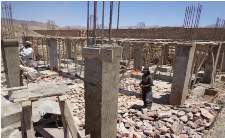
تصویری از آماده گی برای قالب بندی پوشش مطابق نقشه های انجینری ساختمان (موقعیت پروژه - شهر کابل)
