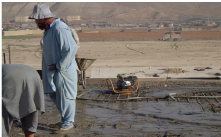
تصویری از کانکریت ریزی ساده (بدون کانکریت پمپ) مطابق نقشه های انجینری ساختمان (موقعیت پروژه - شهر کابل)
