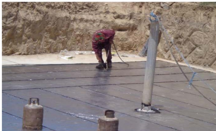
تصویری از عایق کاری ساحه برای تهکوی مطابق نقشه های انجینری ساختمان (موقعیت پروژه - شهر کابل)
