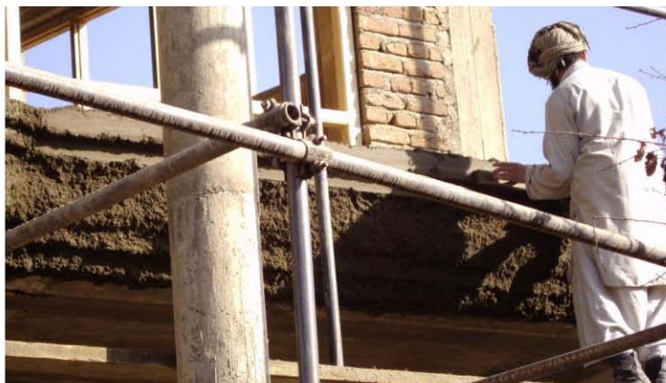
نمای قسمت تعمیر راهپشی واقع حصه دوم خیر خانه ( کابل)
