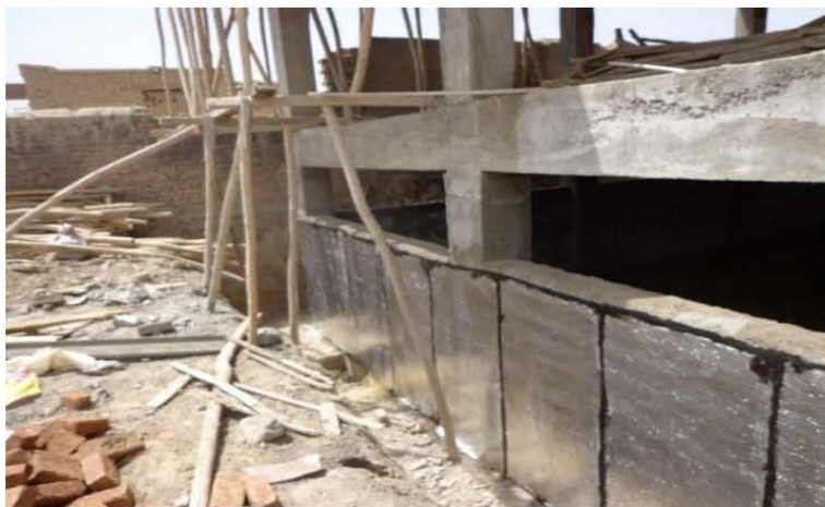
تصویری از عایق کاری دیوار های خارجی مطابق نقشه های انجینری ساختمان (موقعیت پروژه - شهر کابل)
