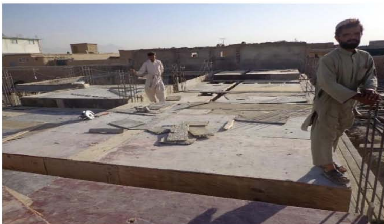
تصویری از قالب بندی پوشش مطابق نقشه های انجینری ساختمان (موقعیت پروژه - شهر کابل)
