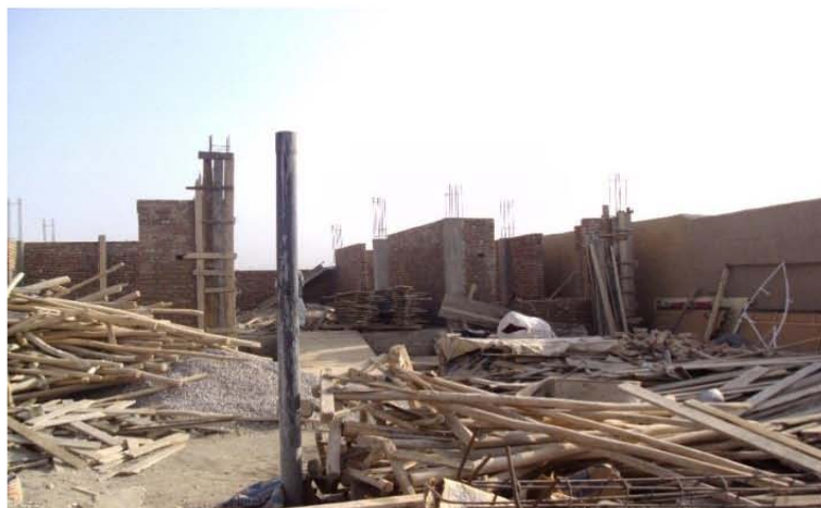
قسمت تعمیر رهائشی واقع رحمن مینه ( کابل )
