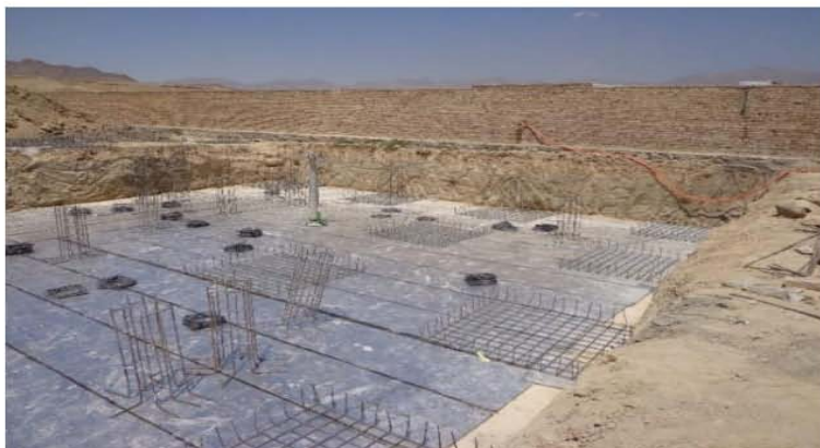
تصویری از سیخ بندی برای تهداب های تهکوی مطابق نقشه های انجینری ساختمان که باید با دقت صورت گیرد (موقعیت پروژه - شهر کابل)
