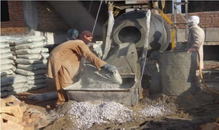
تصویری از مخلوط کانکریت مطابق نقشه های انجینری ساختمان (موقعیت پروژه - شهر کابل)
