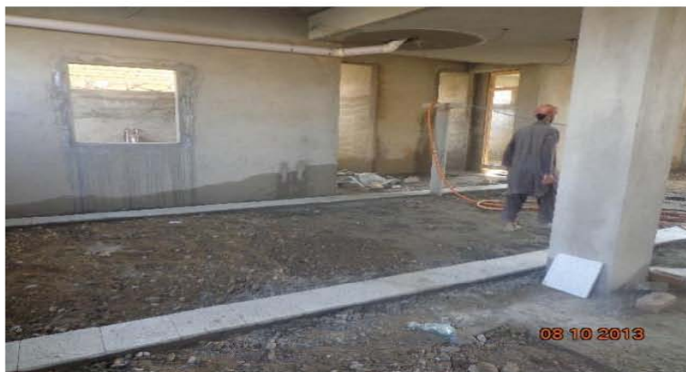
تصویری از نصب سنگ تراسو در فرش ها مطابق نقشه های مهندسی (موقعیت پروژه - شهر کابل)
