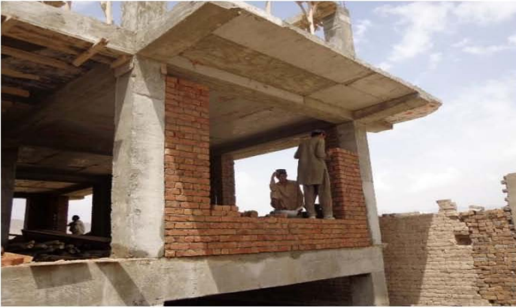
تصویری از خشت کاری خارجی مطابق نقشه های انجینری ساختمان (موقعیت پروژه - شهر کابل)
