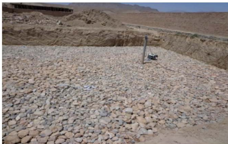
تصویری از جغل فرش ساحه برای تهکوی مطابق نقشه های انجینری ساختمان (موقعیت پروژه - شهر کابل)
