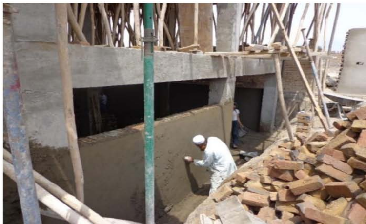
تصویری از پلستر کاری مطابق نقشه های انجینری ساختمان (موقعیت پروژه - شهر کابل)
