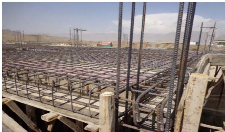
تصویری از سیخ بندی پوشش مطابق نقشه های انجینری ساختمان (موقعیت پروژه - شهر کابل)
