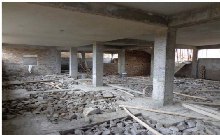
تصویری از پر کاری فرش ها مطابق نقشه های انجینری ساختمان (موقعیت پروژه - شهر کابل)
