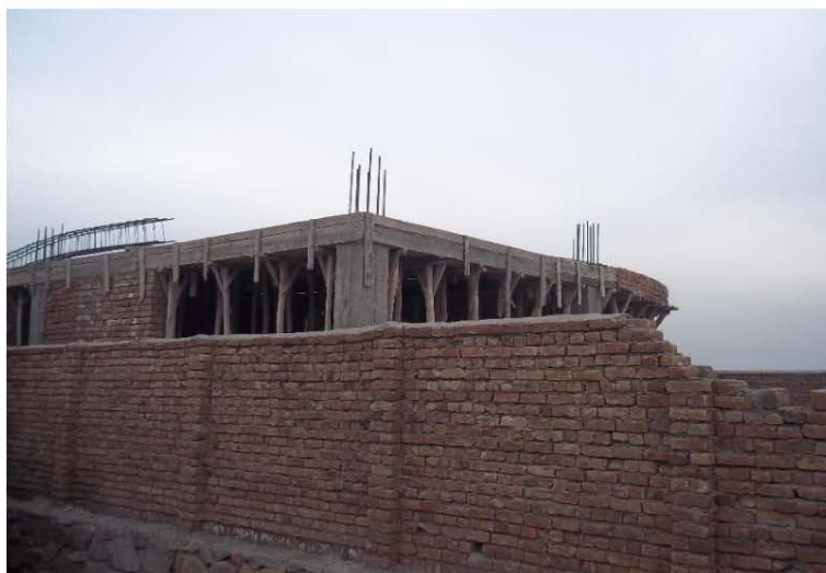
نمای تعمیر رهایشی واقع کارته پروان ( کابل )
