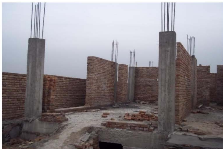
نمای تعمیر رهایشی واقع کارته پروان ( کابل )
