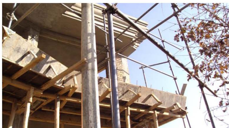
نمای قسمت تعمیر رهایشی واقع ناحیه هفتم ( کابل)
