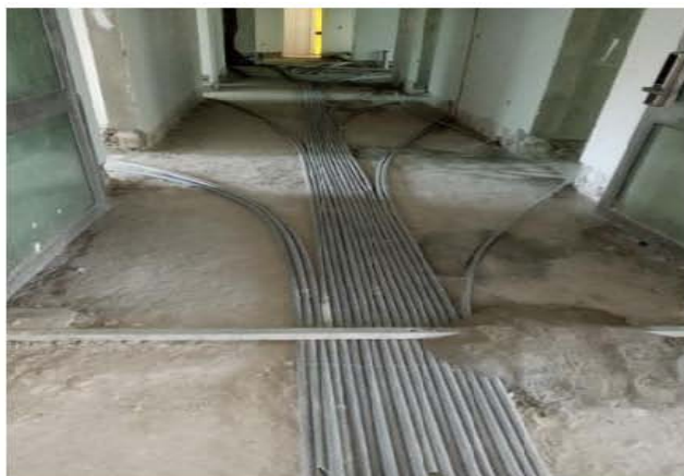
تصویری از بازسازی تعمیر اساسی وزارت خارجه ( کابل)
