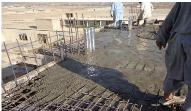
تصویری از کانکریت ریزی ساده (بدون کانکریت پمپ) مطابق نقشه های انجینری ساختمان (موقعیت پروژه - شهر کابل)
