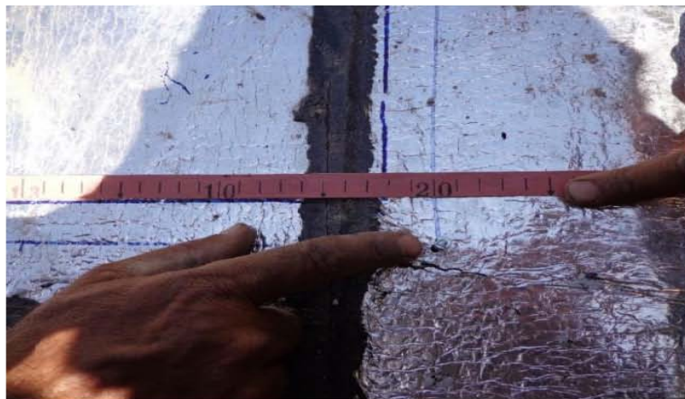
تصویری از چک کاری مراکز تهداب ها برای تهکوی مطابق نقشه های انجینری ساختمان (موقعیت پروژه - شهر کابل)
