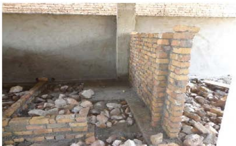
تصویری از خشت کاری داخلی مطابق نقشه های انجینری ساختمان (موقعیت پروژه - شهر کابل)
