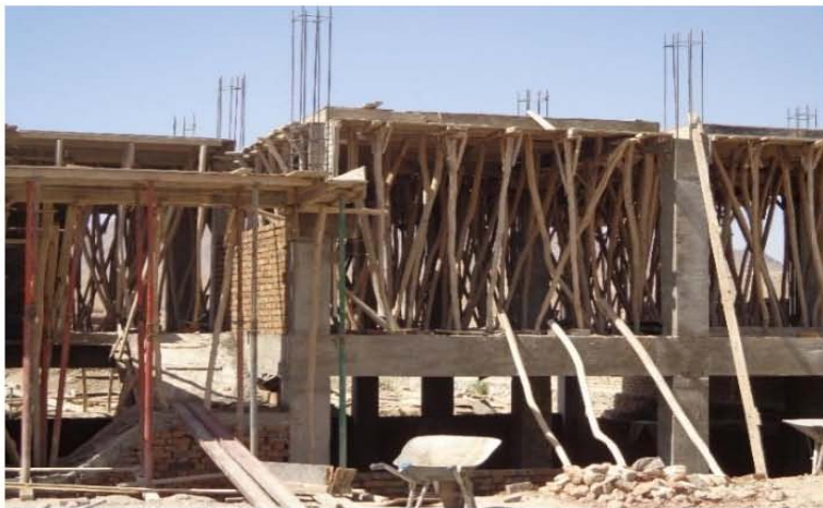
تصویری از قالب بندی پوشش مطابق نقشه های انجینری ساختمان (موقعیت پروژه - شهر کابل)
