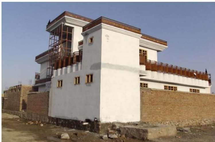
نمای قسمت تعمیر رهایشی واقع شینه (کابل)
