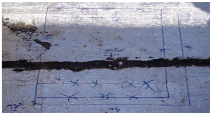
تصویری از خط اندازی تهداب ها بروی عایق رطوبت ایزوگام زرورقدار برای تهکوی مطابق نقشه های انجینری ساختمان (موقعیت پروژه - شهر کابل)
