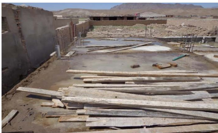
تصویری محافظت کانکریت و آماده گی برای امورات بعدی مطابق نقشه های انجینری ساختمان (موقعیت پروژه - شهر کابل)
