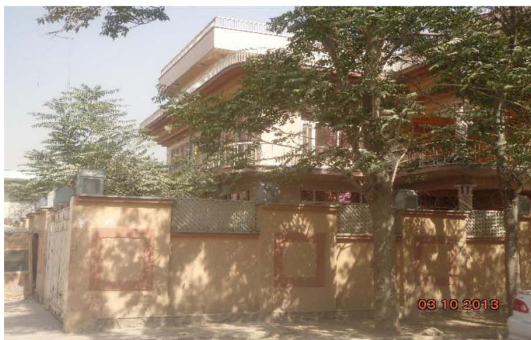
نمای تعمیر رهایشی کارته پروان ( کابل )
