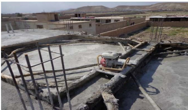
تصویری استفاده از وایبراتور در زمان کانکریت ریزی مطابق نقشه های انجینری ساختمان (موقعیت پروژه - شهر کابل)
