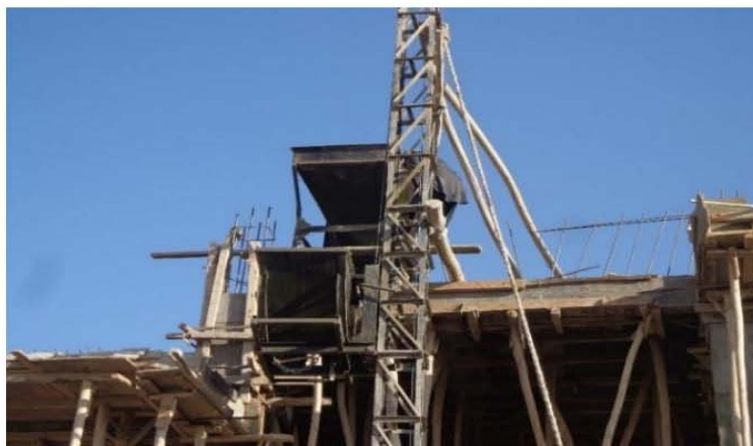
تصویری از بالابر کانکریت مطابق نقشه های انجینری ساختمان (موقعیت پروژه - شهر کابل)
