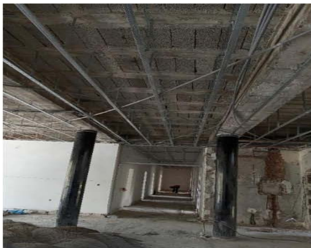
تصویری از بازسازی تعمیر اساسی وزارت خارجه ( کابل)
