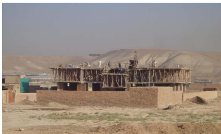
تصویری از ادامه کار مطابق نقشه های انجینری ساختمان (موقعیت پروژه - شهر کابل)
