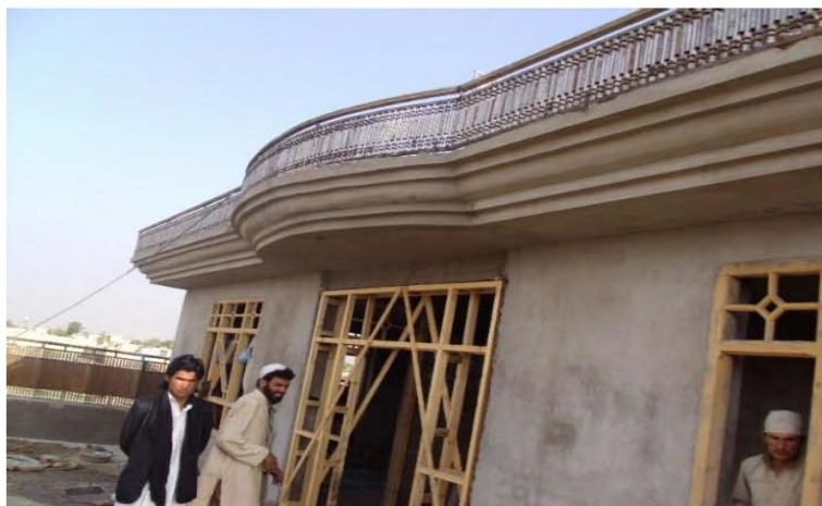
نمای قسمت تعمیر رهایشی واقع موسهی ( کابل)
