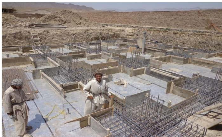
تصویری از قالب بندی برای تهاداب ها برای تهکوی مطابق نقشه های انجینری ساختمان (موقعیت پروژه - شهر کابل)
