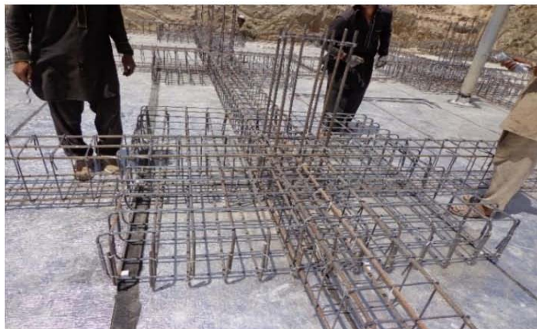
تصویری از نصب پایه ها و تهاداب ها برای تهکوی مطابق نقشه های انجینری ساختمان (موقعیت پروژه - شهر کابل)
