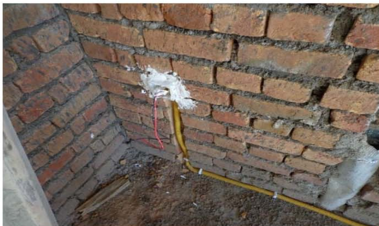
تصویری از پایپ دوانی برای برق داخلی مطابق نقشه های انجینری برق (موقعیت پروژه - شهر کابل)
