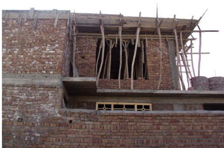
نمای قسمت تعمیر رهایشی واقع شینه ( کابل)
