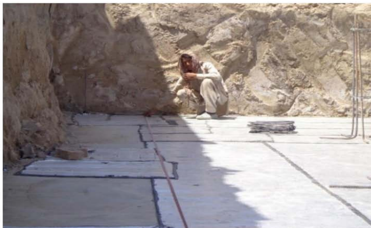
تصویری از چک و کنترل مراکز تهداب ها برای تهکوی مطابق نقشه های انجینری ساختمان (موقعیت پروژه - شهر کابل)
