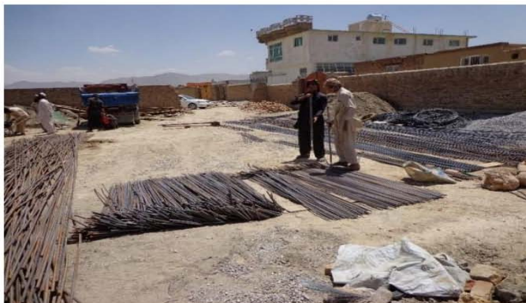
تصویری از قطع کاری سیخ گول و آماده گی برای تهداب های ساختمان (موقعیت پروژه - شهر کابل)
