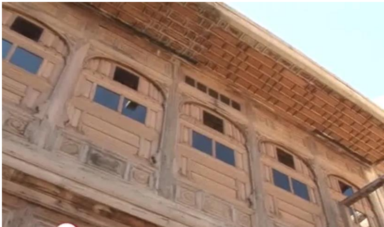
عکس از سقف پیک اتاق با مسطح چوبی
