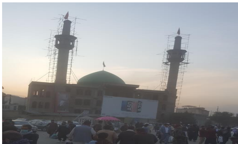
عکس خارجی از مسجد بی بی زینب
