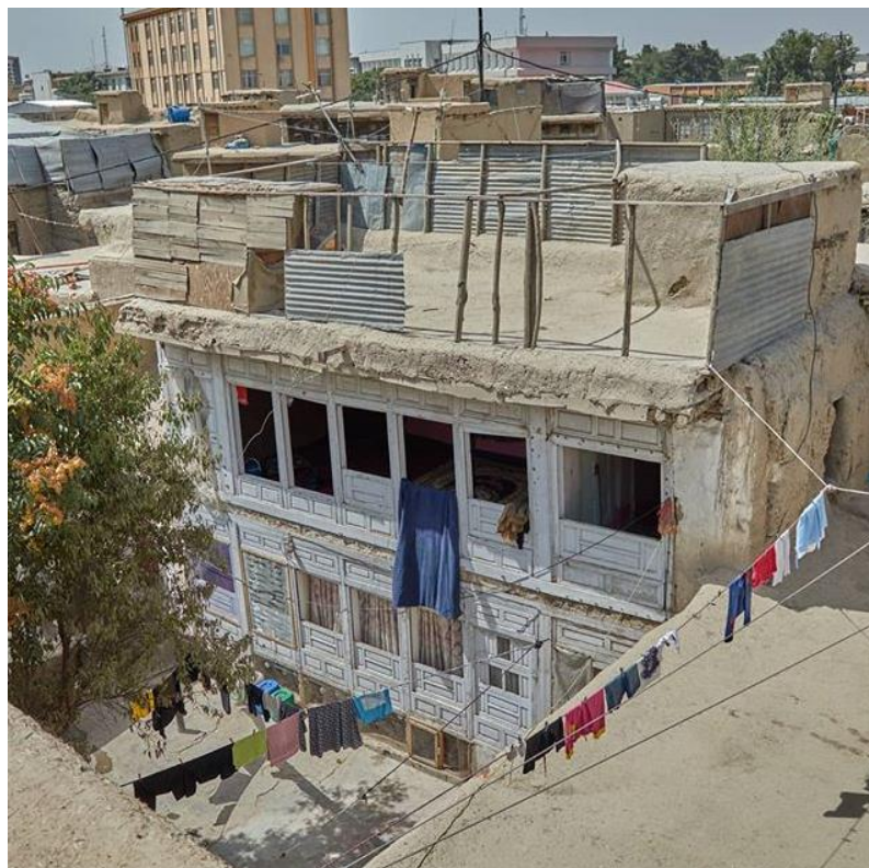
عکس یکی از خانه های رهایشی
