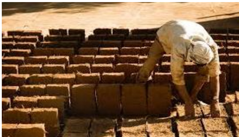
عکس از خشت ریزی برای ساختمان ها
