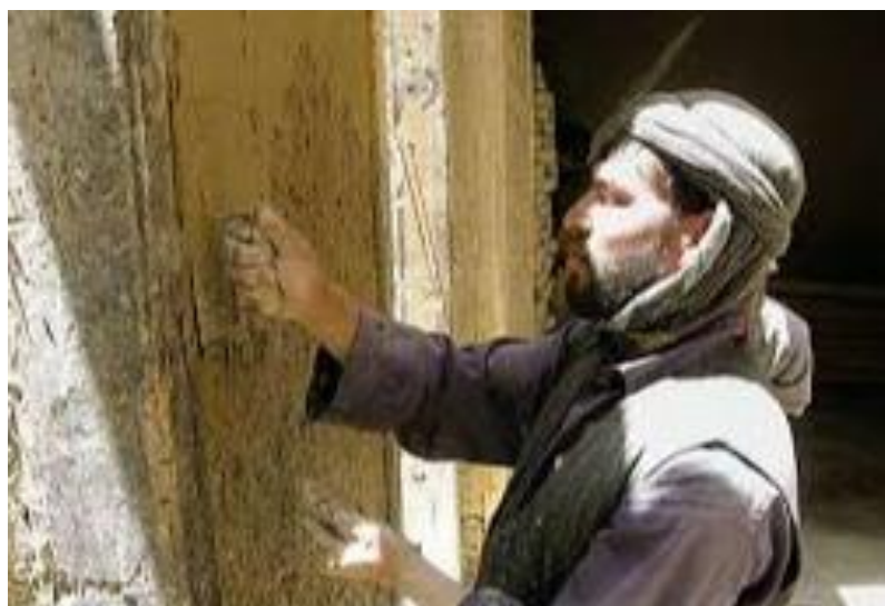
عکس از بازسازی دیوار
