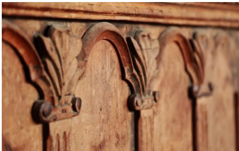
عکس یکی از چوبکاری در جریان باز سازی
