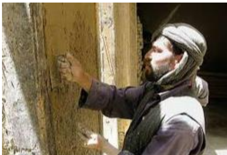
عکس از بازسازی دیوار
