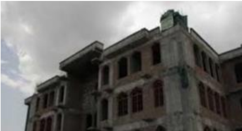
عکس خارجی از مسجد بی بی زینب
