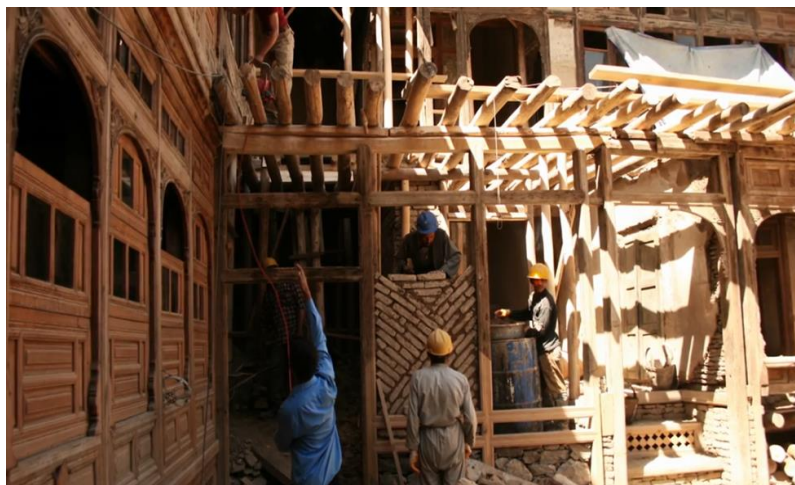
عکس یکی از خانه ها در جریان باز سازی
