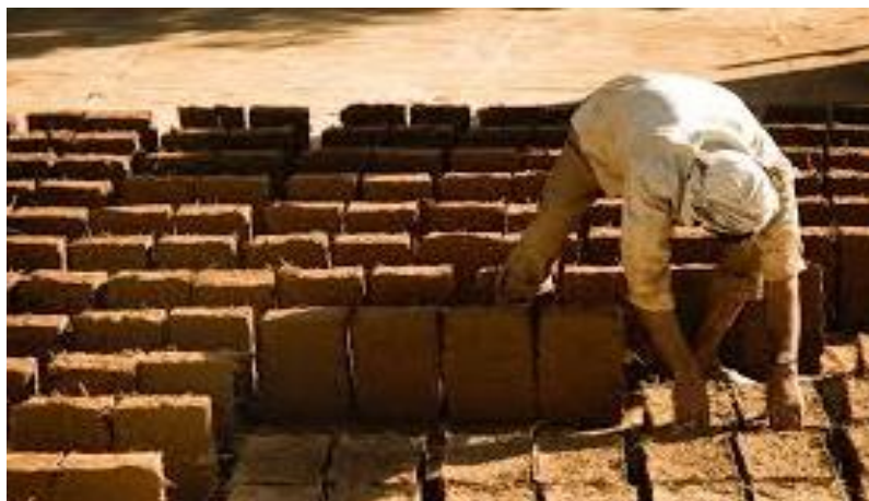
عکس از خشت ریزی برای ساختمان ها
