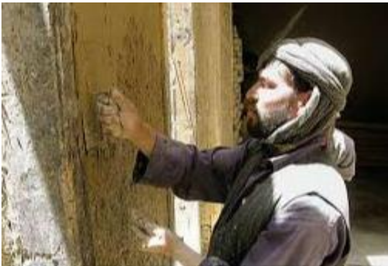
عکس از بازسازی دیوار
