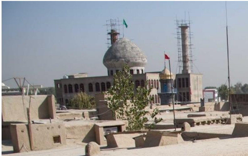
عکس خارجی از مسجد بی بی زینب
