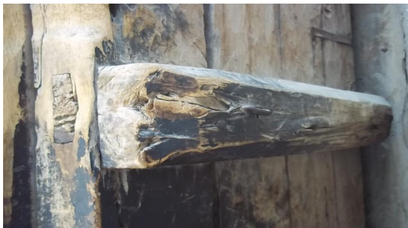
عکس از چوب افقی محکم گیرنده تخته های ایستاده دروازه ادخال یکی از حویلی ها
