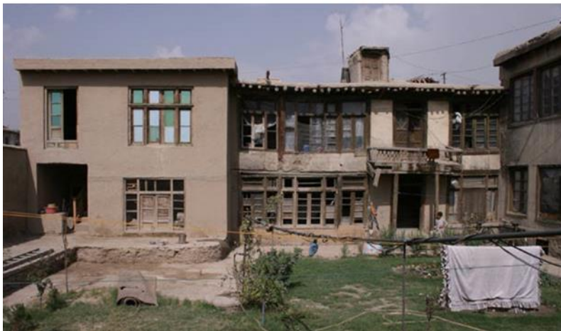
عکس بازسازی یکی از خانه های مراد خانی
