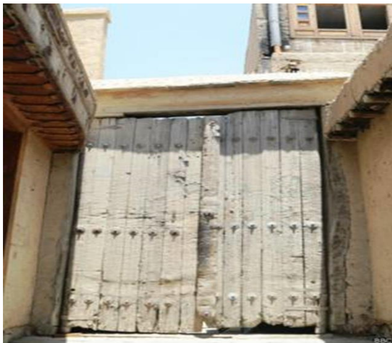
عکس یکی از دروازه های قدیمی
