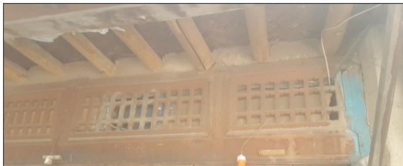
عکس از سقف پیک اتاق بدون مسطح
