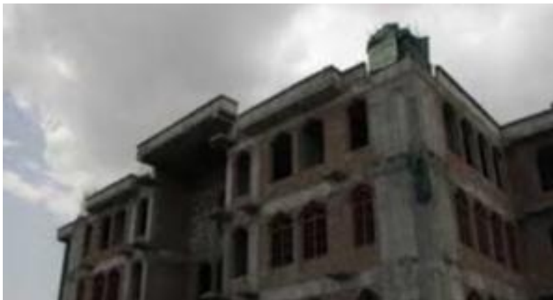
عکس خارجی از مسجد بی بی زینب
