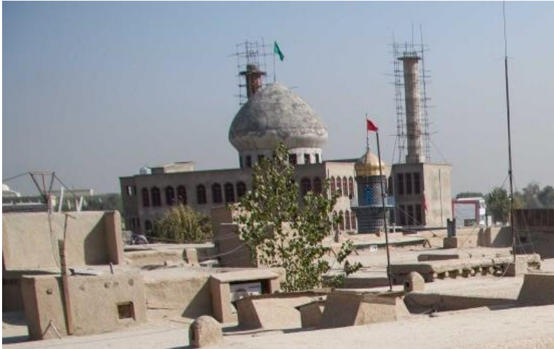
عکس خارجی از مسجد بی بی زینب
