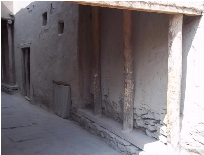
عکس دیوار سراچه جانب همسایه با زیر تیر و ستون های چوبی
