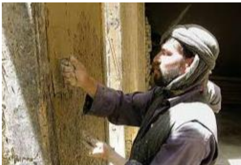
عکس از بازسازی دیوار
