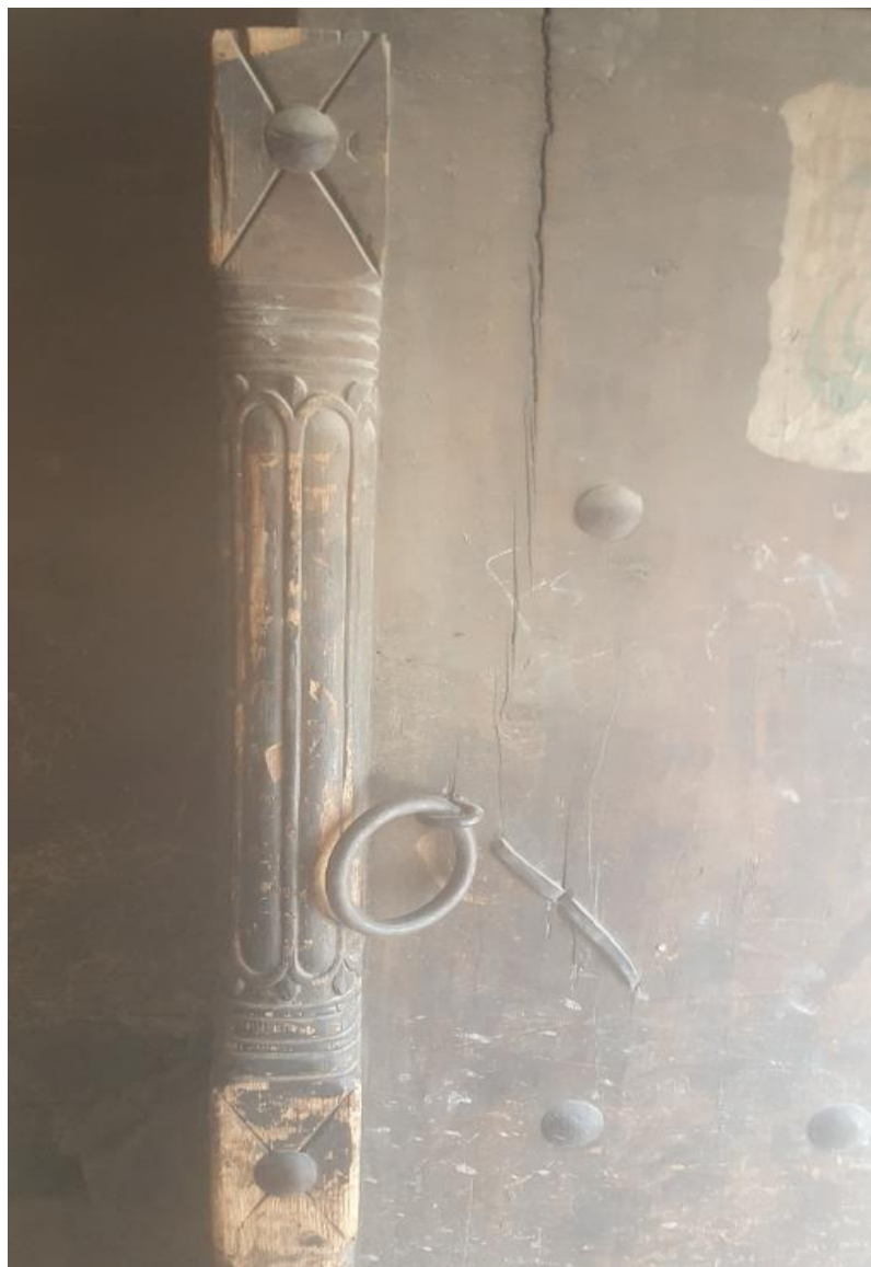
عکس از بینیچه دروازه ادخال یکی از حویلی ها
