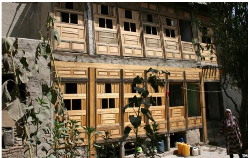
عکس بازسازی یکی از خانه های مراد خانی
