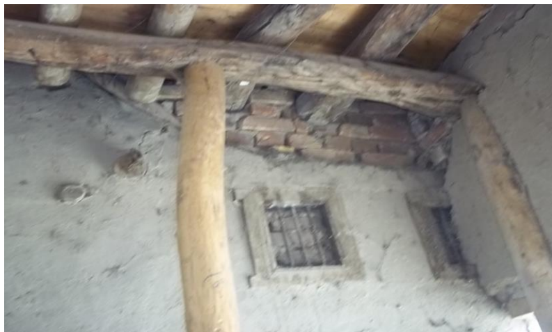
عکس دیوار سراچه جانب همسایه با سر تیر و ستون های چوبی (قسمت پوشش)
