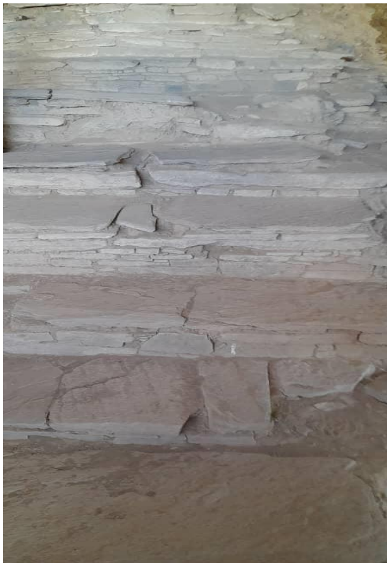
تصویر بخشی از استوپیای منطقه مس عینک
