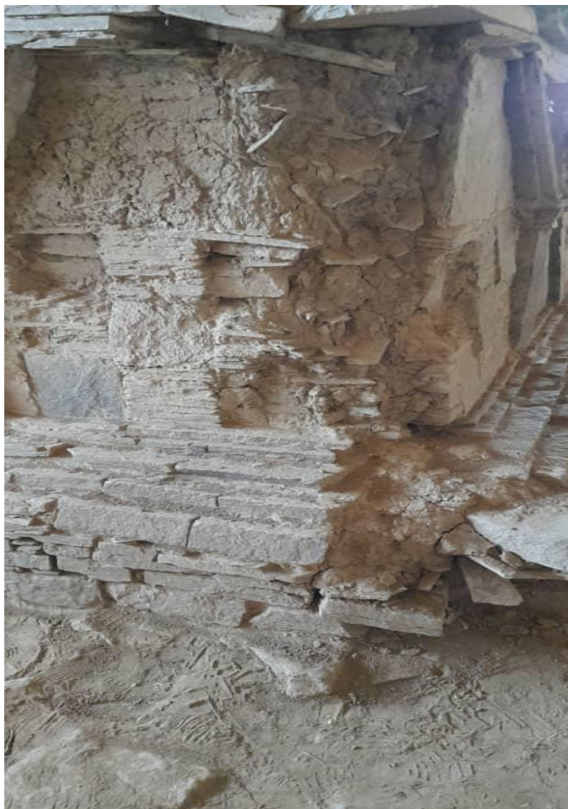
تصویر بخشی از استوای منطقه مس عینک
