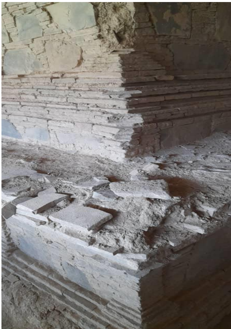
تصویر بخشی از استوای منطقه مس عینک
