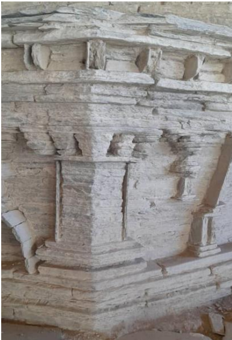
تصویر بخشی از استوای منطقه مس عینک
