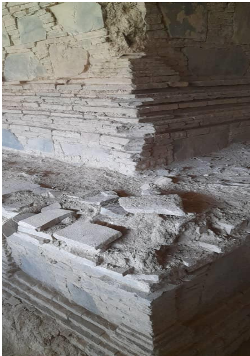
تصویر بخشی از استوای منطقه مس عینک
