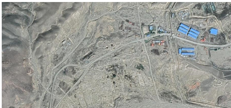
تصویر فضایی (هوایی) ساحه شهر مس عینک
