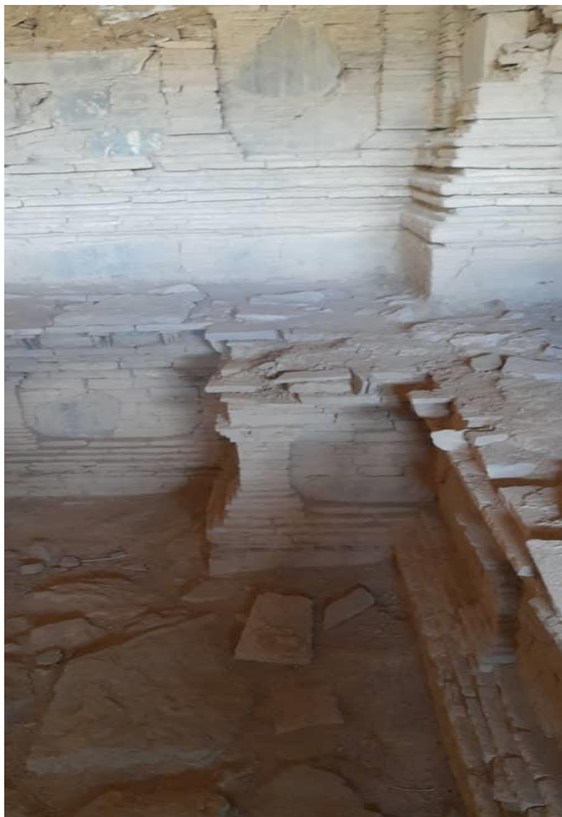
تصویر بخشی از استوپیای بلند در منطقه مس عینک
