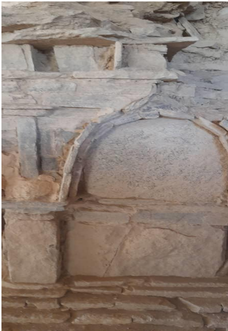
تصویر بخشی از استوای منطقه مس عینک
