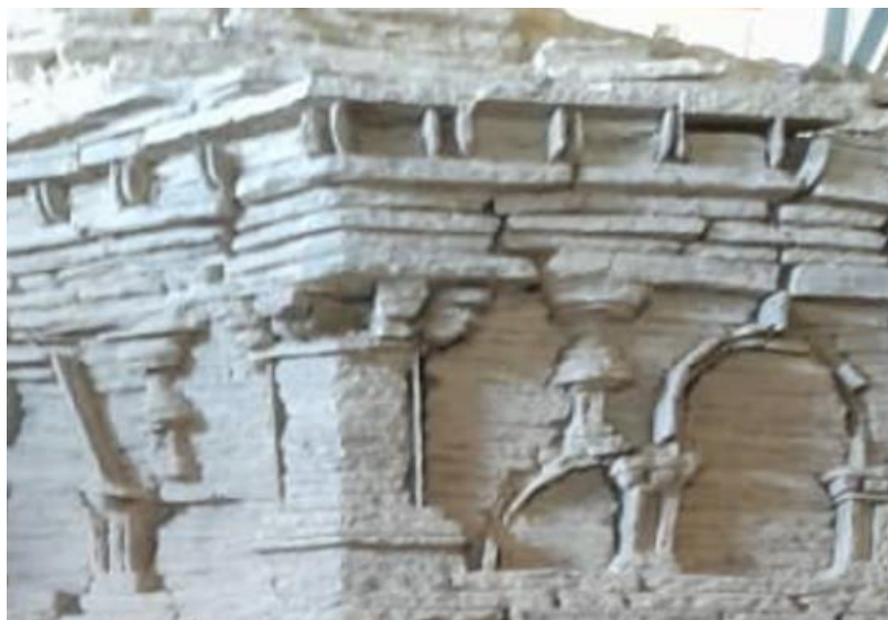
تصویر بخشی از استوپای منطقه مس عینک
