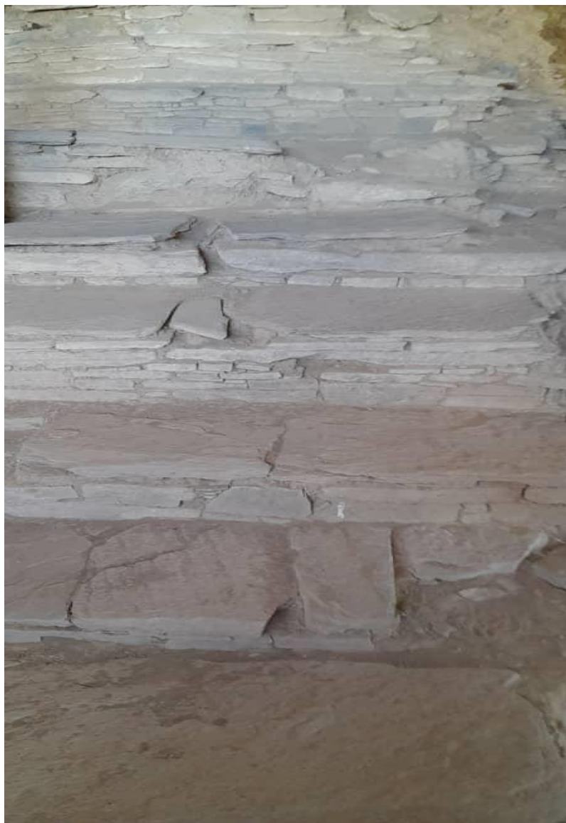
تصویر بخشی از استوپیای منطقه مس عینک
