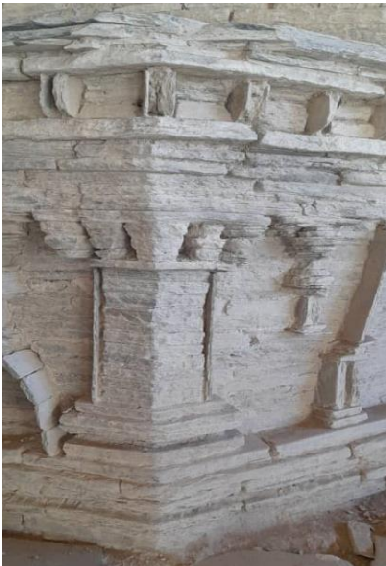
تصویر بخشی از استوای منطقه مس عینک
