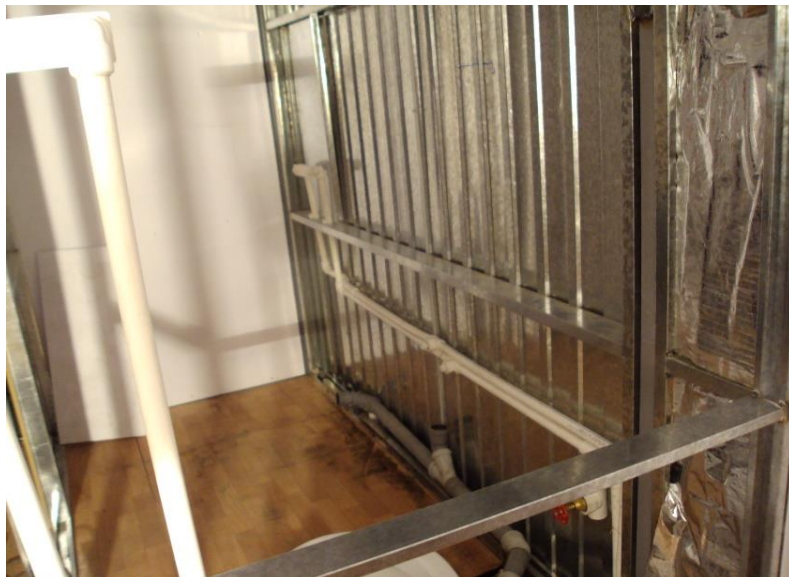
تصویر منتهای چنل های افقی و عمودی به شکل ولدنگ در کانتینر های تی آی ام
