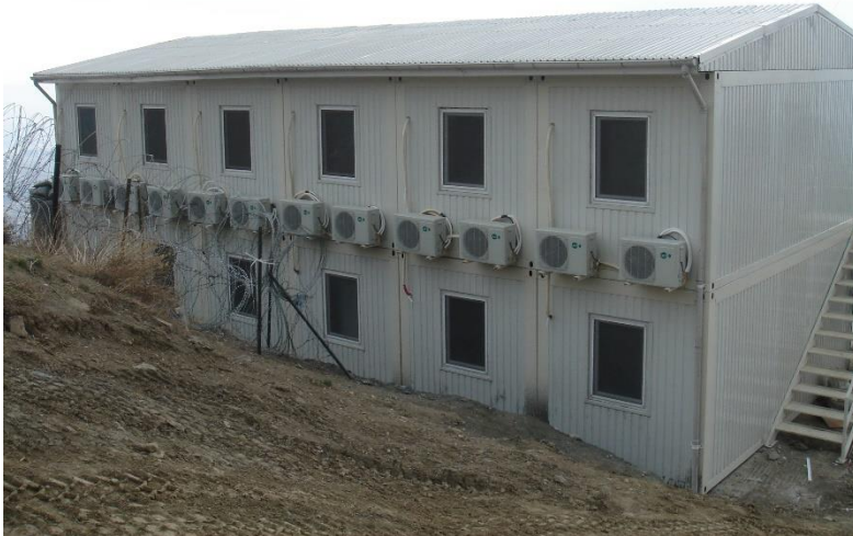
تصویر از ساختمان دو منزله کانتینری تی آی ام
