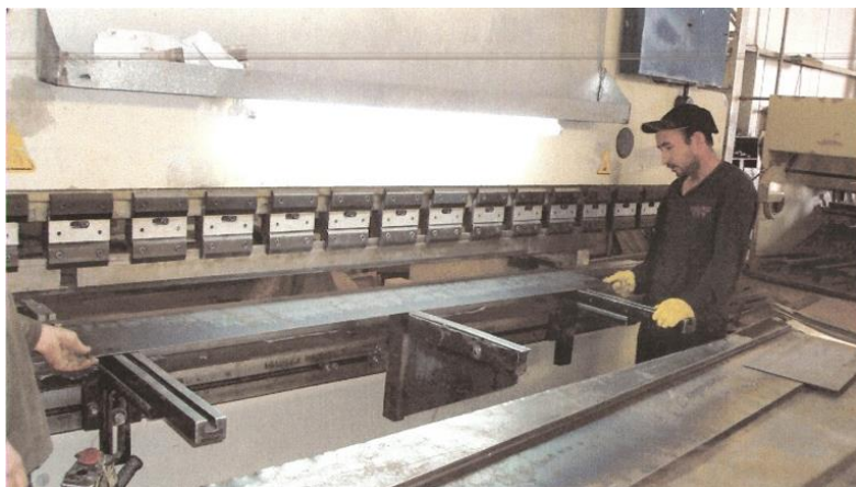
تصویری از برشکاری فلز سیاه برای کانتینر در فابریکه تی آی ام
