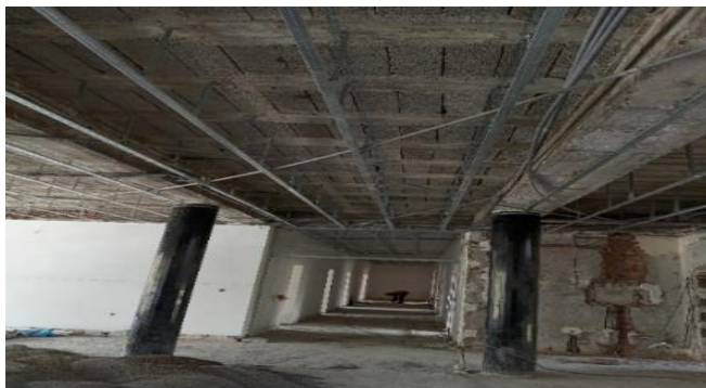
تصویری از بازسازی تعمیر اساسی وزارت خارجه ( کابل )
