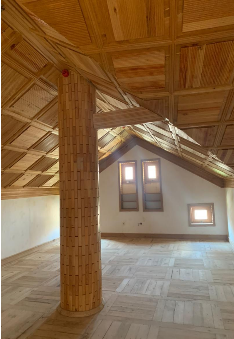
تصویری از ساختمان داخلی حمام و تشناب
