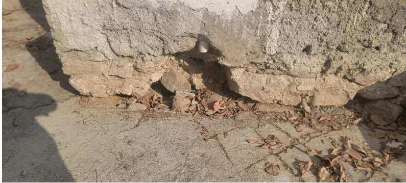
تصویر ریخته گی در قسمتی از تهداب ساختمان حرمسرا
