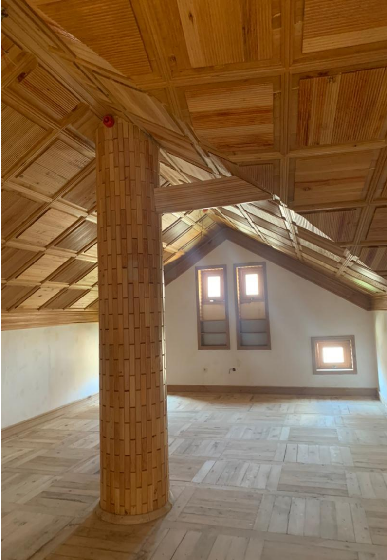
تصویری از ساختمان داخلی حمام و تشناب
