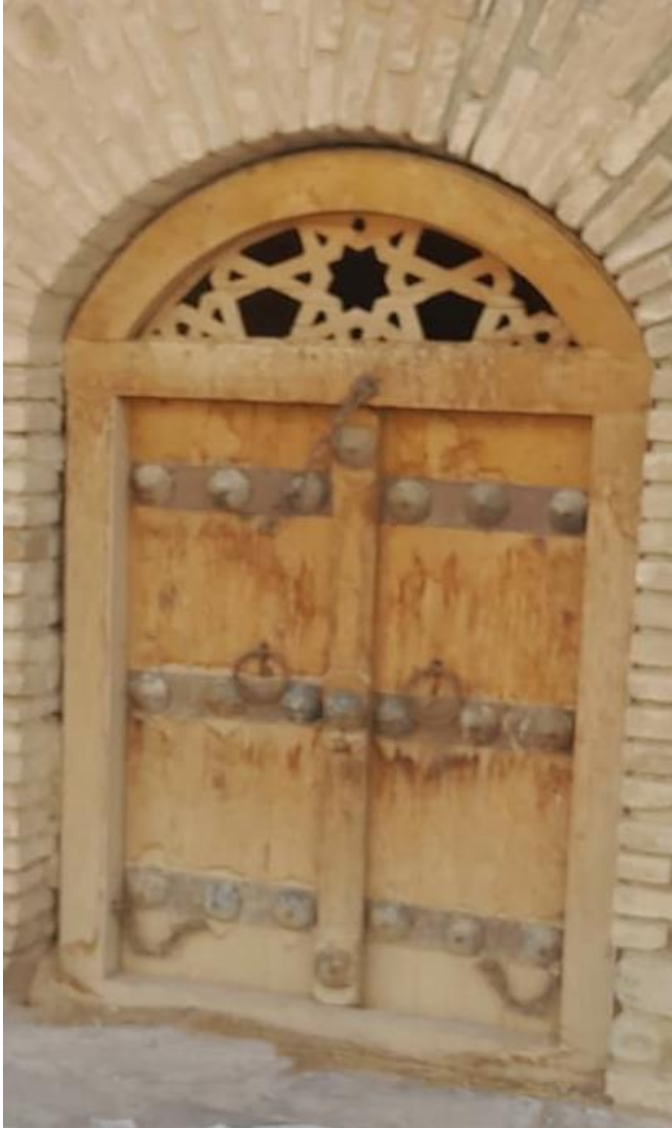
تصویری دروازه ادخال یکی از تونل ها (بونکر ها)
