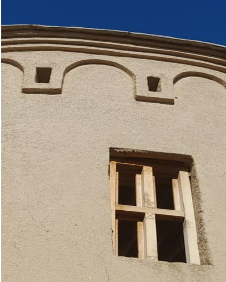
تصویری از قسمت برج های داخلی قلعه
