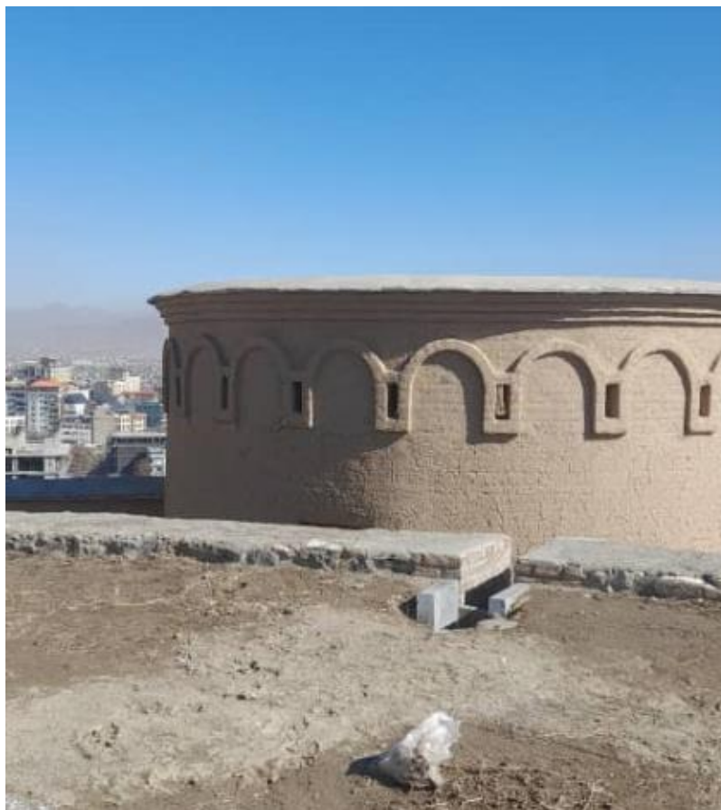
تصویری از قسمت بیرونی برج های داخلی قلعه
