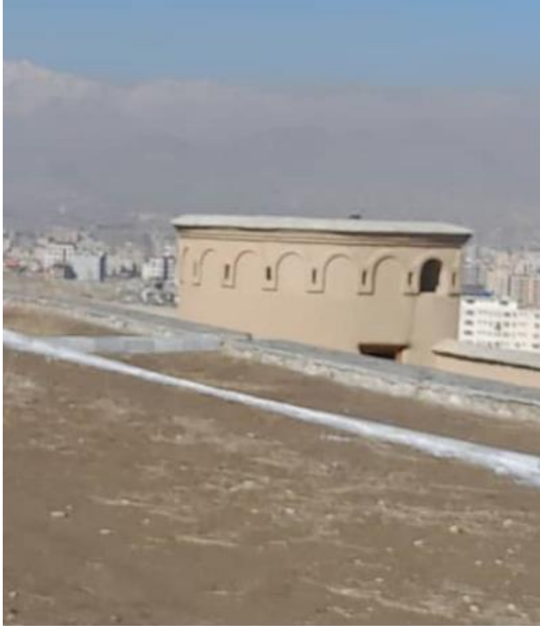
تصویری از قسمت بیرونی برج داخلی قلعه
