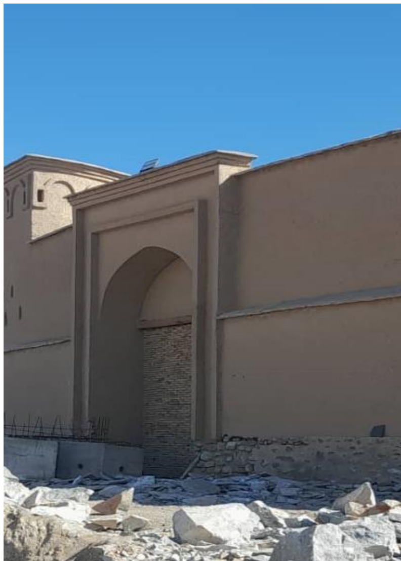
تصویری از قسمت دروازه عمومی غربی قلعه
