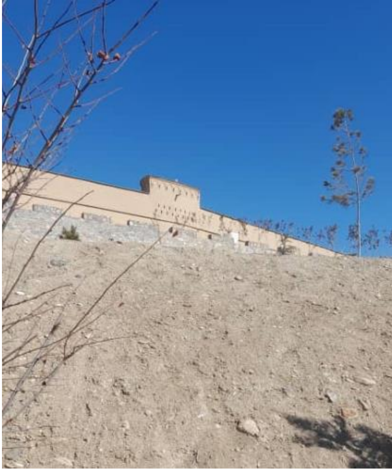
تصویری خارجی از دیوار احاطه قلعه بلند
