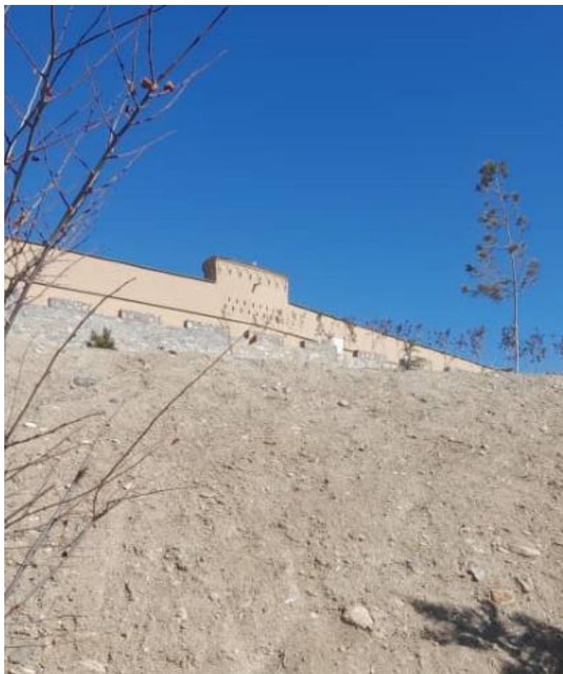
تصویری خارجی از دیوار احاطه قلعه بلند
