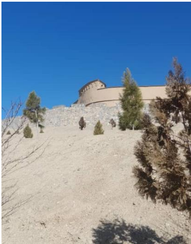
تصویری از قسمت بیرونی برج داخلی قلعه
