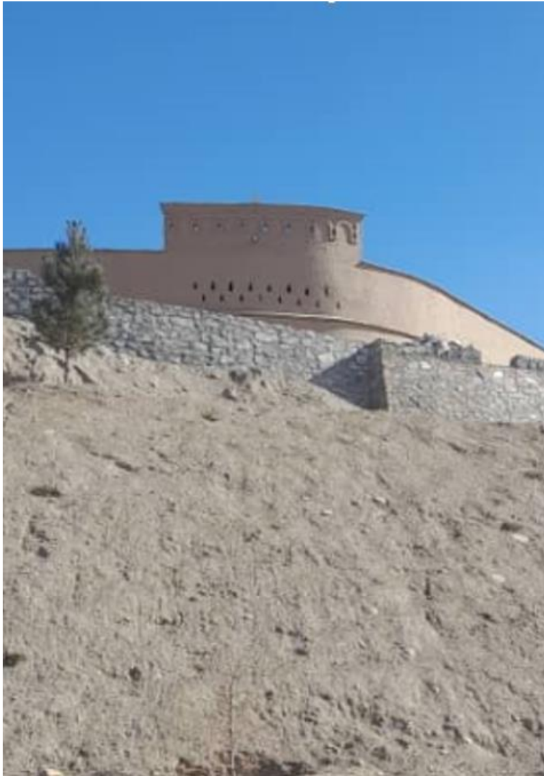
تصویری خارجی از دیوار احاطه قلعه بلند
