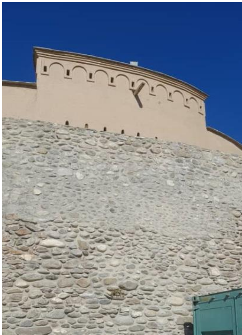
تصویری از قسمت بیرونی برج داخلی قلعه
