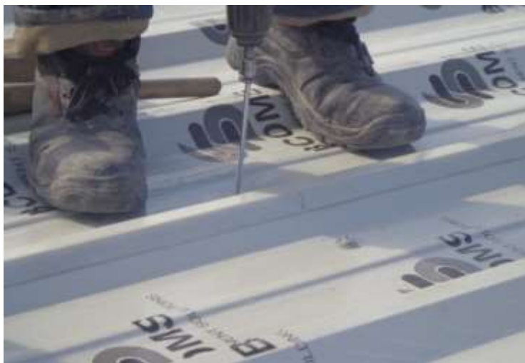
تصویری از پیچ کاری ساندویچ پانل پوشش
