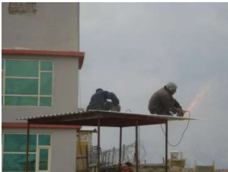
تصویری از پوشش ساختمان تقسیم بندی پایپ لین
