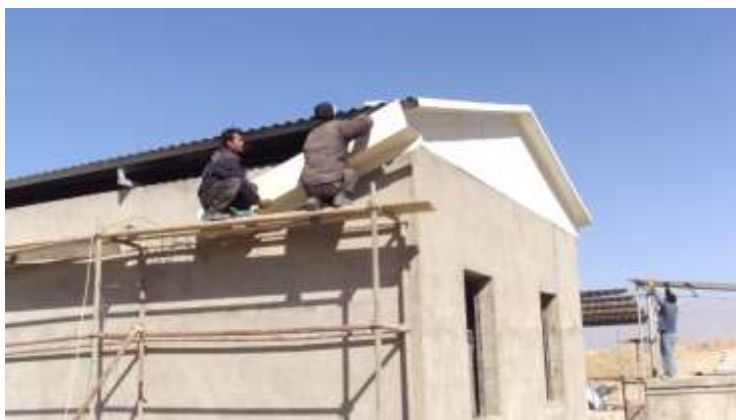
تصویری از نصب لبگرد های جنراتور خانه
