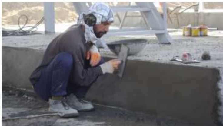
تصویری از بخش پلستر کاری در سازه
