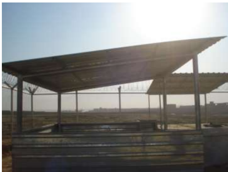
تصویری از ساختمان تصفیه خانه
