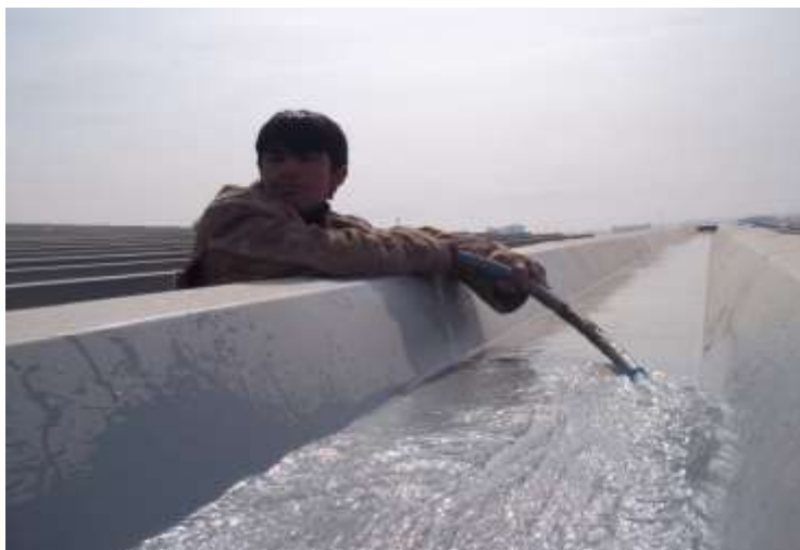
تصویری از تست ناوه ها افقی قبل از نصب ساندویچ پانل های پوشش
