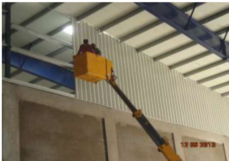
تصویری از نصب آهنچادرهای دیوارهای داخلی
