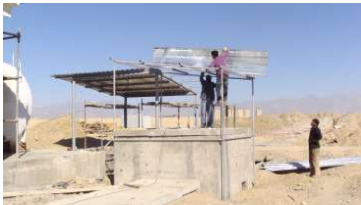
تصویری از ساختمان تصفیه خانه
