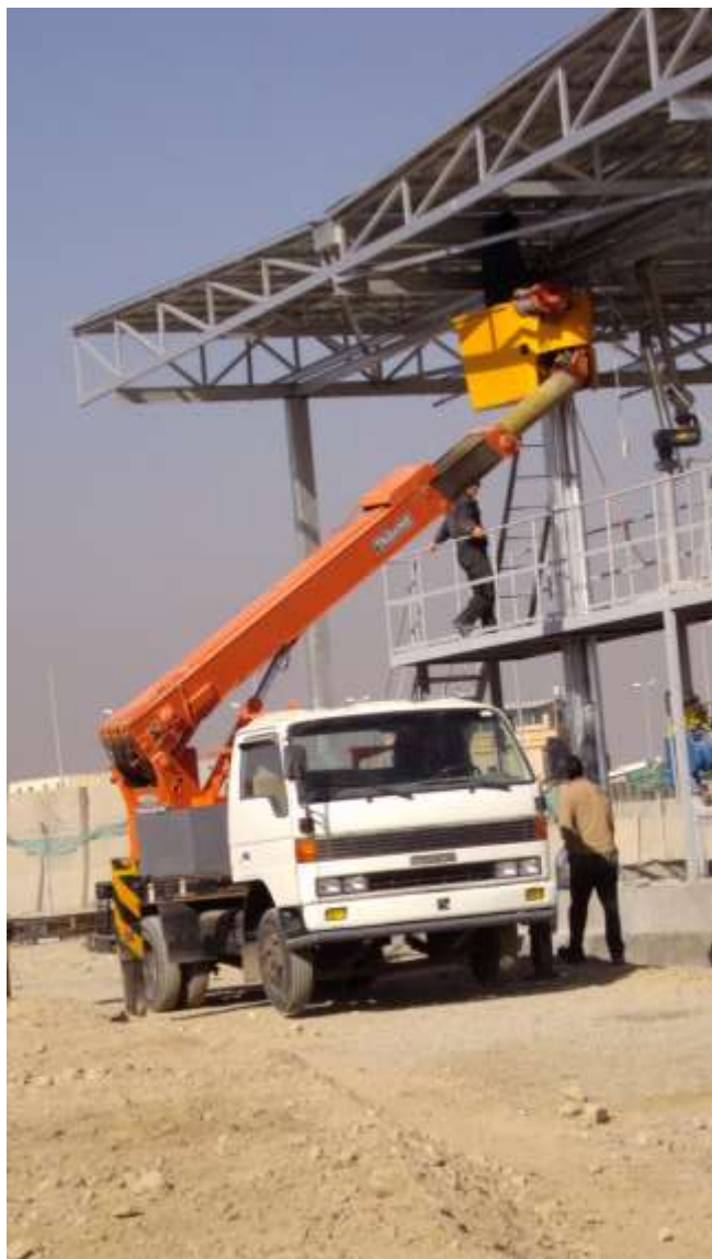
تصویری از نصب سیستم اطفایه و چراغ در ساحه
