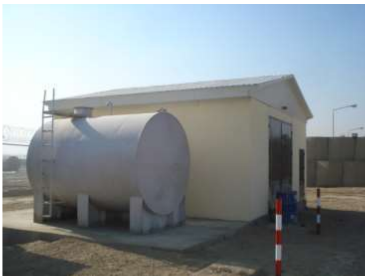
تصویری از نصب تانکر تیل جنراتور
