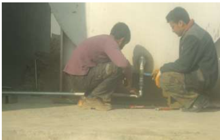
تصویری از اتصال پمپ نیل جنراتور
