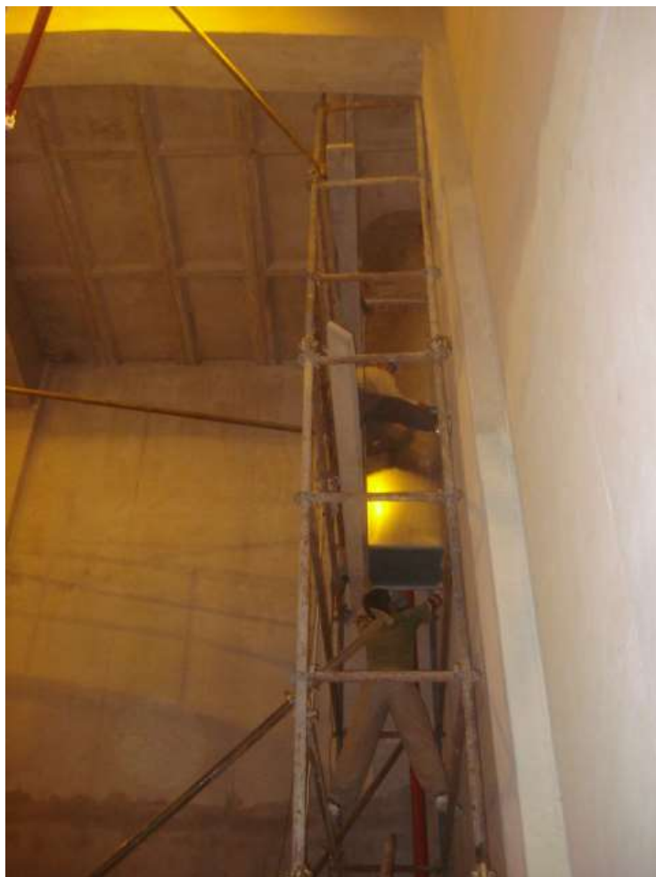
تصویری از نصب کانال برای هواکش ها
