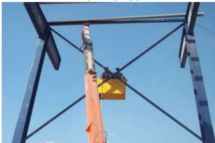
تصویری از نصب انگلارن کش بین دو پایه
