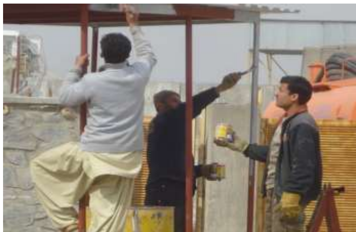
تصویری از رنگمالی ضد زنگ ساختمان تقسیم بندی پایپ لین
