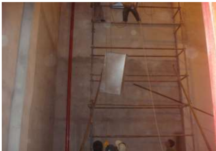
تصویری از نصب کانال برای هواکش ها
