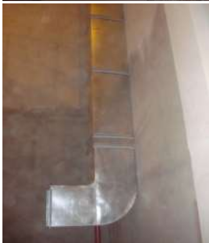
تصاویری از نصب کانال عمودی برای هواکش ها
