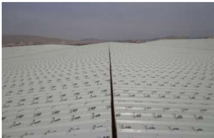
تصویری از وسط بام (درز بین دو پانل سقف)
