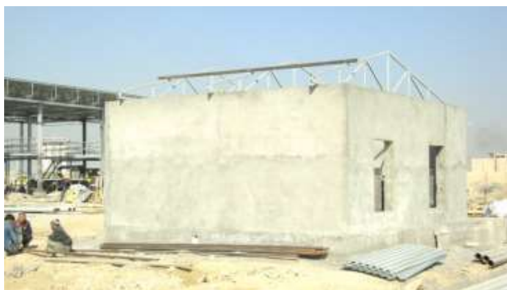
تصویری از نصب ترس های جنراتور خانه
