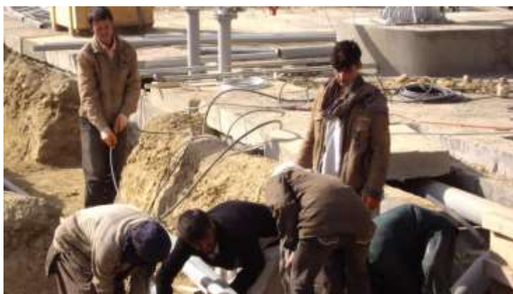
تصویری از بخش برق در سازه
