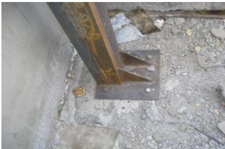
تصویری از نصب پایه ها
