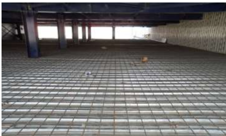
تصویری از سیخ بندی بالای آهن پوشش
