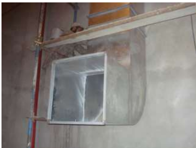
تصویری از نصب کانال برای هواکش ها
