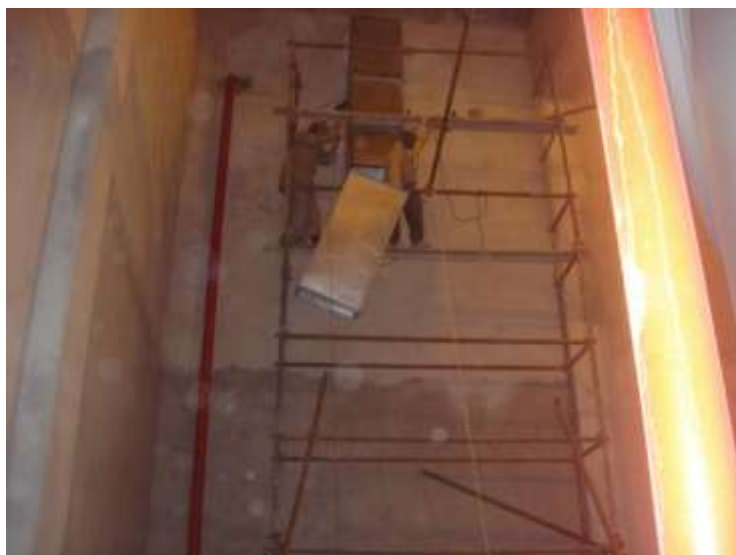
تصویری از نصب کانال برای هواکش ها
