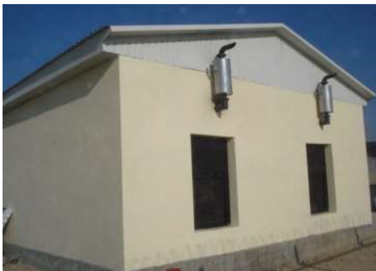
تصویری از هواکش (Louver) جنراتور خانه
