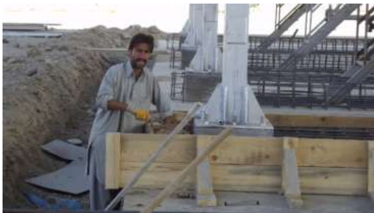
تصویری از کار قالببندی در سازه
