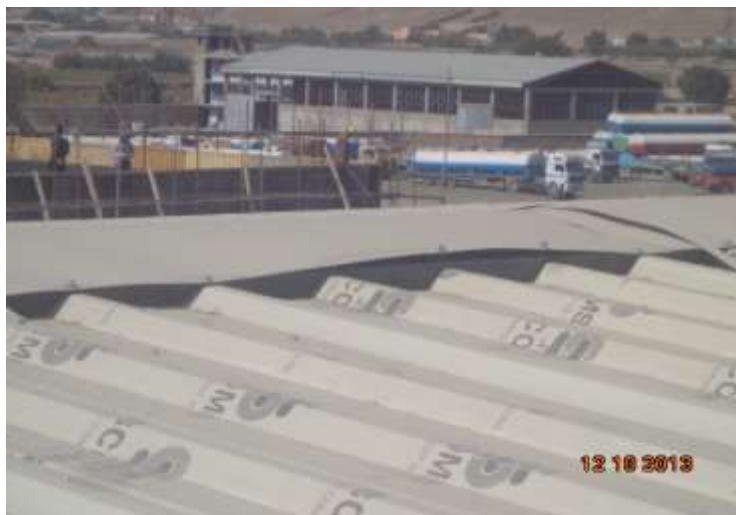
تصویر یاز نصب کمر بند آهن چادروسط بام
