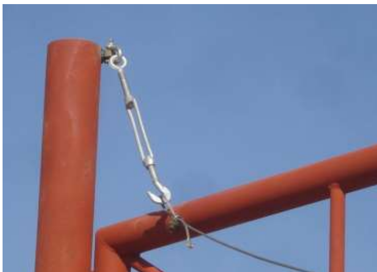
تصویری از نصب کیبل های کش
