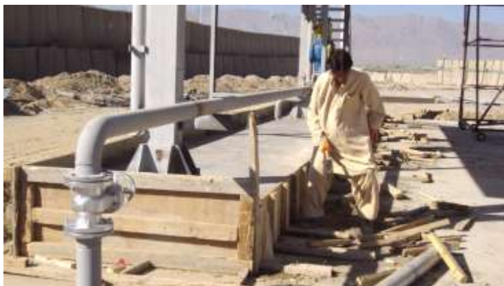
تصویری از کار جدا سازی قالب در ساحه
