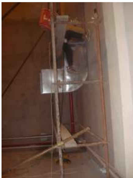
تصویری از نصب کانال برای هواکش ها
