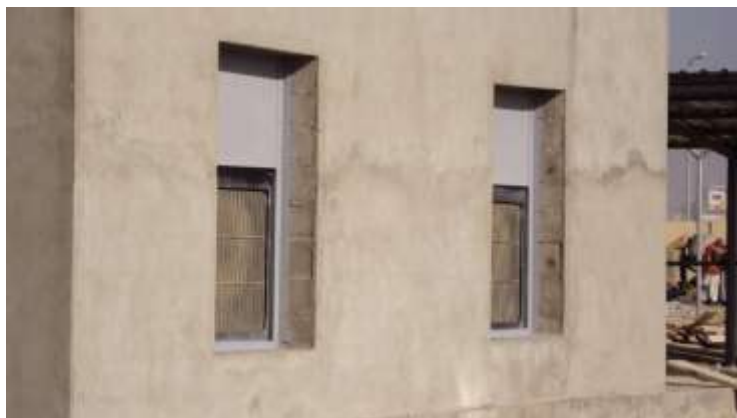
تصویری از ساختمان جنراتور خانه
