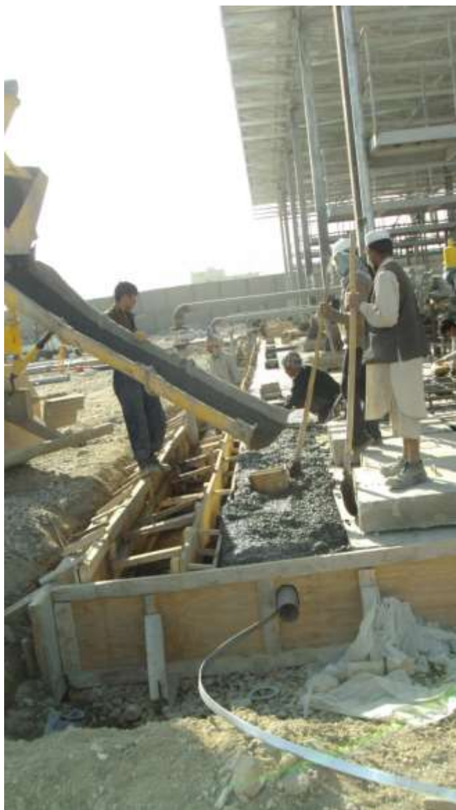
تصویری از کانکریت ریزی در سازه
