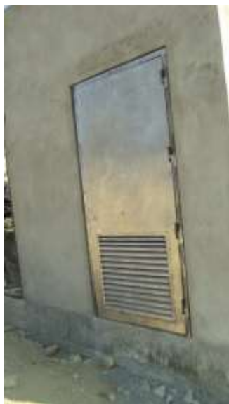
تصویری از نصب دروازه جنراتور خانه
