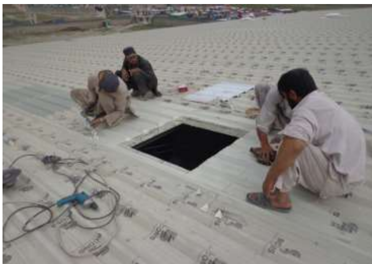
تصویری از امورات قبل از نصب هواکش پوشش
