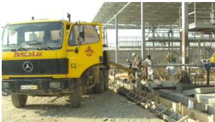
تصویری از کانکریت ریزی در سازه
