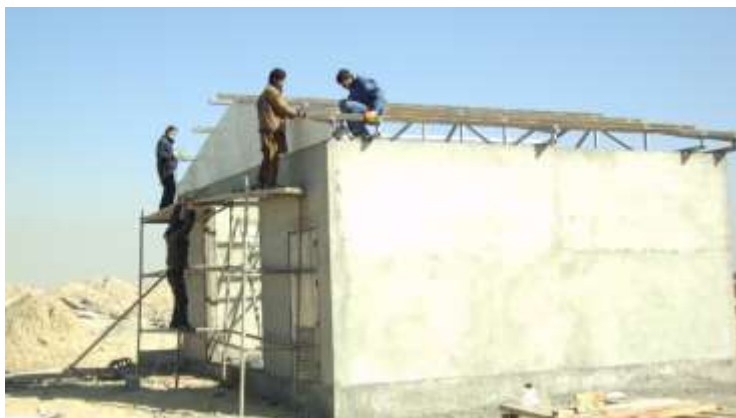
تصویری از نصب رویکش های جنراتور خانه
