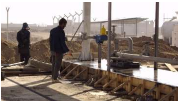
تصویری از کانکریت ریزی در سازه
