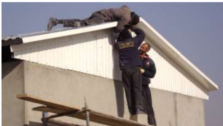
تصویری از نصب لبگرد های جنراتور خانه
