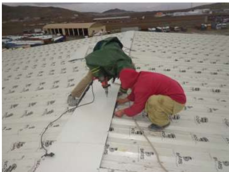
تصویری از نصب فوم و آهن چادر وسط بام بالای دوپانل
