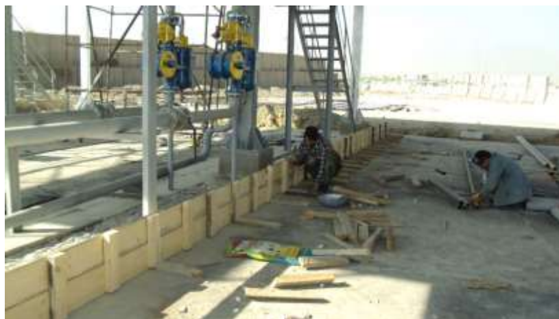
تصویری از کار قالببندی در سازه
