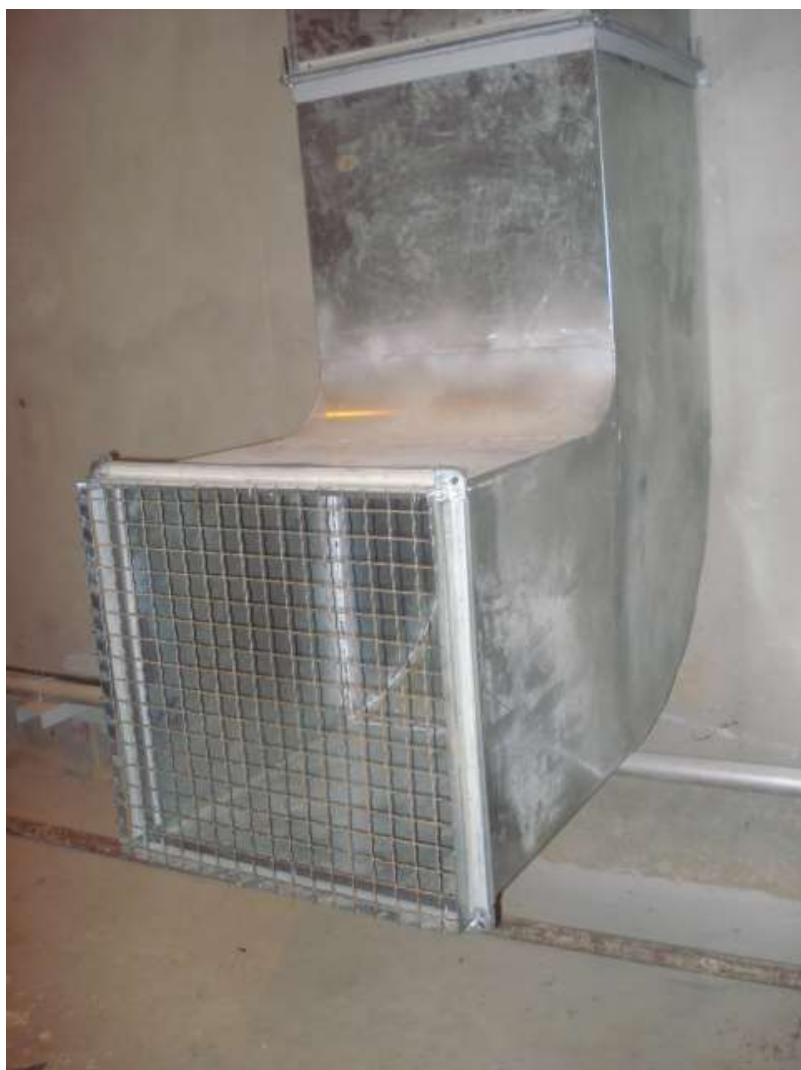
تصویری از نصب جالی برای کانال هواکش ها
