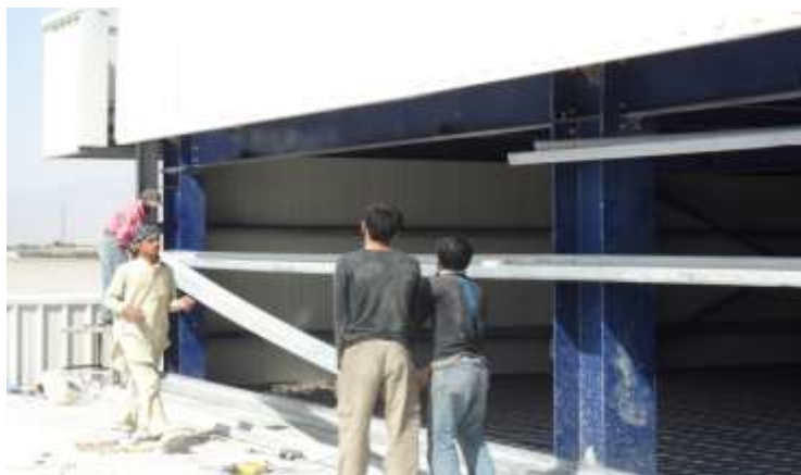
تصویری از نصب چابنل کناری در بام
