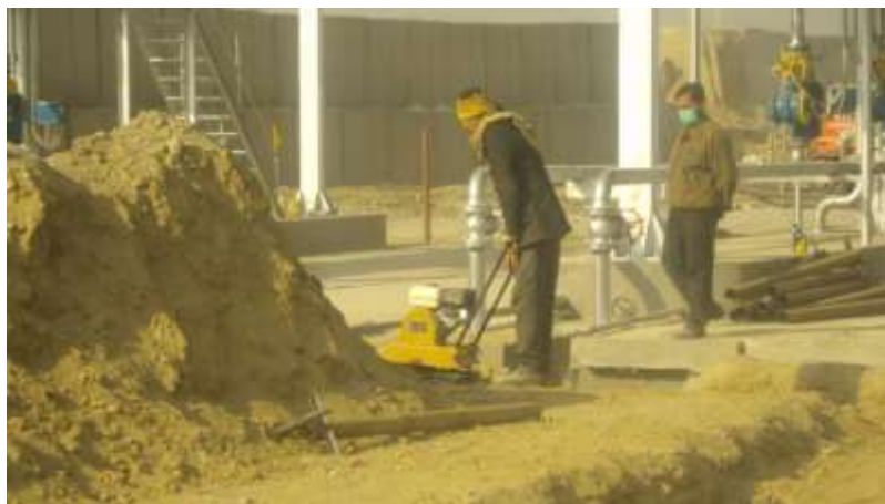
تصویری از کار ساختمانی در سازه
