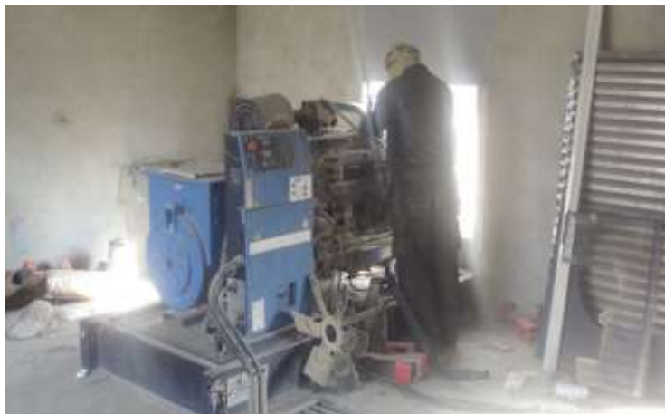
تصویری از نصب جنراتور
