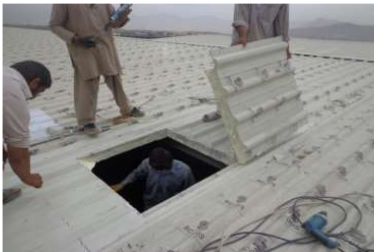
تصویری از آماده گی برای نصب هواکش پوشش
