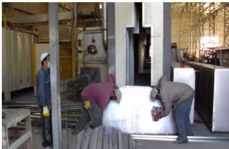
تصویری پاک کاری پله دروازه فلزی قبل از رنگ
