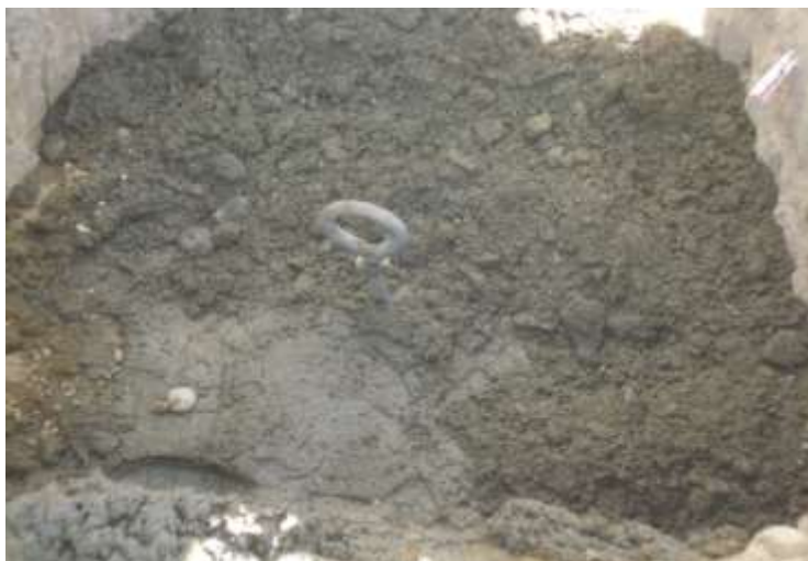
تصویری از کانکریت ریزی حلقه کیبل کش
