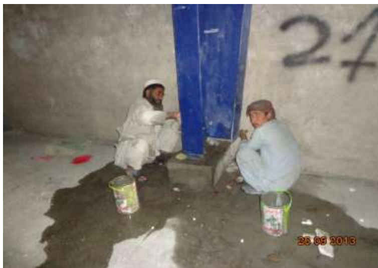
تصویری از گروتنگ پایه ( Grouting )
