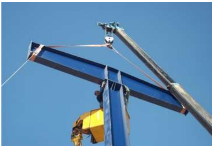
تصویری از نصب تاج پایه ها
