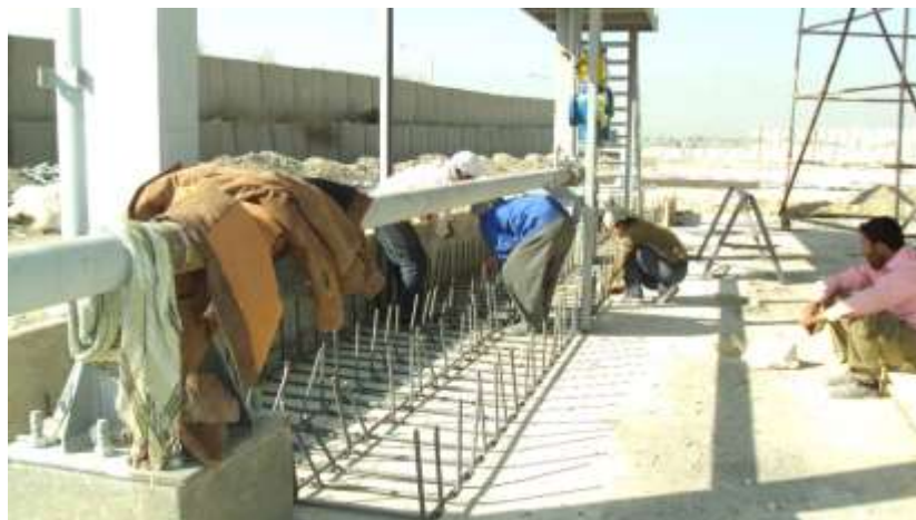
تصویری از کار ساختمانی در سازه
