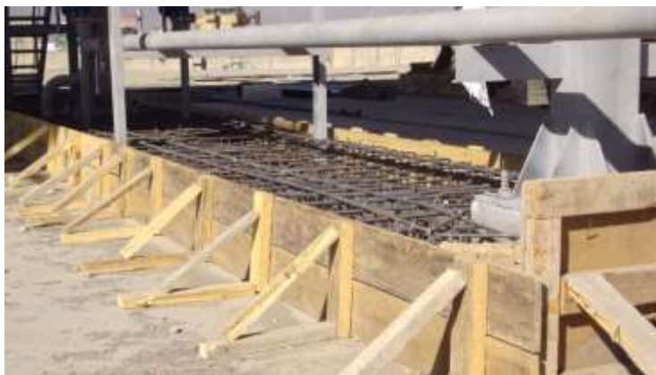
تصویری از کارقالببندی در سازه
