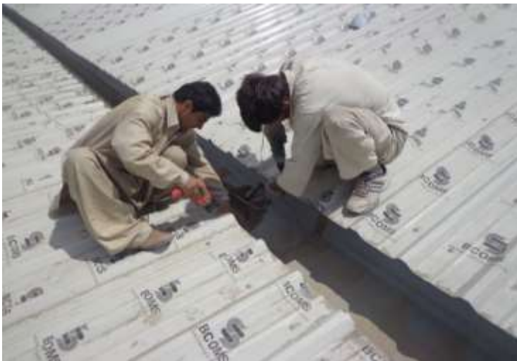
تصویری از نصب فوم ناوه افقی
