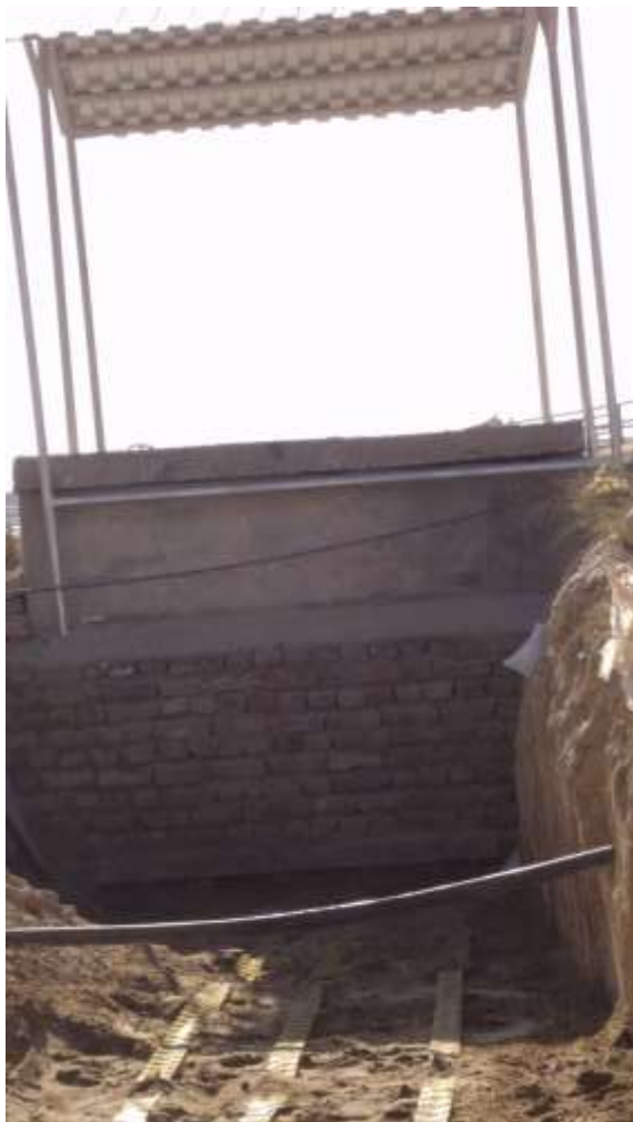
تصویری از ساختمان تصفیه خانه
