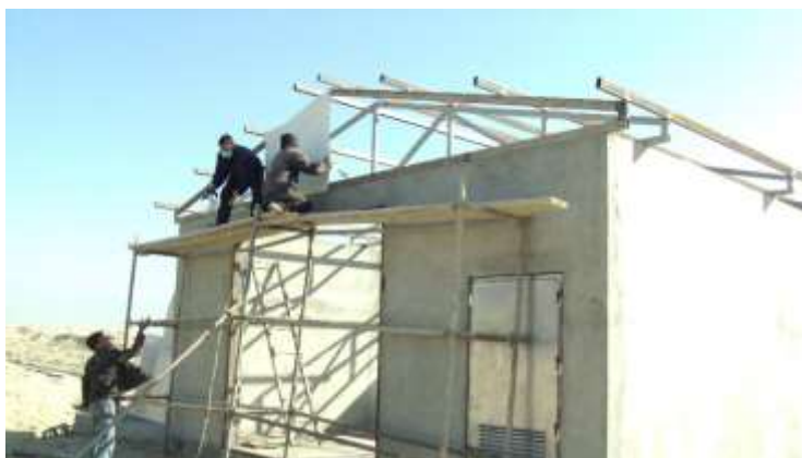
تصویری از نصب رویکش های دیوار جنراتور خانه
