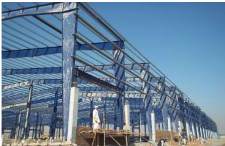
تصویری از نصب گادر بعد از اصلاح در سازه کاری
