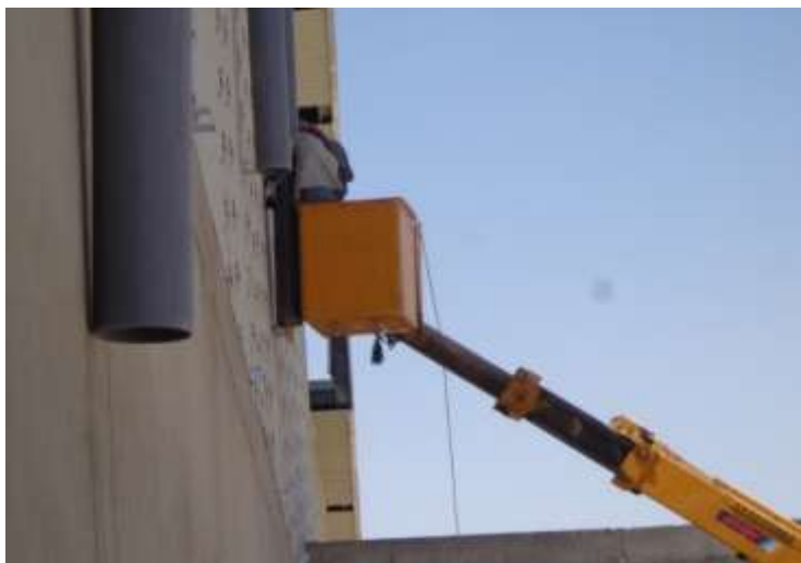
تصویری از نصب ناوه عمودی
