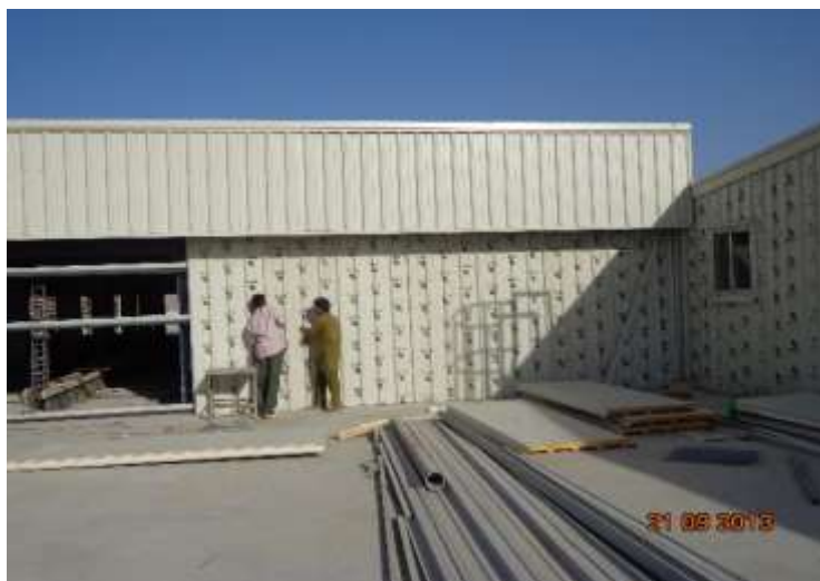
تصویری از نصب دیوارهای خارجی (Sandwich panel)
