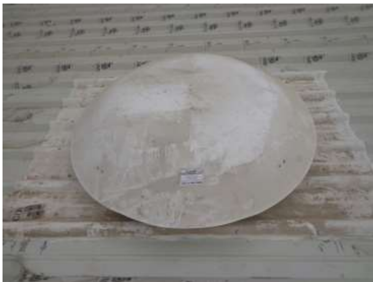
تصویری از نصب هواکش پوشش
