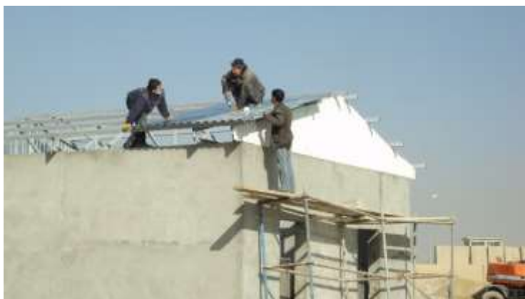
تصویری از نصب آهن چادر پوشش جنراتور خانه
