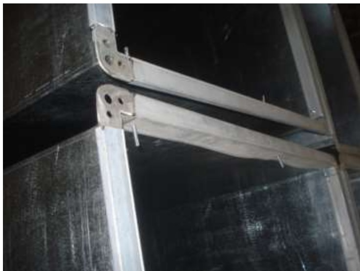
تصویری از اتصال کاری برای کانال ها
