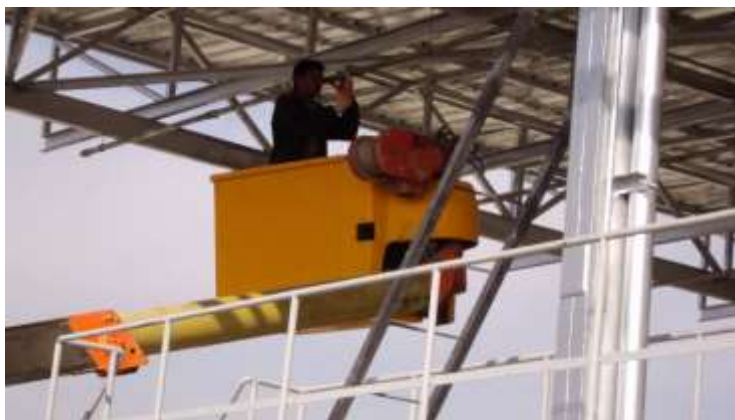
تصویری از نصب سیستم اطفایه در سازه
