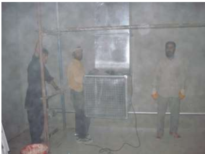
تصویری از نصب جالی برای کانال هواکش ها
