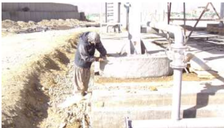
تصویری از کار پلسترکاری در ساحه
