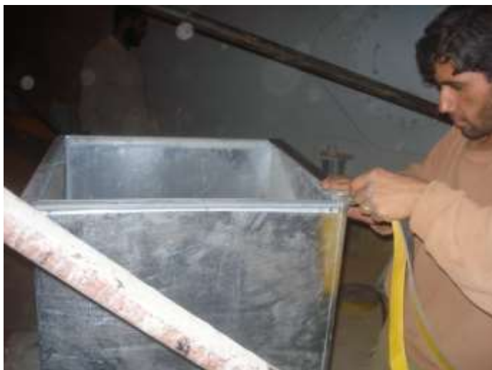
تصویری از نصب چسپ برای کانال هواکش ها
