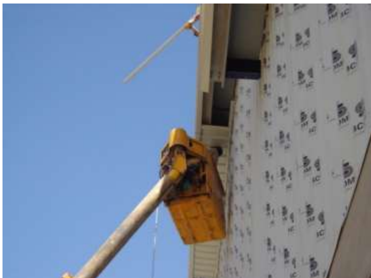
تصویری از نصب آهن چادرهای زیر پاراپت
