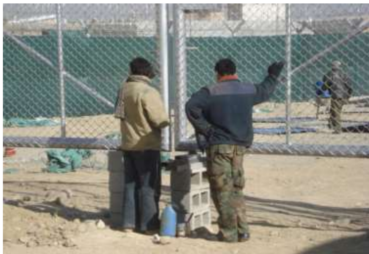
تصویری از نصب قفلک های عمودی دروازه
