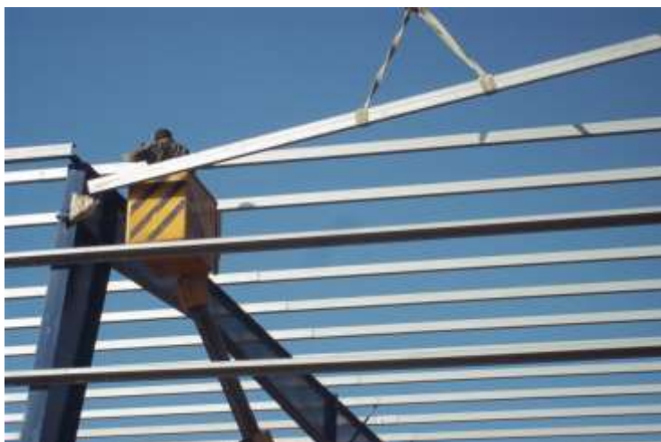
تصویری از نصب رفته ها
