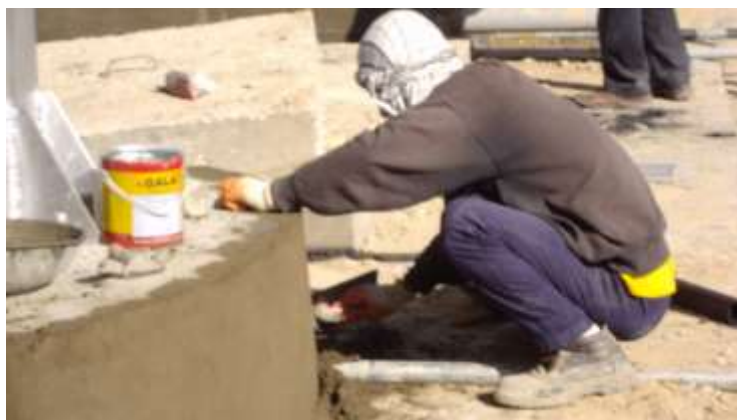
تصویری از بخش پلستر کاری در ساحه
