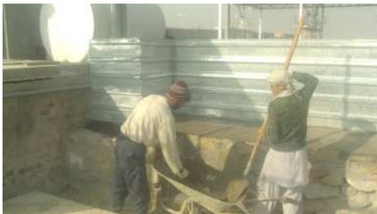
تصویری از ساختمان فلتر خانه
