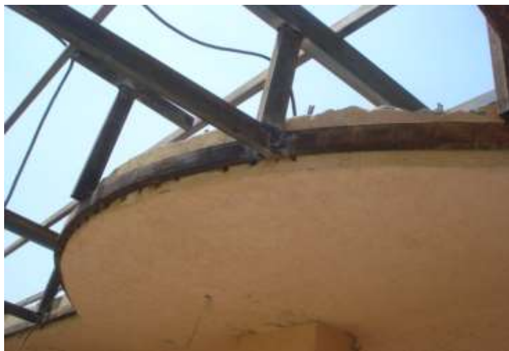
تصویری از نصب پروفیل دایروی
