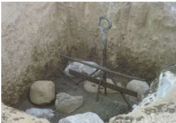
تصویری از نصب حلقه کیپل کش
