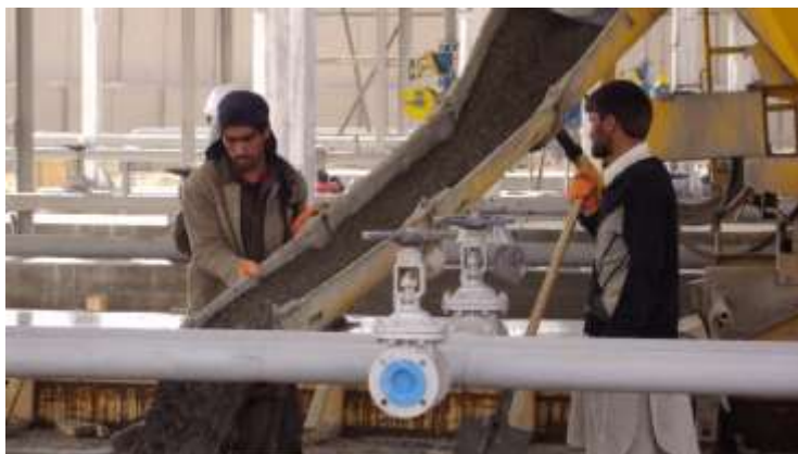
تصویری از کانکریت ریزی در سازه
