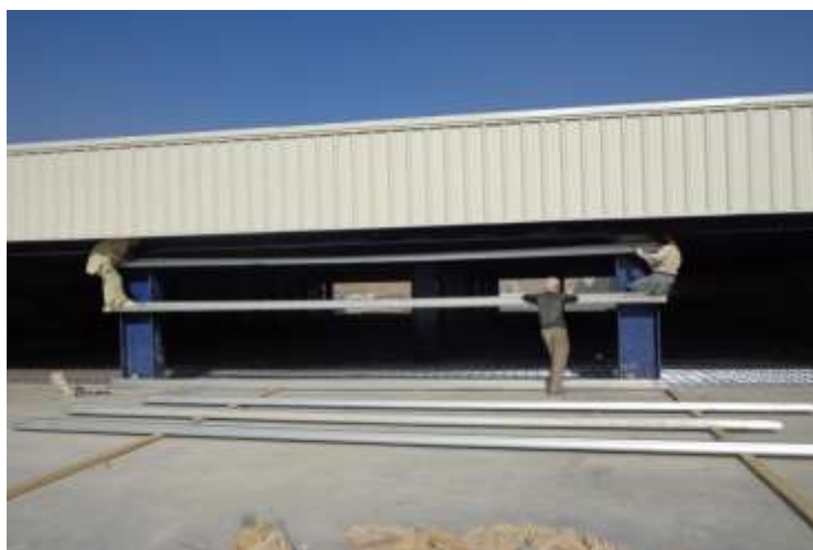
تصویری از نصب چابنل های خارجی
