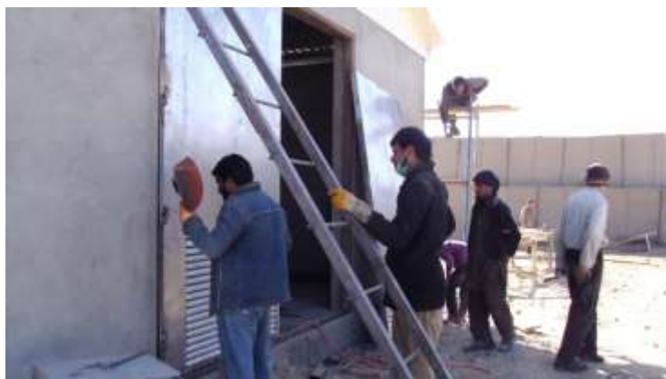
تصویری از نصب دروازه های جنراتور خانه
