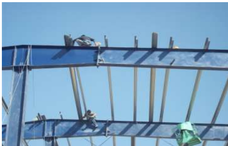
تصویری از نصب چابنل زی پوشش
