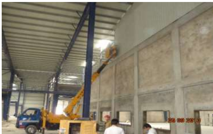
تصویری از نصب دیوارهای فلزی داخلی
