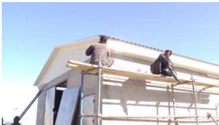
تصویری از نصب لبگرد های جنراتور خانه
