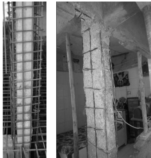
۱- شکل (اوسپنیز کانکریټي تخریب شوی
