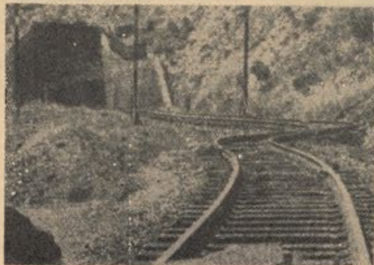
۲- در اینجا ملاحظه می کنیم که بعد از زلزله آگست ۱۹۵۲ گرن کونتی واقع ایالت کلفورنیا، تونل خط آهن ویران و تباب خورده است.
