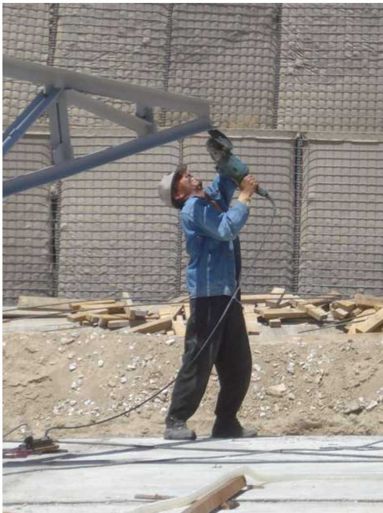
تصویری از چرخ کاری برای نصب ترس ها در ساحه کاری
