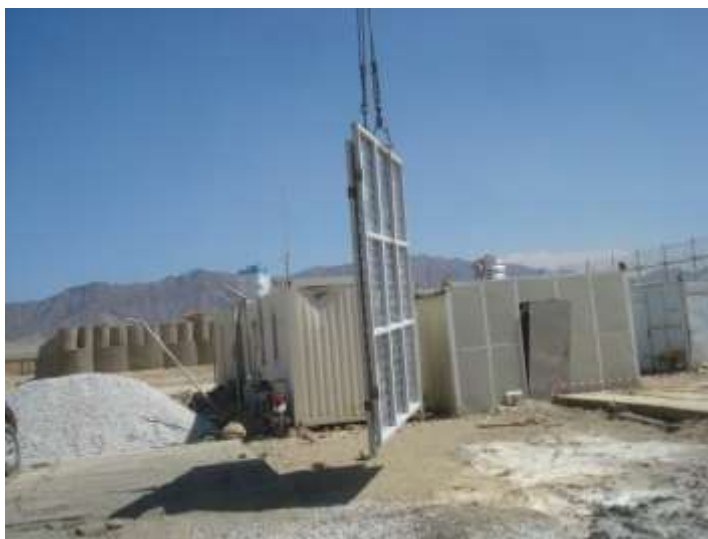
تصویری از پایین نمودن قطعات پیش ساخت در ساحه کاری
