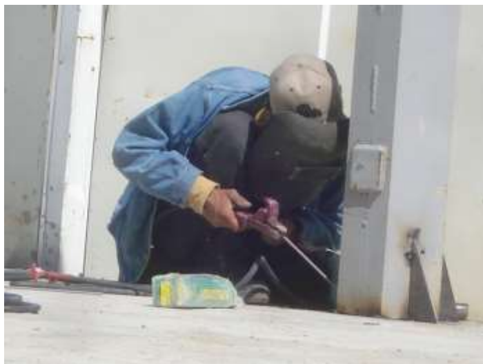
تصویری از پخته کاری پایه ها در ساحه کاری
