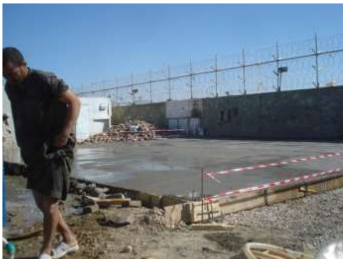
تصویری از ختم کانکریت ریزی
