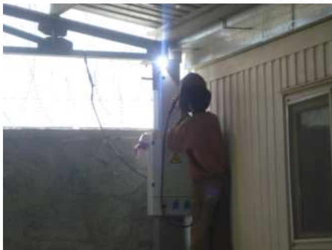
تصویری از نصب آهن چادر در ساحه کاری
