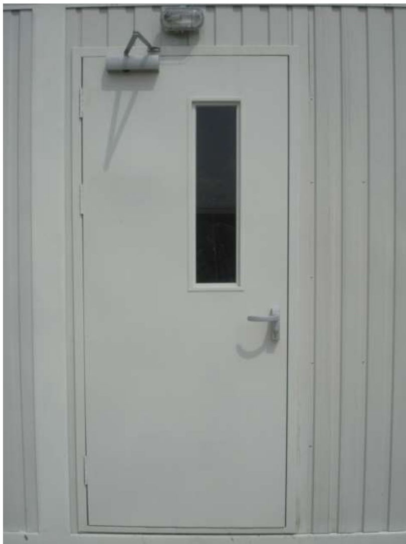
تصویری از قسمت دروازه خارجی (کانتینر)
