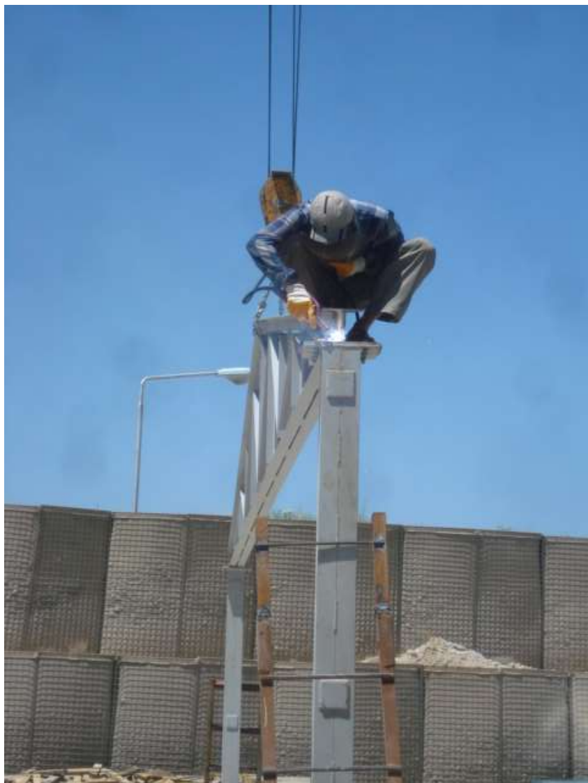
تصویری از نصب ترس ها در ساحه کاری
