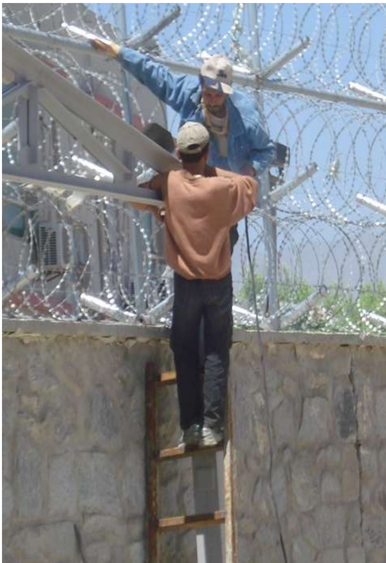
تصویری از پخته کاری ترس بالای پایه ها در ساحه کاری
