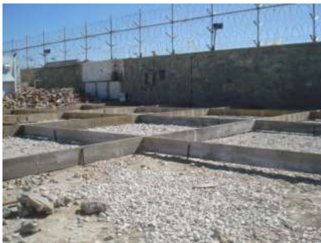
تصویری از قالب بندی داخل ساحه برای ورکشاپ
