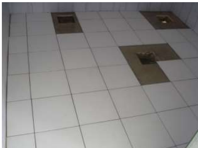
تصویری از نصب کاشی در فرش تشناب کانترینر
