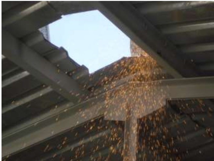
تصویری از برش کاری برای نصب هواکش در ساحة کاری
