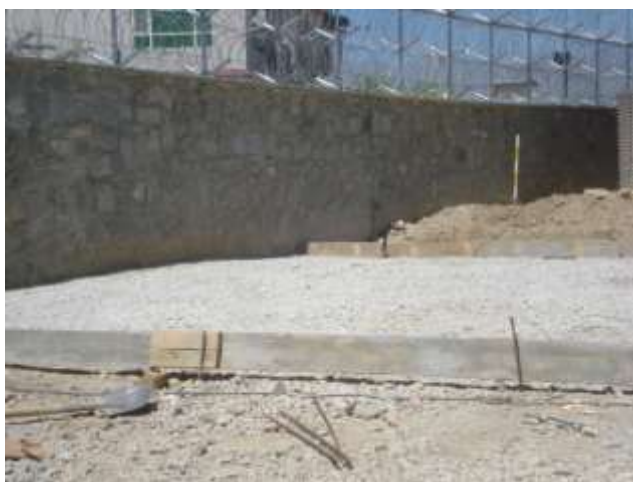
تصویری از قالب بندی اطراف ساحه برای ورکشاپ
