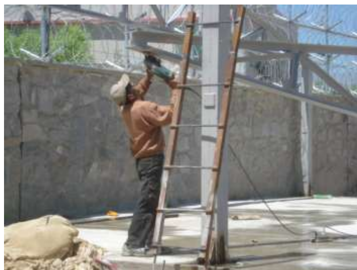
تصویری از نصب ترس ها در سازه کاری
