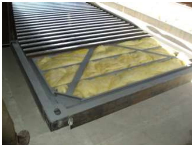
تصویری از عایق کاری حرارتی سقف کانتینر
