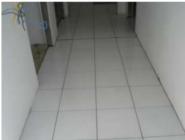
تصویری از نصب کاشی در فرش کانتینر
