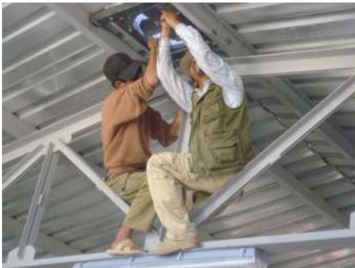
تصویری از نصب هواکش
