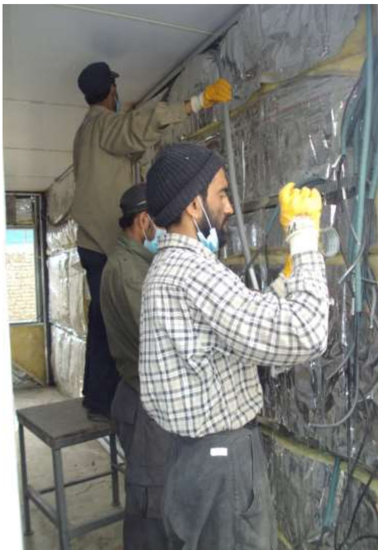
تصویری از عایق کاری حرارتی دیوار کانتینر
