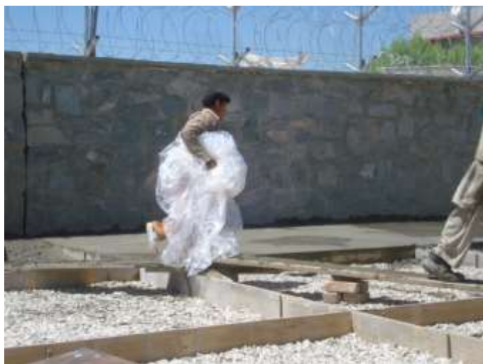
تصویری از همواری کاری پلاستیک قبل از کانکریت ریزی
