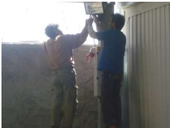
تصویری از نصب چراغ ها در ساحه کاری
