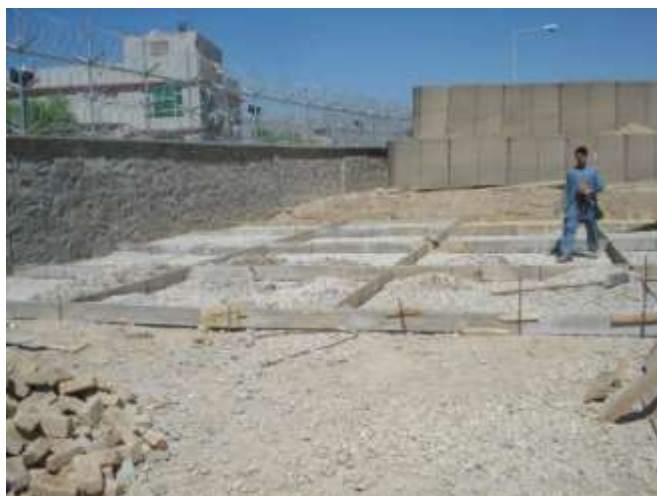
تصویری از کنترل قالب بندی داخل ساحه برای ورکشاپ
