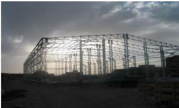
تصویری از نصب پایه های فلزی و ترس ها برای ساختمان فابریکه
