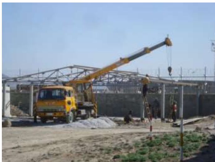
تصویری از نصب ناوه های افقی در سازه کاری
