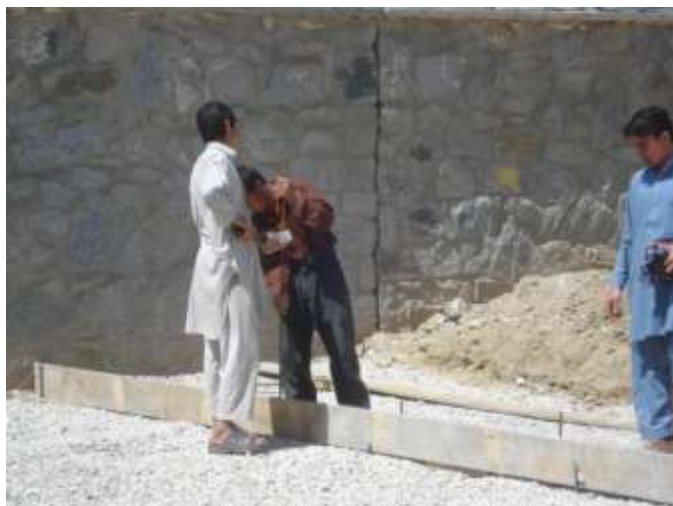
تصویری از قالب بندی ساحه برای ورکشاپ
