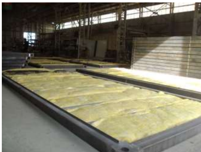
تصویری از عایق کاری حرارتی فرش کانتینر
