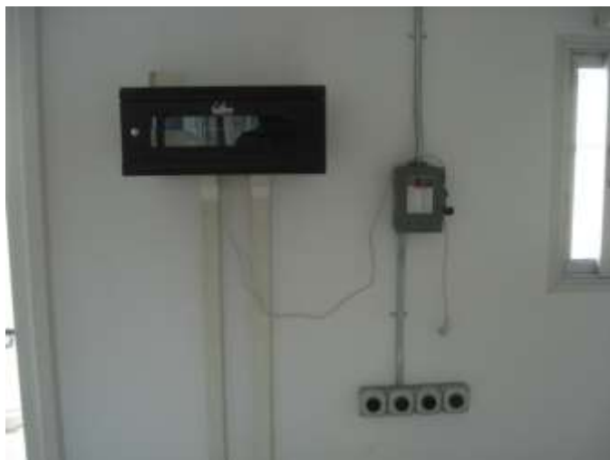
تصویری از تبدیل کننده سیستم برق و بکس اینترنت کانکس (کانتینر)
