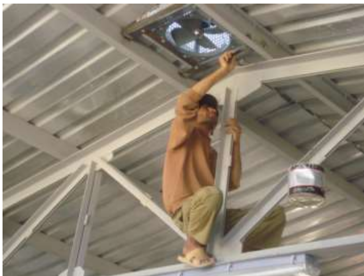
تصویری از نصب هواکش
