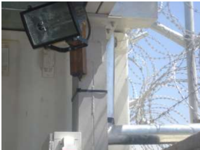
تصویری از نصب چراغ پروجکتور ورکشاپ
