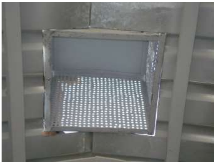
تصویری از نصب بکس هواکش
