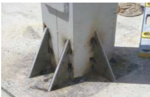
تصویری از محکم بندی پلیت های پایه ها در سازه کاری
