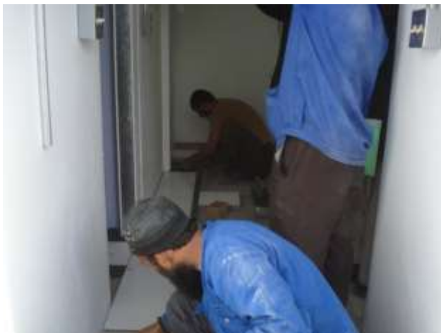
تصویری از نصب کاشی در فرش کانتینر
