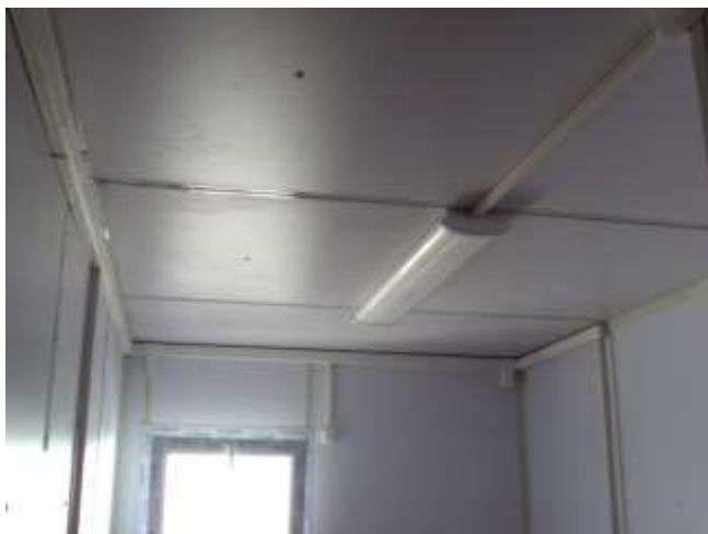
تصویری از نصب چراغ سقفی و کاندویت برق کانتینر
