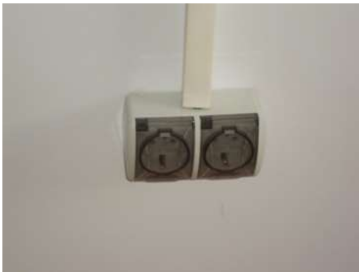
تصویری از نصب ساکت برق کانتینر
