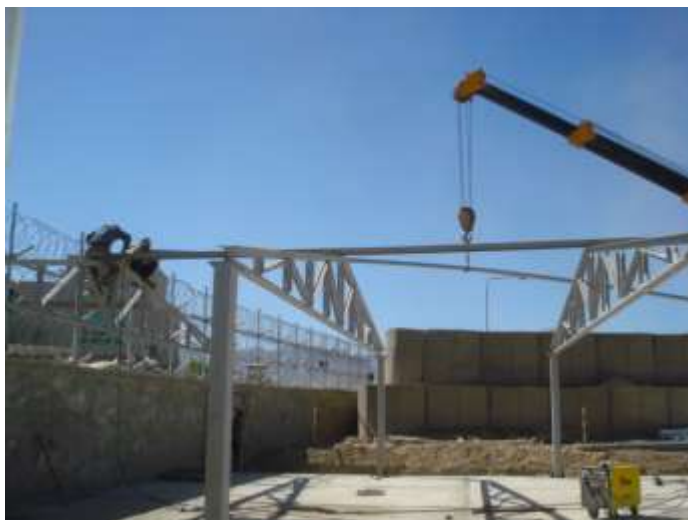
تصویری از نصب گادر های ارتباطی در ساحه کاری
