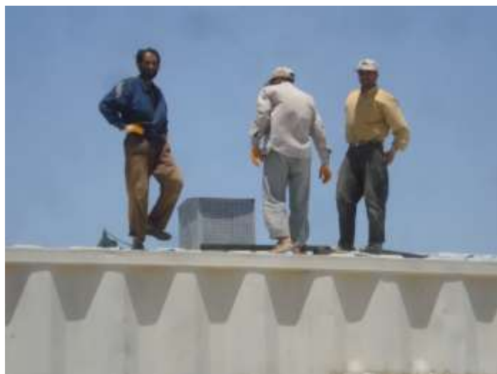
تصویری از نصب بکس هواکش
