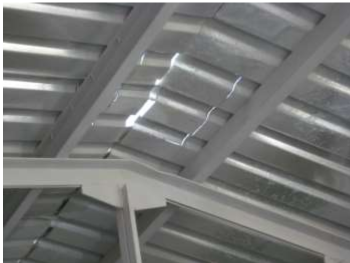
تصویری از آماده گی برای نصب هواکش در ساحة کاری
