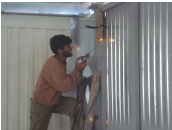
تصویری از نصب براکت برای چراغ ورکشاپ
