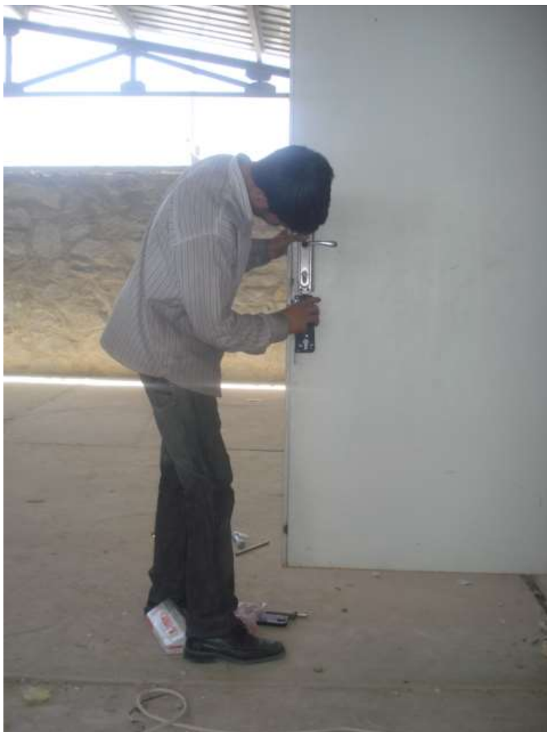
تصویری از نصب دروازه اتاق داخلی ورکشاپ
