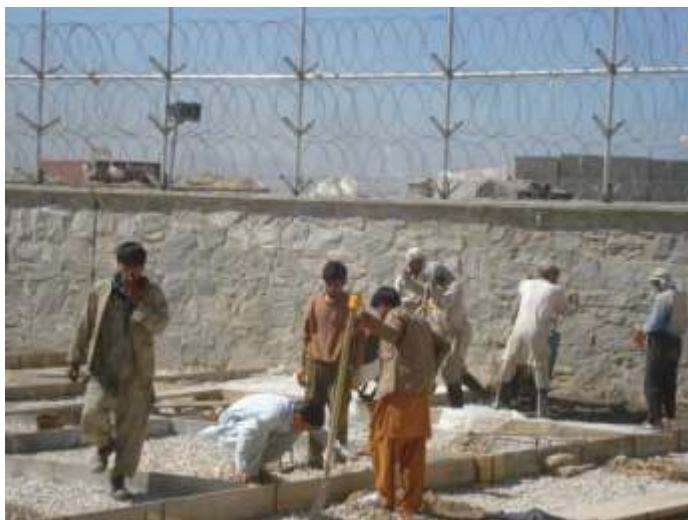
تصویری از چک قالب ها حین کانکریت ریزی
