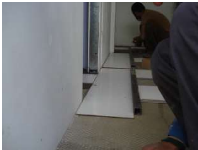
تصویری از نصب کاشی در فرش کانتینر
