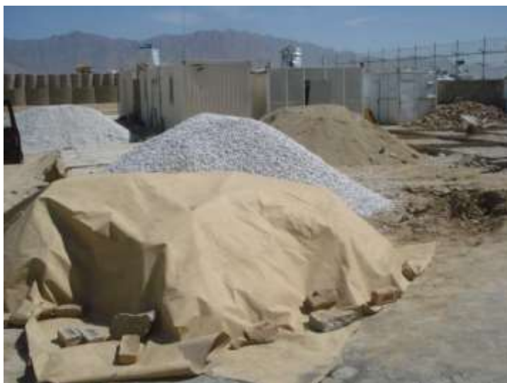
تصویری از آماده گی مواد ساختمانی برای کانکریت فرش ورکشاپ
