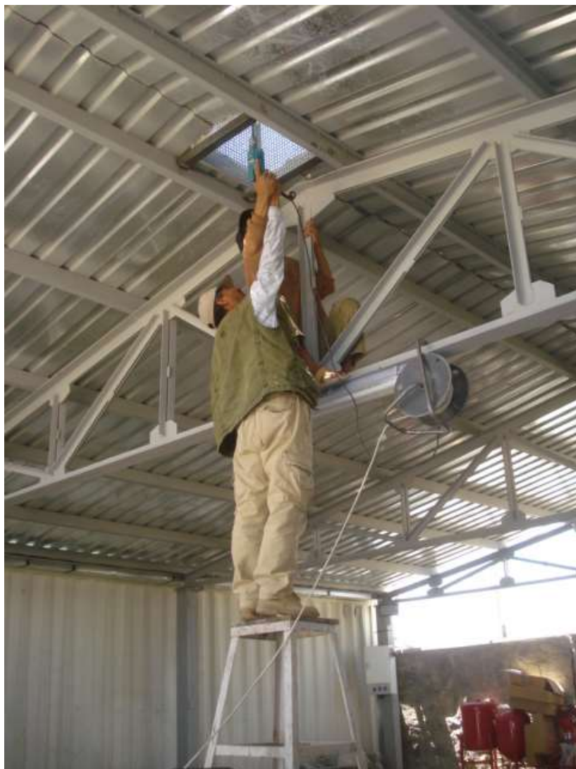
تصویری از نصب هواکش
