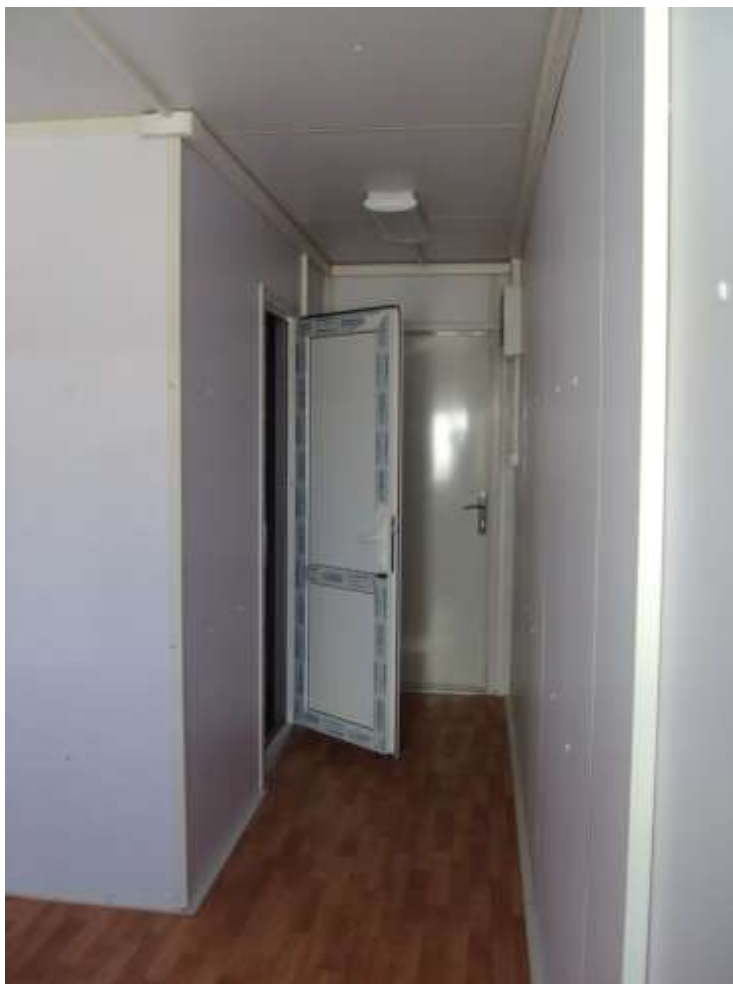
تصویری از نصب دروازه داخلی کانتینر
