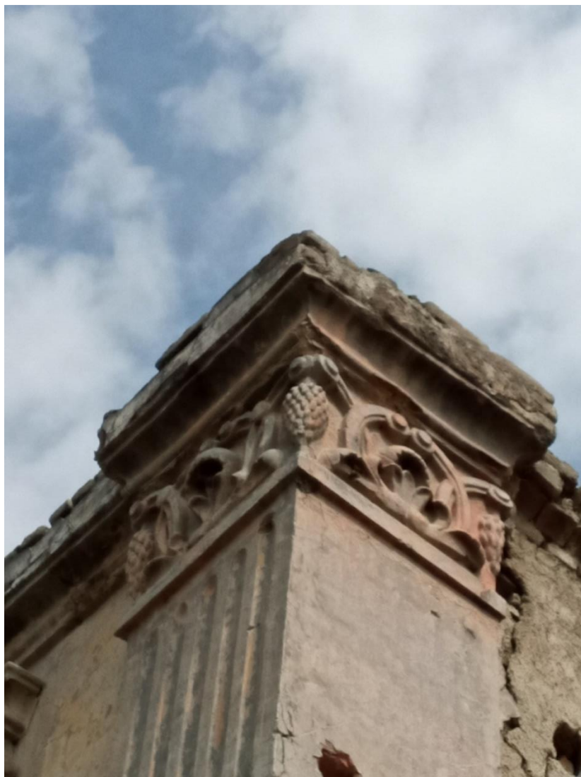
عالی است - مگر بی قدر ( در کابل است )
