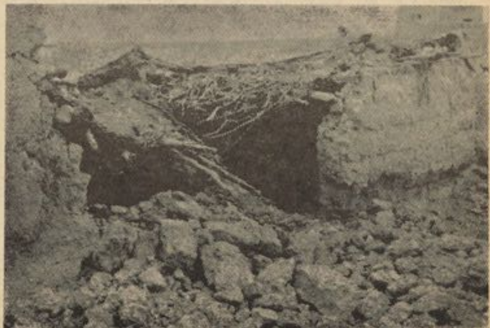
صحنه‌ی از خرابی زلزله در اشکمش
