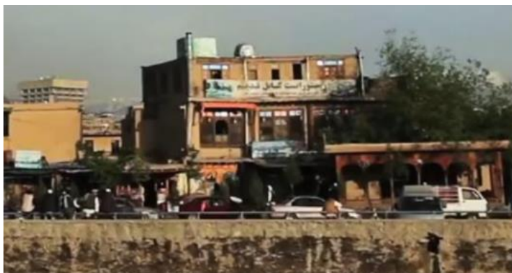
دید هوتل کابل قدیم از سمت سرک
