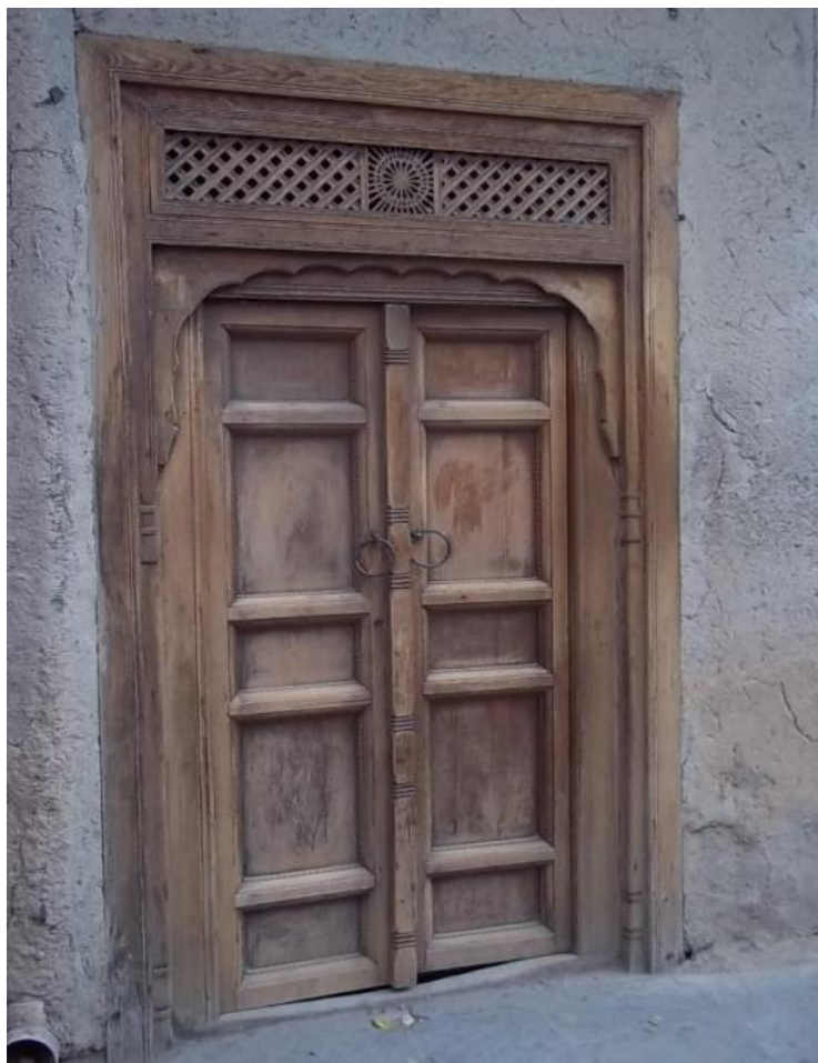
دروازه ادخال زیارت پنج تن
