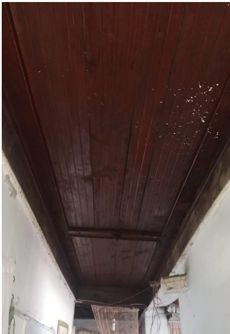
تصویری سقف دهلیز یک خانه ره‌ایش در بی بی مهرو
