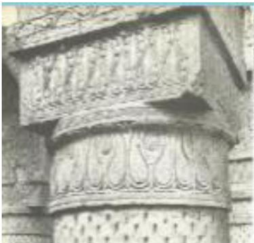
نمای قسمت سرپایه های مسجد نوگنبد
