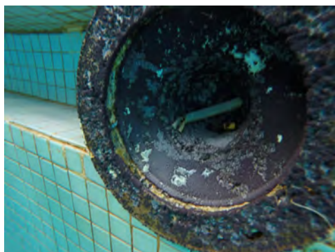
شکل ۵-۴- روشنایی استخر معیوب است و رفع عیب آن باید با رعایت نکات حفاظتی و ایمنی باشد.
