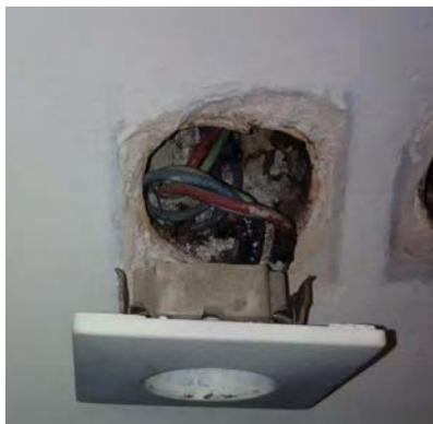
شکل ۵-۳- قاب جداشده پریز از دیوار
