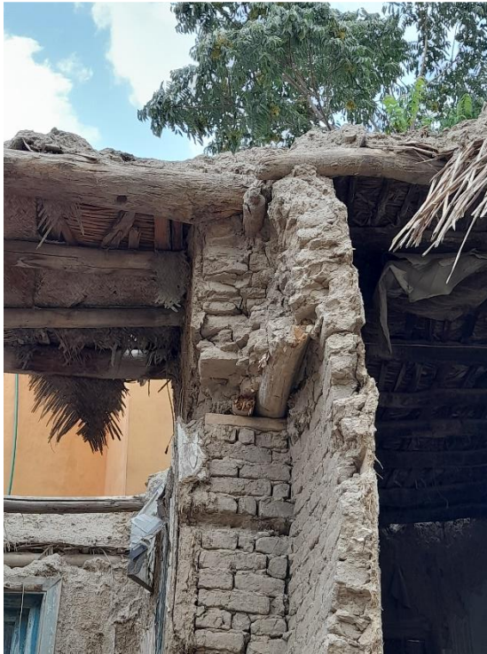
تصویری از عدم توجه به وزن مواد ساختمانی در بام ها و بافت اتاق ها
