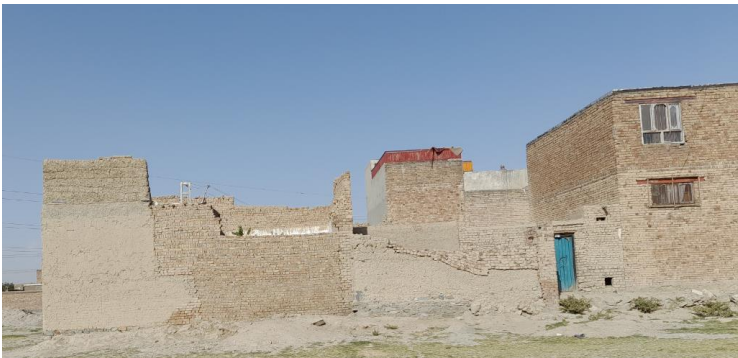
تصویری از عدم موجودیت تدابیر دفاعی برای تهداب ها و استفاده مواد نادرست ساختمانی به اساس وزن
