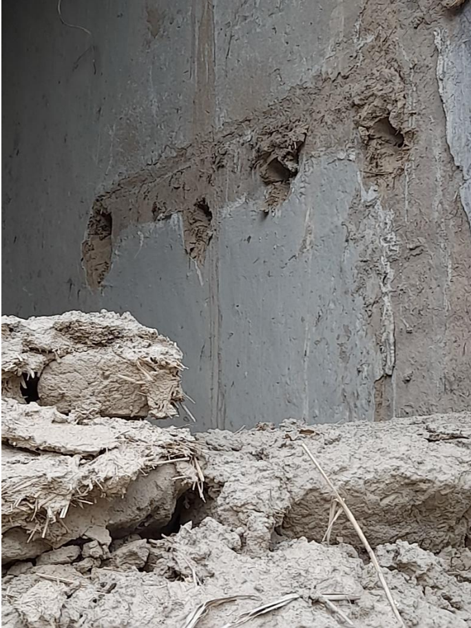
تصویری از عدم رعایت اصول دستک بندی پوشش
