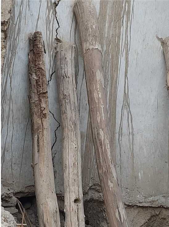
تصویری از عدم تدابیر دفاعی برای چوب دستک در قسمت اتصال بالای دیوار ها
