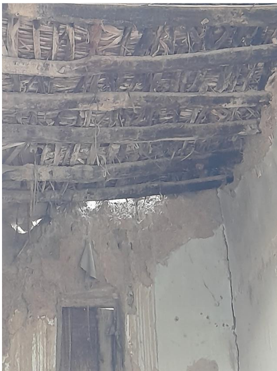
نمونه از عدم استفاده سائیز و قطر درست چوب دستک در پوشش ها
