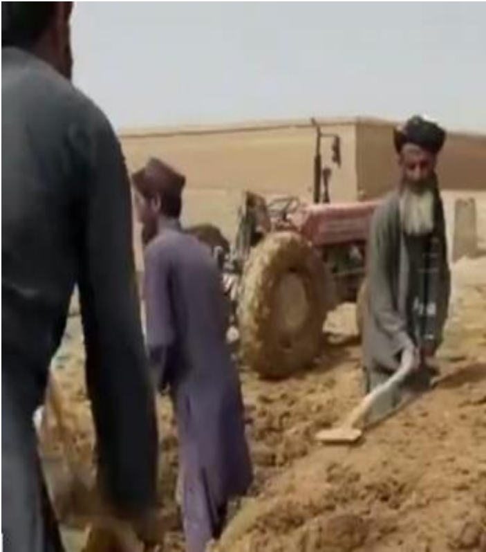
طریقه پخته کردن گل برای پخسه توسط تراکتور
