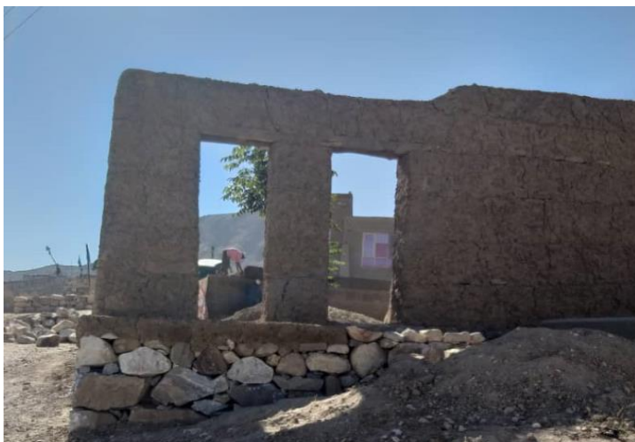
تصویری از دیوار پخسه‌یی با غرقه و کرسی سنگ کاری
