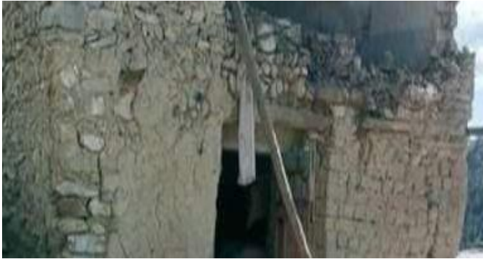
تصویری از عدم استفاده درست مواد ساختمانی به اساس سختی و بافت
