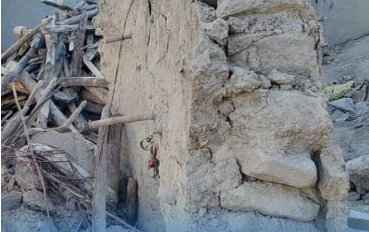
تصویری از عدم موجودیت تدابیر دفاعی برای تهداب ها و استفاده مواد نادرست ساختمانی به اساس وزن
