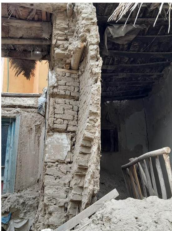
نمونه از عدم موجودیت بافت خشت کاری در دیوارهای وزن بردار
