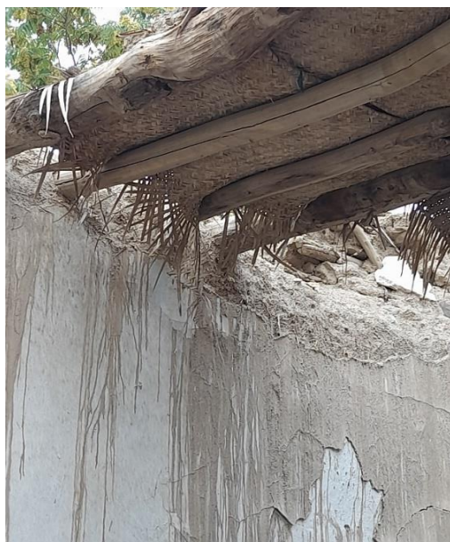
نمونه از عدم استفاده سائز و اندازه درست چوب دستک در پوشش ها
