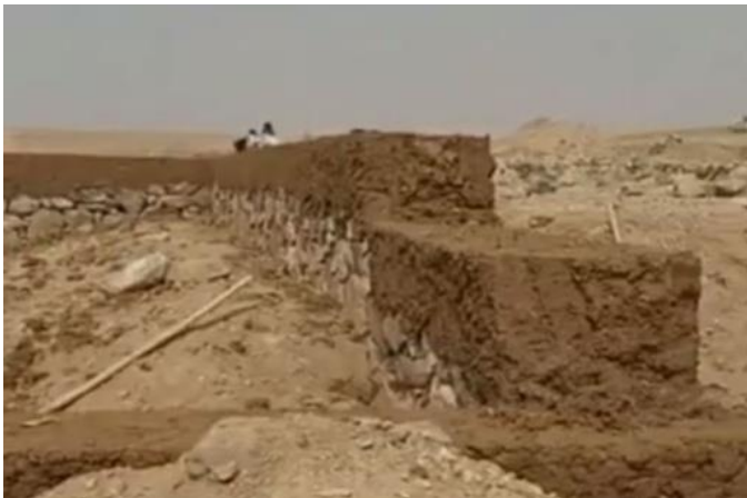
تصویری از دیوار پخسه یی با غرقه و کرسی سنگ کاری
