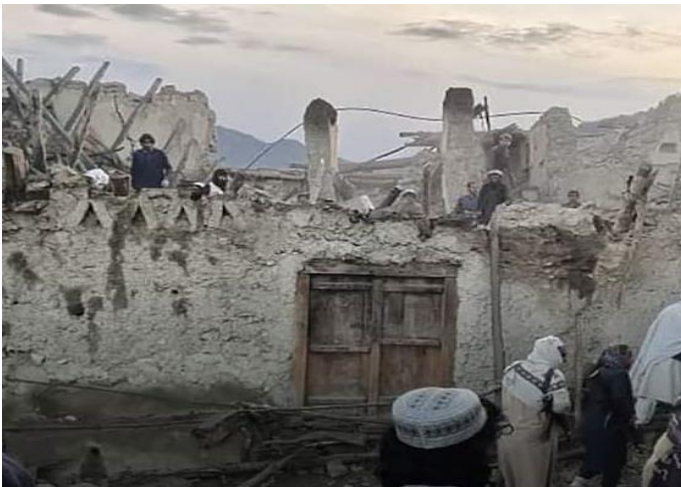
تصویری از عدم استفاده موثر و درست از تخت بام ها
