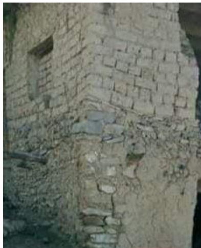
تصویری از عدم استفاده درست مواد ساختمانی به اساس سختی و بافت
