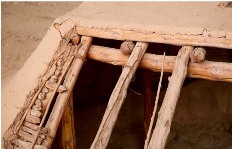
تصویری از باز سازی پوشش بام در شهر کهنه کابل
