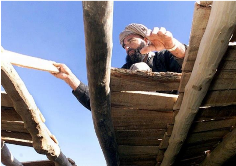
تصویری از باز سازی پوشش بام در شهر کهنه کابل
