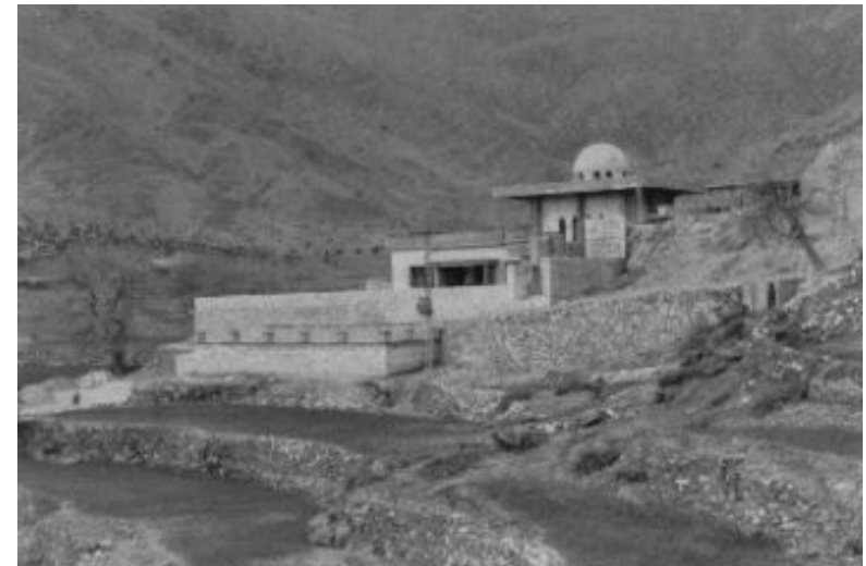
مسجد غازی آباد
