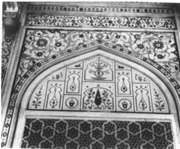
مشبک های ورودی
