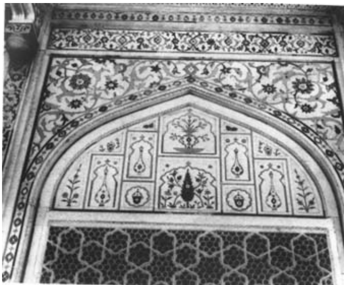
مشبک های ورودی
