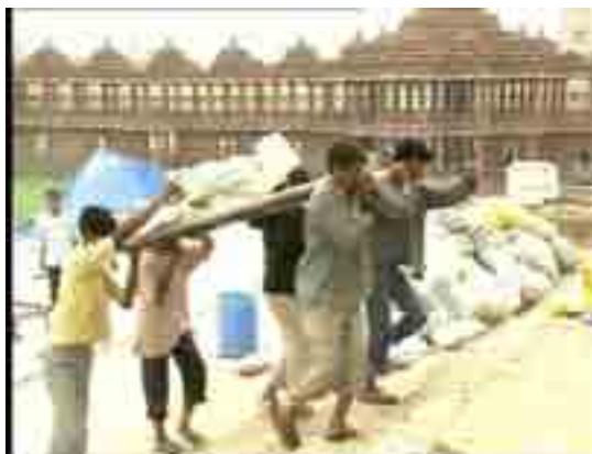
سازندگان آخشاردام تکه سنگ تراشیده ای را بر دوش خود به محل نصب آن حمل می کنند.
