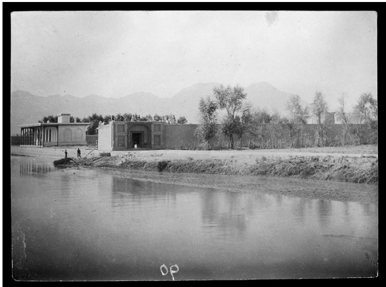
بگرامی - شرق کابل
