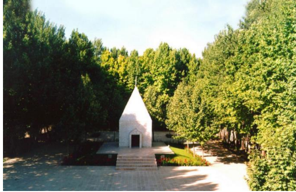
مقبره «نورعلی الهی» در هشتگرد که به ساختمان یک کلیسا شبیه است.
