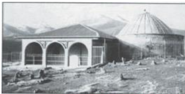
ضلع جنوب شرقی مقبره خاندان مشعشی، در گره‌بان کرمانشاه
