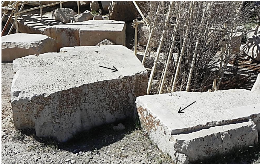
به قسمت‌های نیمه تراش و خط اندازی شده روی این سنگ‌ها دقت کنید.
