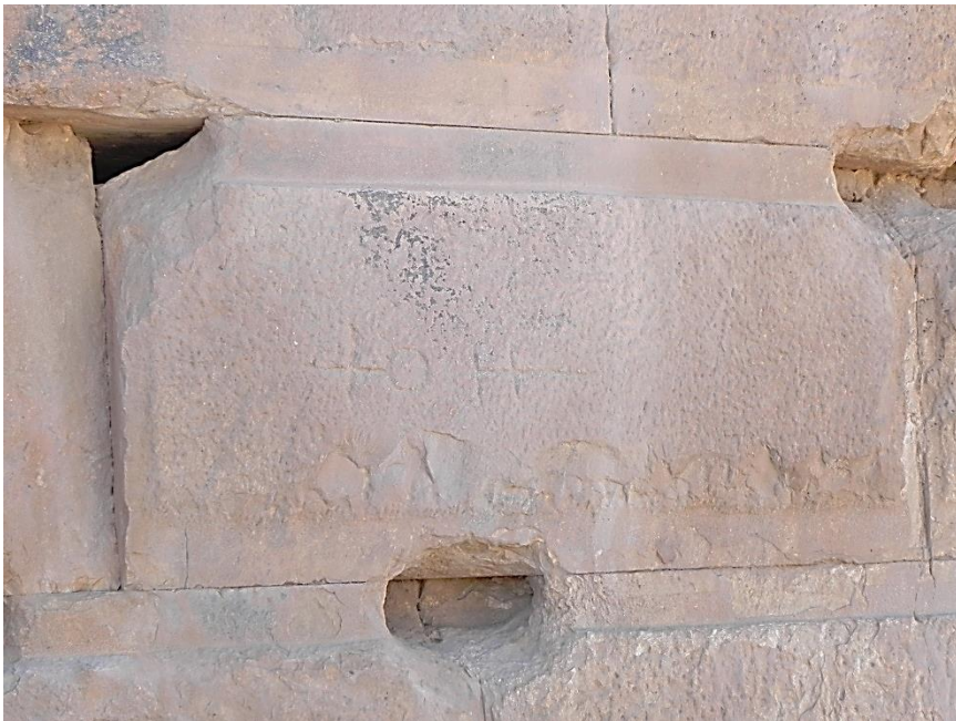
هیچ منطقی قبول نمی‌کند که قرار دادن بست‌های آهنی در این سوراخ‌های سطحی ایجاد شده در سنگ موجب استحکام بنای آن باشد.
