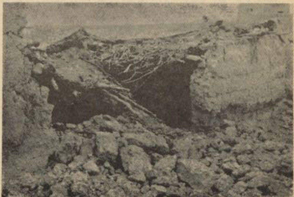
صحنه‌ی از خرابی زلزله در اشکمش
