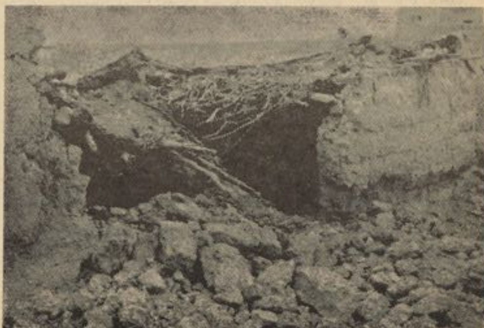
صحنه‌ی از خرابی زلزله در اشکمش
