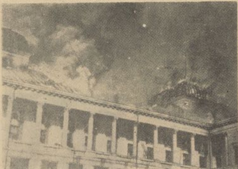
در وقتی که حریق مدهشی در قصر رخداد
