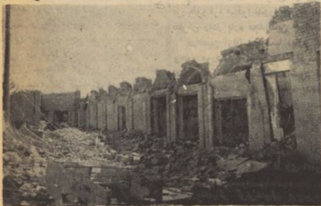
گوشه ای از خرابی های زلزله
