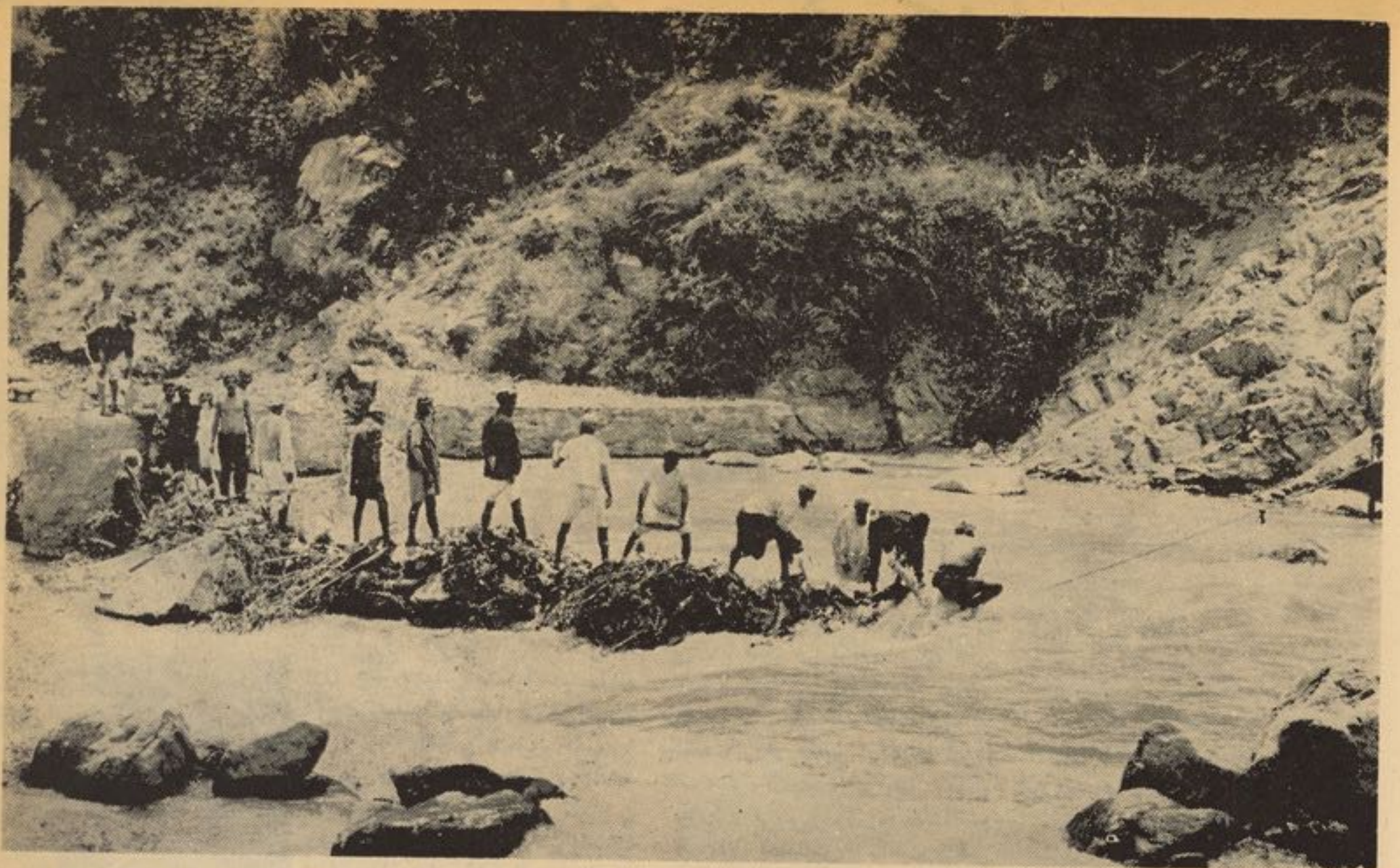
در کشور ما، زراعت و کشت و کار بیشتر متکی به آبهای جاریست، اکنون در چوکات انکشاف دهات برای استفاده مطلوب از آب دریا بندهای آبگردان مؤقتی نیز به کمک اهالی ساخته می شود تا زمین های زراعتی بطور کافی و علمی آبیاری شود. عکس فعالیت پروژه دهات را درین زمینه در پروان نشان می دهد.
