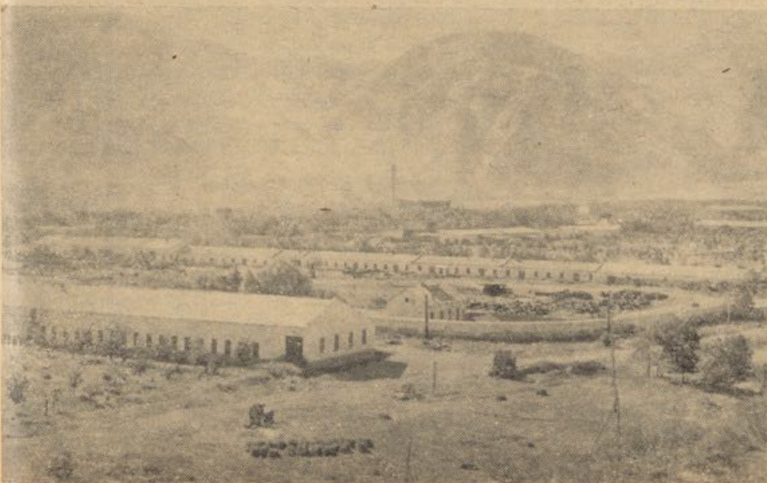
دور نمای از تا سیسات نساجی گلپهار در منطقه شیر خانخیل که بر قسمتی از بگرام مشرف است
