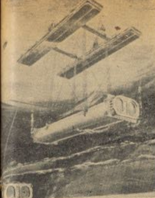
کشتی بزرگی يك حصه از تيوب بزرگ ترانسپورت مي راند در عمق جهيل با نين مي سازد .
