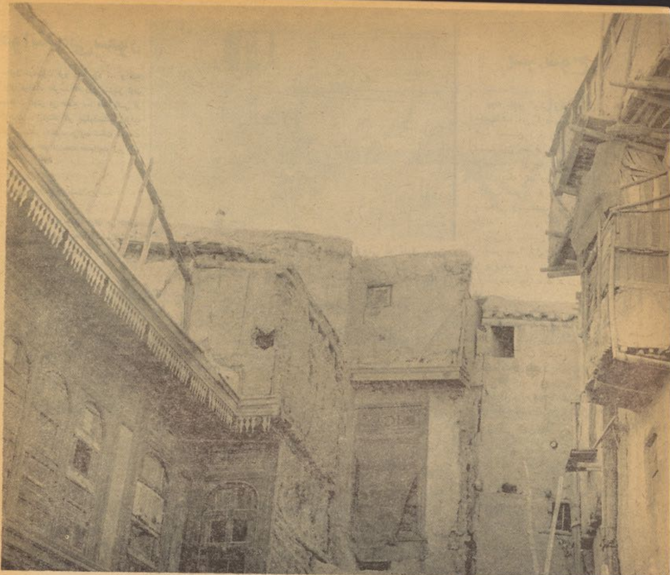
این عکس نمایانگر یکی از ساختمانهای قدیم کابل است که در آن طرز کارارسهاحواشی و کندن کاری با دقت زیاد انجام گرفته است .
