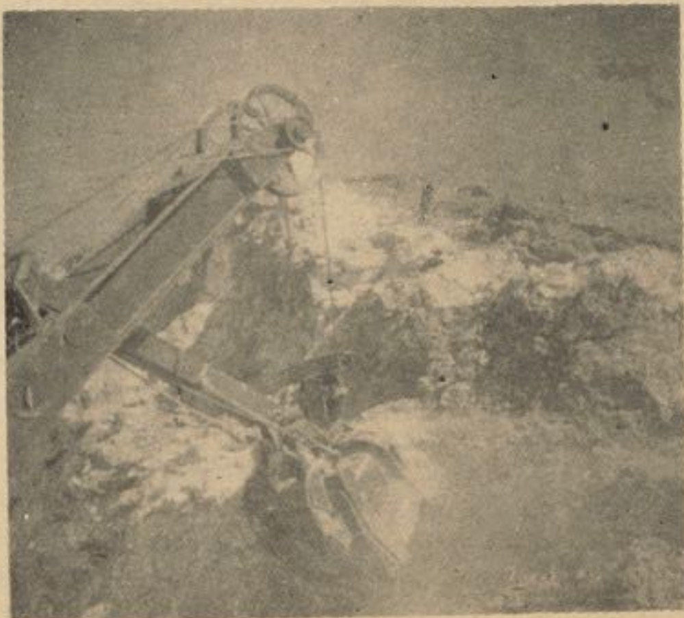
استخراج بیرایت بعد از انفلاق توسط اسکواتر در بالای رگ (۵)
