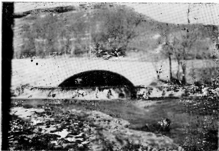
تعمیر پل جدید ۹ برجہ غزنی
