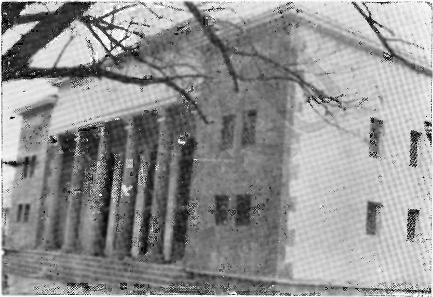
پاک حصہ تعمیر جدید سمت شمالی محکمہ عدلیہ ولایت کابل
