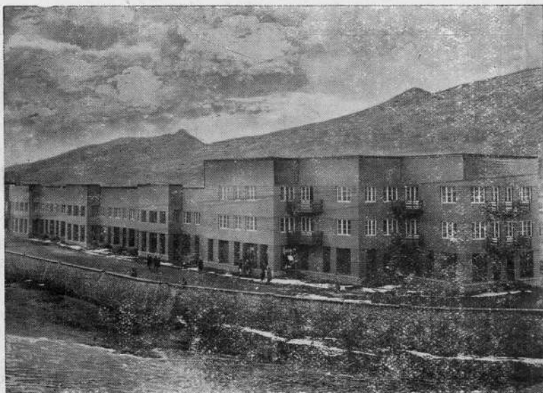
منظره عمومی آپارتمان های جدید که در لب دریای کابل در ۱۳۱۸ ساخته شده
