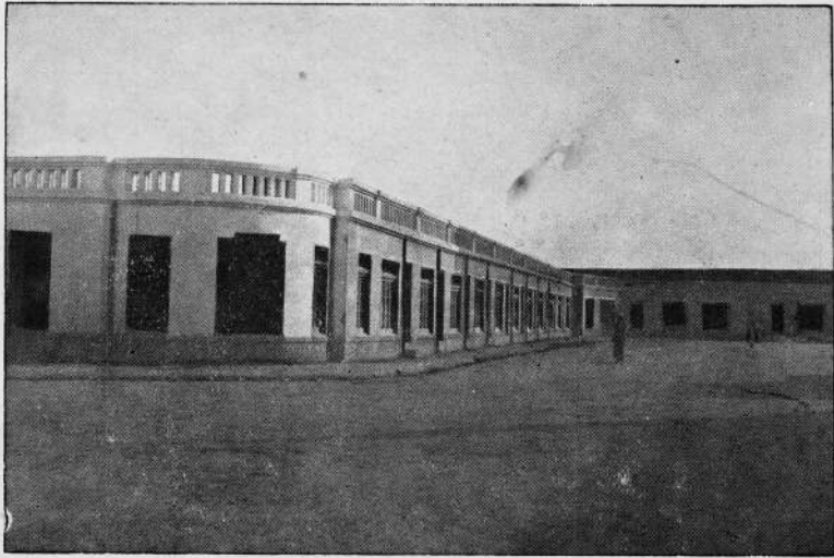
جاده شرقی و جنوب شرقی روضه شریف با دکانهای جدید تعمیر آن
