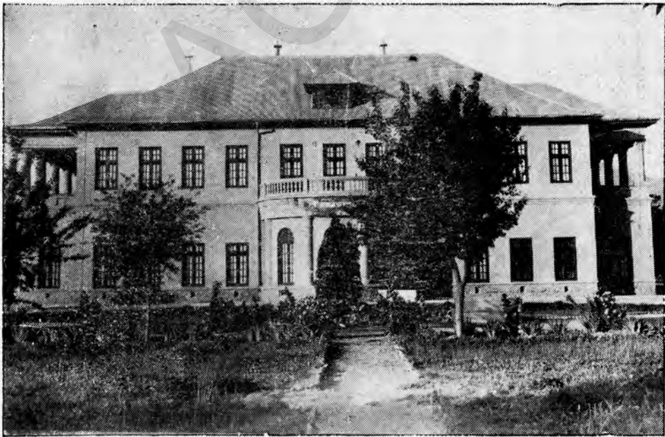
عمارت کلوب عسکری در کابل
