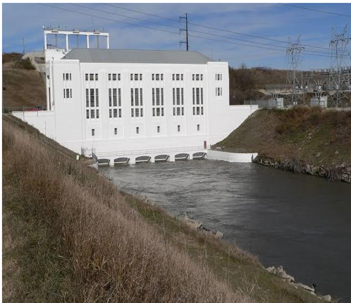
4.7 انځور: خروجي کانال (Tailrace Canal)
